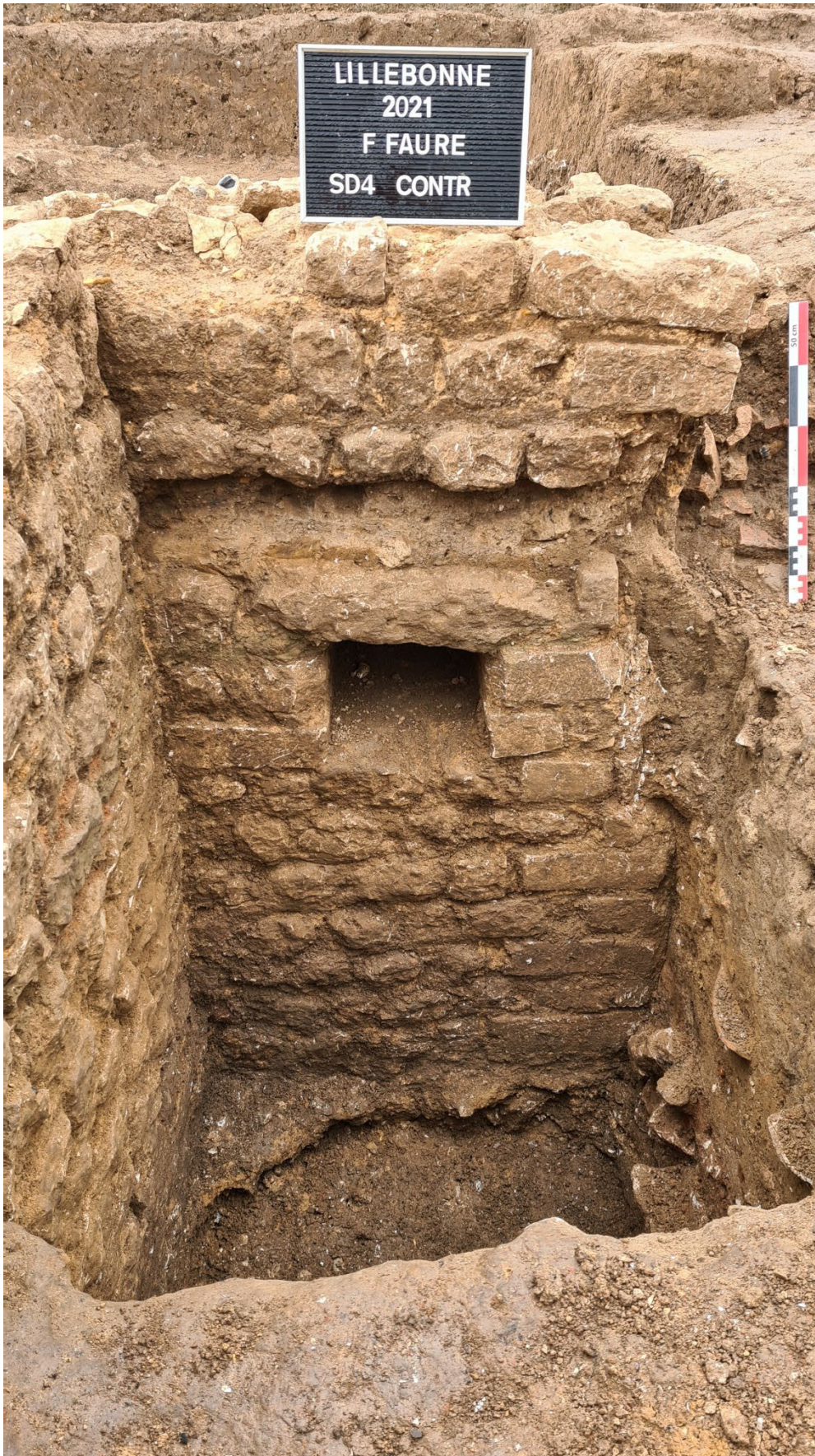
Fig. 96 : Photographie du parement sud du contrefort du mur 2 qui a été percé au milieu pour y installer une canalisation (Str. 5) © J. Spiesser
