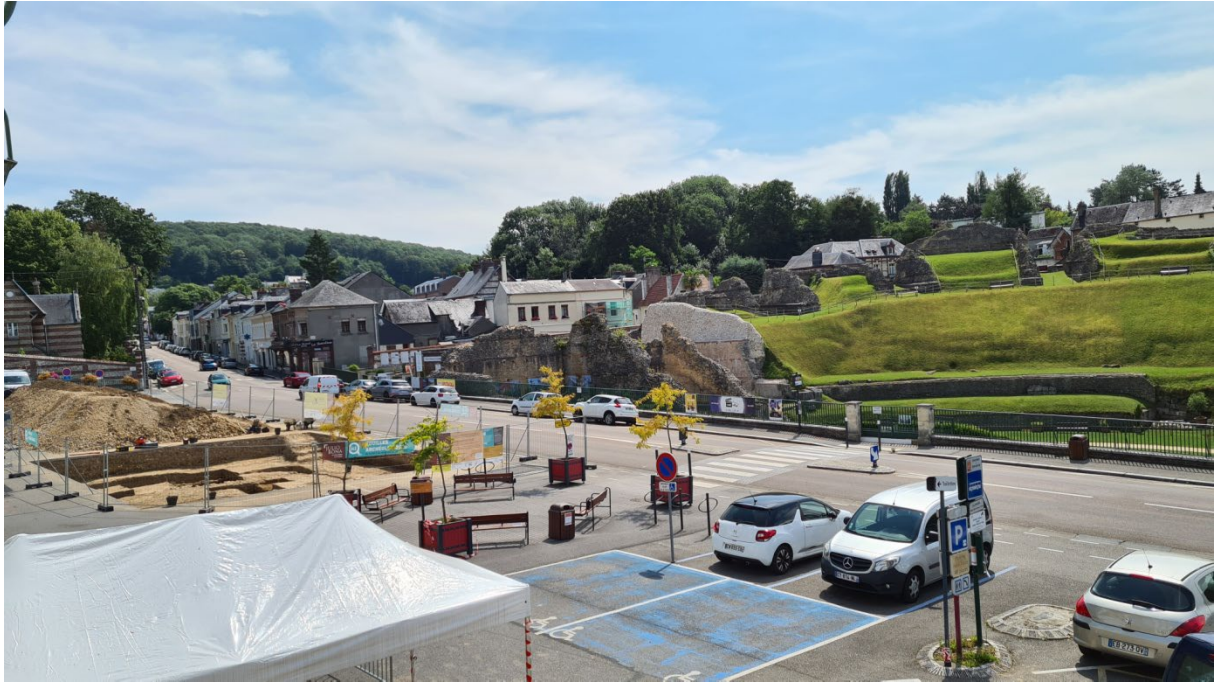
Fig. 56 : Vue du chantier depuis le bureau du local de fouille © J. Spiesser
