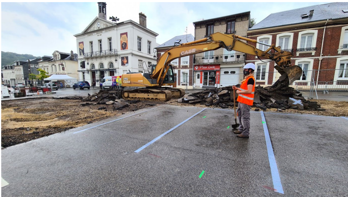
Fig. 57 : Retrait de l'enrobé avant sa mise en décharge © J. Spiesser
