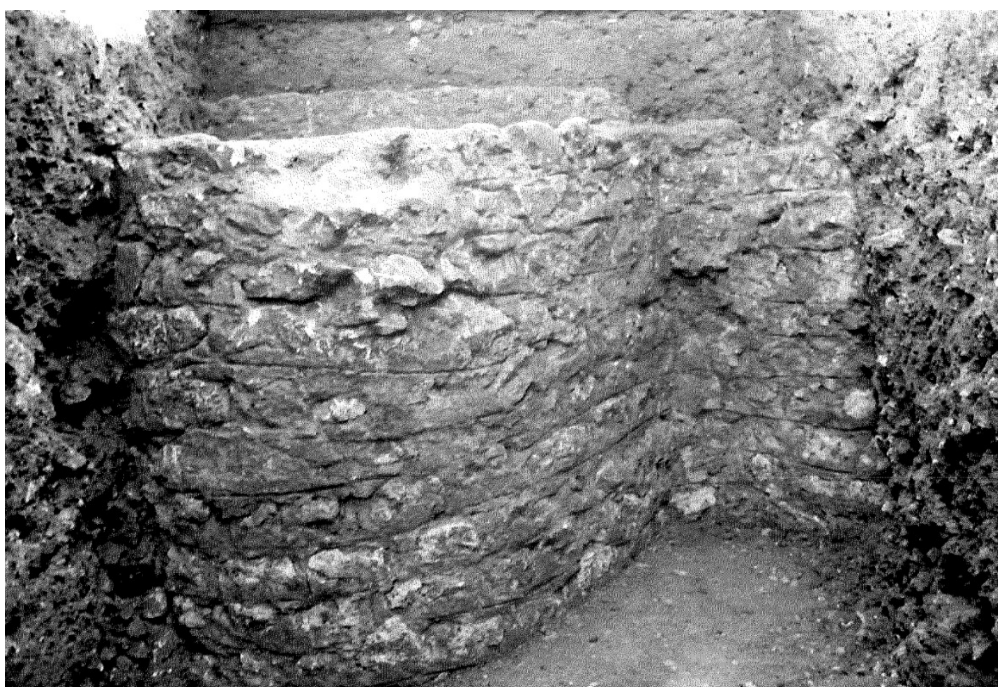
Fig. 35 : Photographie du parement externe du mur 5 © Follain 1986
