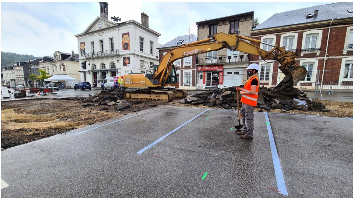
Fig. 57 : Retrait de l'enrobé avant sa mise en décharge © J. Spiesser
