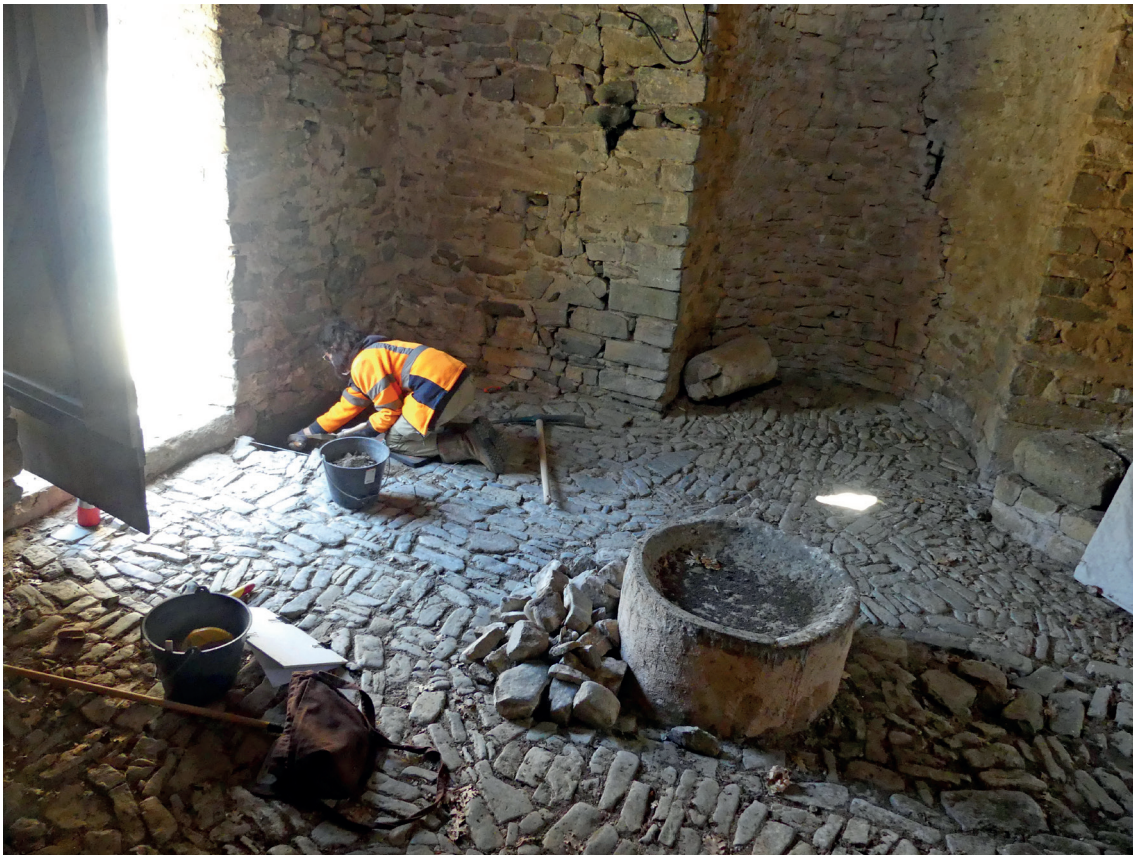
Figure 46. L'élévation interne et homogène du baptistère. L'angle nord-ouest du monument, vu du sud-est.
