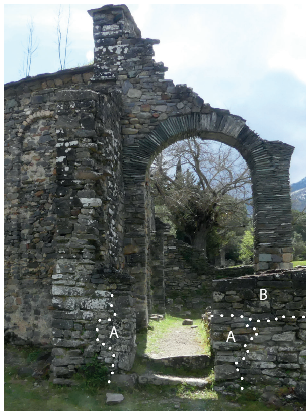
Figure 50. Travaux récents à l'extrémité nord-est de la nef de l'église. A : insertion des montants d'une porte (sans doute sans couverture). B : dernière reprise du mur gouttereau septentrional. (© Inrap, cl. C. Ranché, F. Soula)
