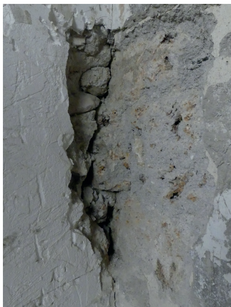
fig. 12 L'extrémité 1025 du mur occidental de la maison du 3 place du Mazel au premier étage, vue du sud-est : reprise ou chantier initial ?
