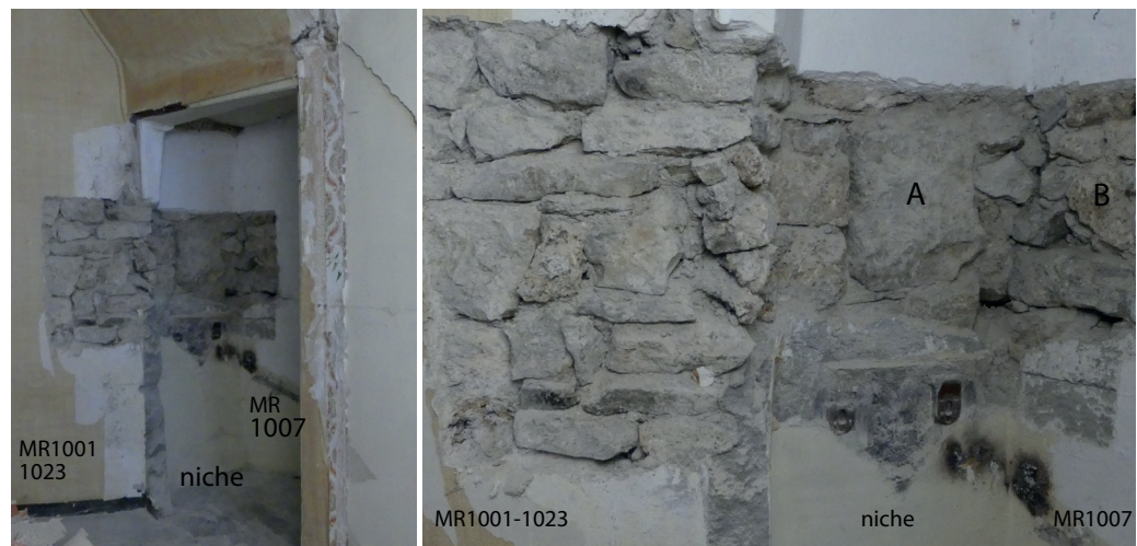
fig. 18 Les maçonneries dans l'angle sud-ouest de la maison du 5 place du Mazel, au 1 er étage, sous la cage d'escalier montant au 3 e . La vue est prise du nord-est. À droite, le mur MR1007 de la maison voisine de l'ouest et à gauche la façade méridionale MR1001 (ici US 1023) évidée d'une niche. A : chaînage d'extrémité du mur MR1001. B : maçonnerie d'obturation de fenêtré.
