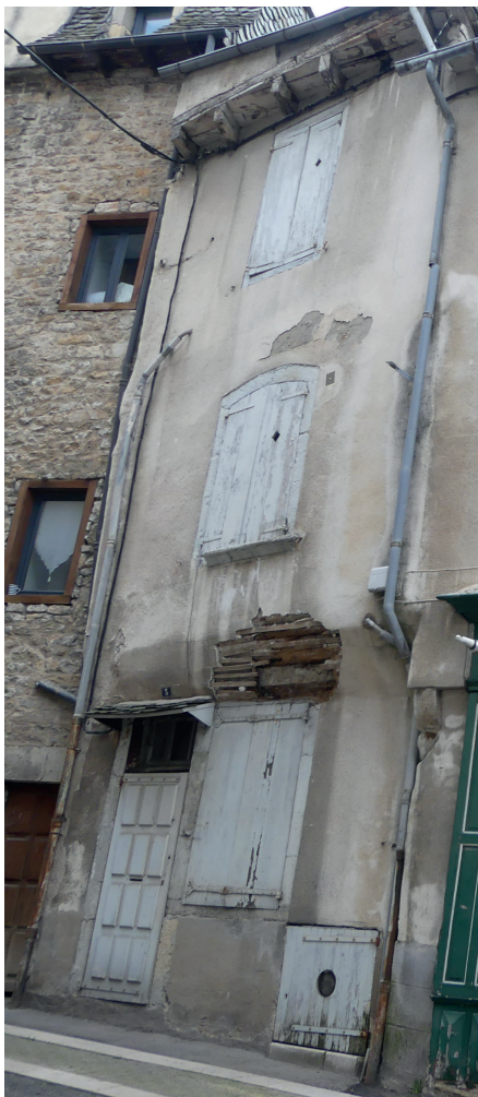
fig. 5 La façade principale MR1028 de la maison du 3 place du Mazel, au nord, avec son encorbellement du 1 er étage.
