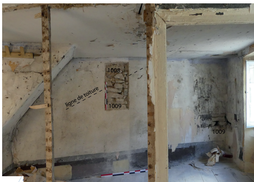
fig. 20 Le mur MR1007 au 2 e étage, vue de l'est (de la maison du 5 place du Mazel) avec sa maçonnerie 1009 interrompue par une ligne de toiture. Après arrachement de la toiture, le mur a été régularisé par la maçonnerie 1008.
