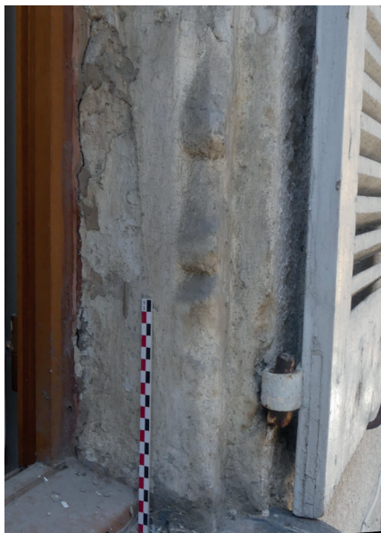
fig. 27 Détail des restes de moulure et de décor à la base du montant de la fenêtre 1031, noyés sous deux épaisseurs de peinture.
