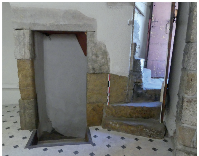
fig. 32 Les organes de la circulation dans l'angle nord-ouest de la pièce 03, vus de l'est. À gauche la porte 1016 d'accès à l'escalier ES1017 de la cave. À droite le piédroit 1014 de la nouvelle vitrine. Au centre : au premier plan les 2 marches de l'escalier ES1015 d'accès à l'entrée, au second plan le palier de l'entrée à droite et les premières marches de l'escalier droit montant à l'étage..
