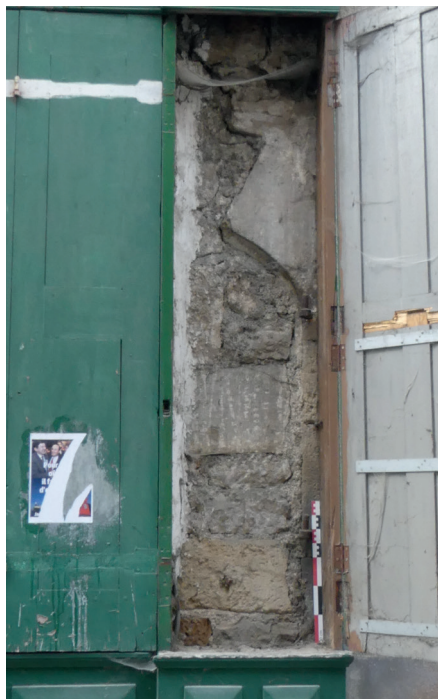
fig. 22 Le piédroit et le départ de l'arc 1033 d'une ancienne ouverture au rez-de-chaussée, en façade principale.
