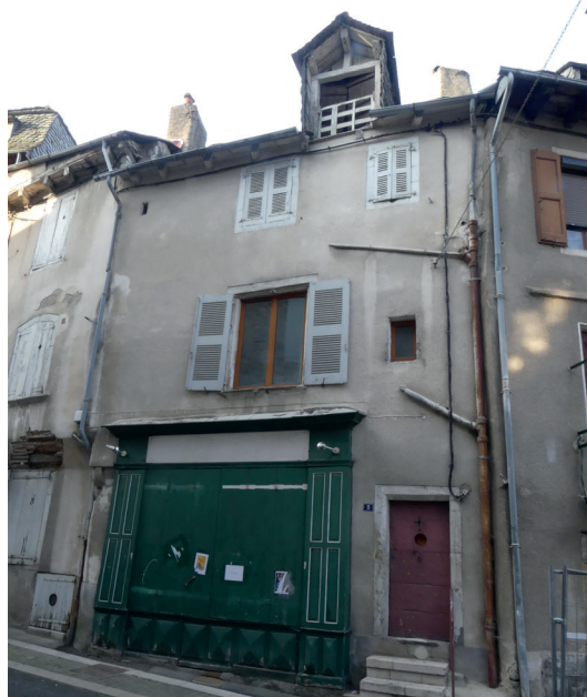
fig. 21 La façade MR1003 de la maison du 5 place du Mazel, avec ses volets verts, adossée aux maisons du 3 (à gauche) et du 7 (à droite).
