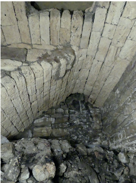
fig. 8 La voûte VT1024 de la cave C1, sous la rue et sa trappe d'accès depuis la chaussée (aujourd'hui obstruée). Vue de l'est.
