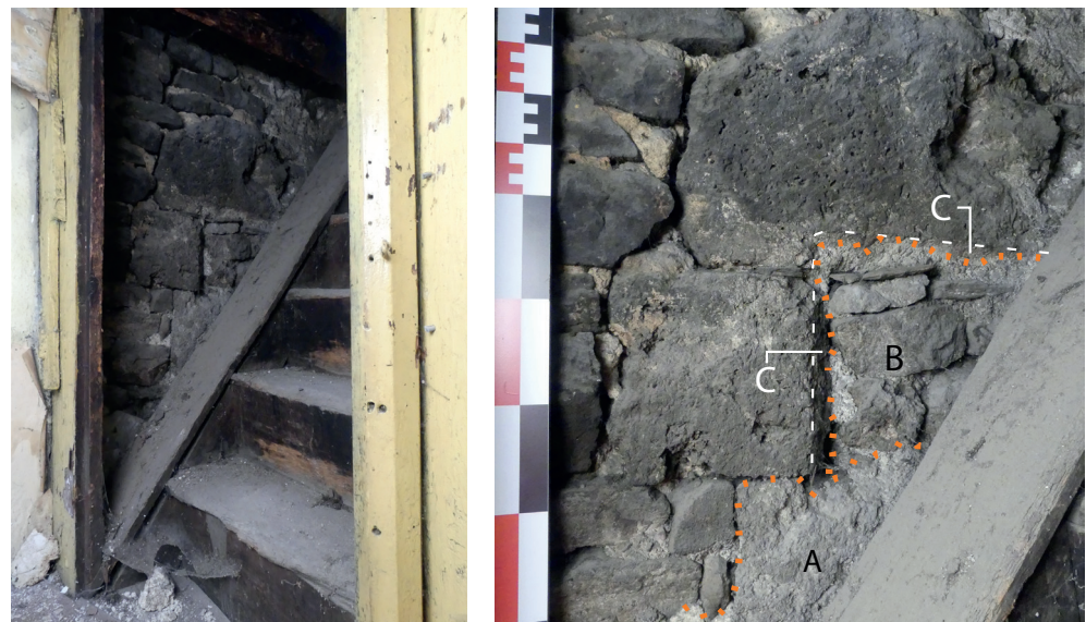
fig. 18 Les maçonneries dans l'angle sud-ouest de la maison du 5 place du Mazel, au 1 er étage, sous la cage d'escalier montant au 3 e . La vue est prise du nord-est. À droite, le mur MR1007 de la maison voisine de l'ouest et à gauche la façade méridionale MR1001 (ici US 1023) évidée d'une niche. A : chaînage d'extrémité du mur MR1001. B : maçonnerie d'obturation de fenêtr.
