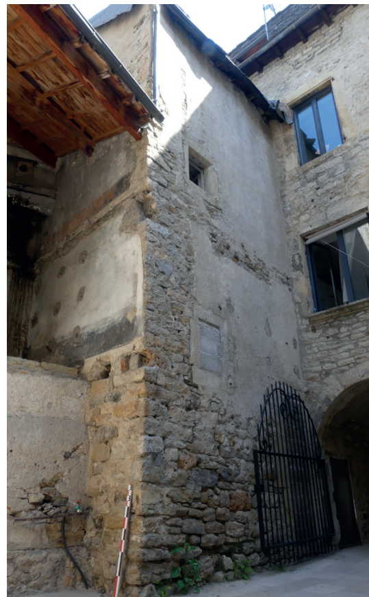
fig. 7 La façade arrière MR1026 de la maison du 3 place du Mazel, au sud, avec ses fenestrons apparemment décalés par rapport aux planchers, signalant sans doute l'emplacement d'un escalier en vis dans l'angle interne sud-ouest de la maison. Vue du sud-ouest.
