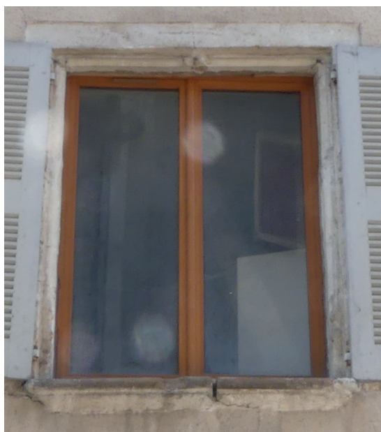
fig. 26 La fenêtre 1031 au premier étage de la façade principale MR1003.
