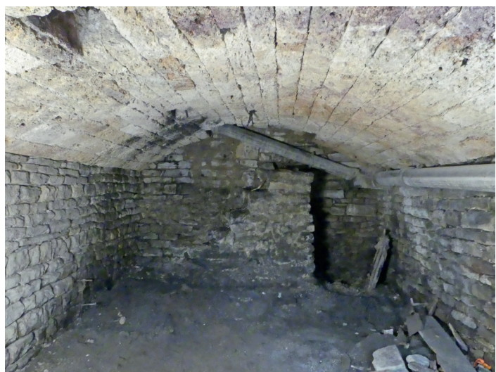
fig. 9 La cave C2 vue du nord, avec sa voûte VT1022 et au fond son escalier d'accès.
