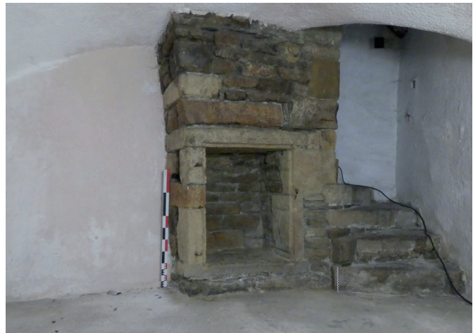
fig. 31 Partie occidentale de la cave C3, vue de l'est, avec l'escalier ES1017 d'accès et la niche 1027.
