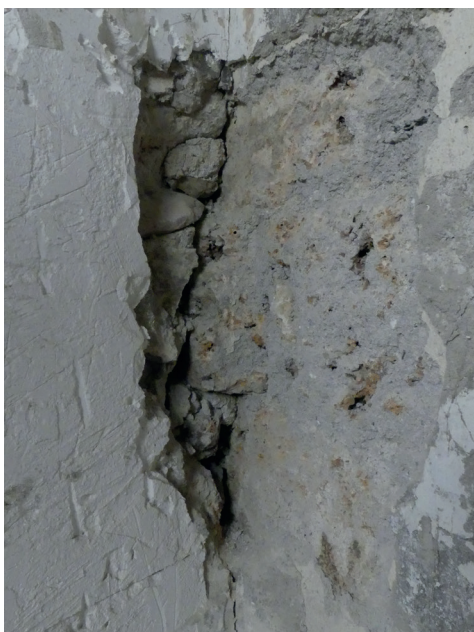
fig. 12 L'extrémité 1025 du mur occidental de la maison du 3 place du Mazel au premier étage, vue du sud-est : reprise ou chantier initial ?
