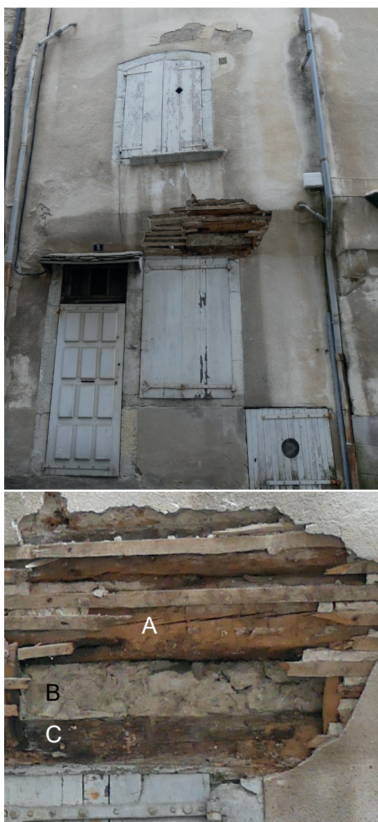
fig. 10 Détail du rez-de-chaussée et du premier étage de la façade principale MR1028, 3 place du Mazel, et de son encorbellement. Sous les lattis à nu, on distingue sur quelques décimètres de long une sablière de chambrée (A) probablement supportée par des consoles aux angles de la maison. Elle surmonte un pan de maçonnerie (B) qui couvre la sablière de plancher (C).
