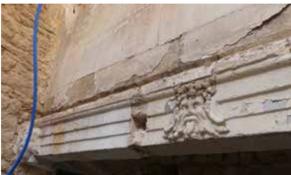
Fig.37 L'architrave et le mur d'échiffre de la loggia L01021 du deuxième étage, servant de couverture à la loggia du premier étage
