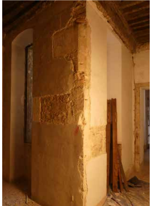
Fig.11 La porte 1073 entre la cour 0-2 et la pièce septentrionale de l'aile occidentale. On remarque que le montant de droite (nord) a été refait pour élargir la baie et le linteau, conservé, a été décalé vers le nord à ce moment-là pour reposer sur les deux piédroits
