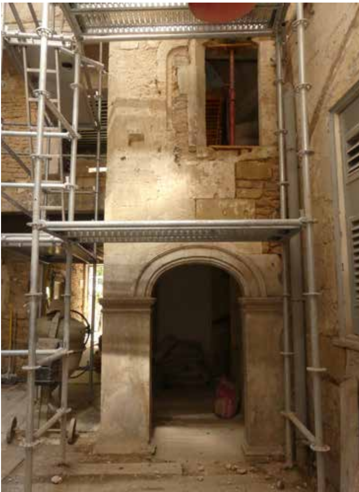
Fig.22 Une des deux portes d'accès à l'escalier : 1068 (la plus petite mais la plus ornée) et les deux fenêtres successives, 1069 et 1070, qui la surmontent. Vue de l'est.
