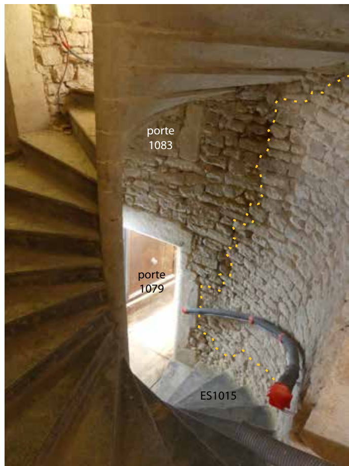
Fig.34 L'angle des murs MR1013 et MR1014 de la cage d'escalier (état 3), au début de la seconde révolution. On note ici le traitement courbe de l'angle. La ligne discontinue souligné, à la base, la saignée pour l'insertion des marches de l'état 4, et la brèche verticale faite dans le mur pour le déplacement des portes 1079 et 1080 vers les loggias du premier et du deuxième étage (état 4)
