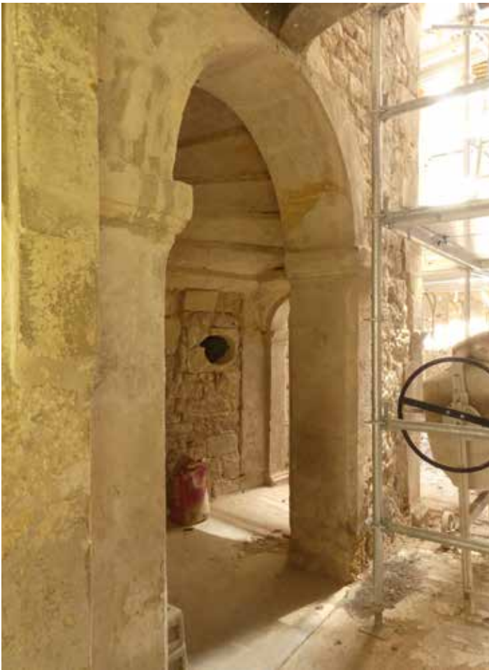
Fig.21 La plus grande des deux portes d'accès à l'escalier 1070. Vue du sud-ouest
