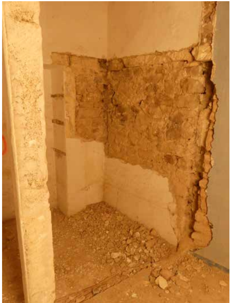
Fig.18 L'angle nord-ouest de l'aile nord de la maison. Au premier plan, la cloison MR1034 dont il ne reste ici, après démolition, que le montant de la porte. À l'arrière-plan, le pan de mur MR1004 à droite et le mur MR1022 à gauche, dégarnis de leurs enduits jusqu'au niveau de l'assise singulière en pierre de taille. Vue du sud-est
