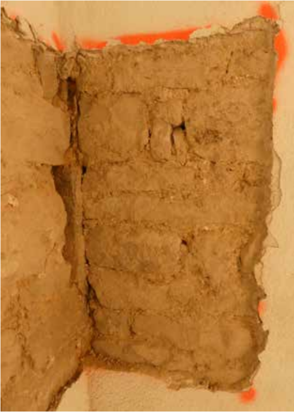
Fig.10 La cloison MR1011 au rez-de-chaussée et sa porte 1120 entre le passage d'entrée 0-1, au premier plan, et une pièce hors emprise à l'arrière. On note la parfaite intégration de l'encadrement de la porte dans la maçonnerie du mur et la reprise, approximativement au niveau du linteau, du sommet du mur pour la mise en place de la voûte VT1046
