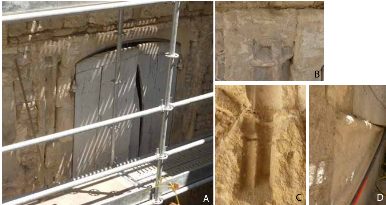
Fig.13 La fenêtre 1125 : une grande croisée dont il reste les montants et l'appui de part et d'autre de la fenêtre de remplacement (mur MR1009, rez-de-chaussée). A : vue d'ensemble (ou presque...). B : modénature dans l'angle haut, gauche. C : modénature à la base du piédroit de droite. D : appui © Inrap clichés et infographie O. Maufrais
