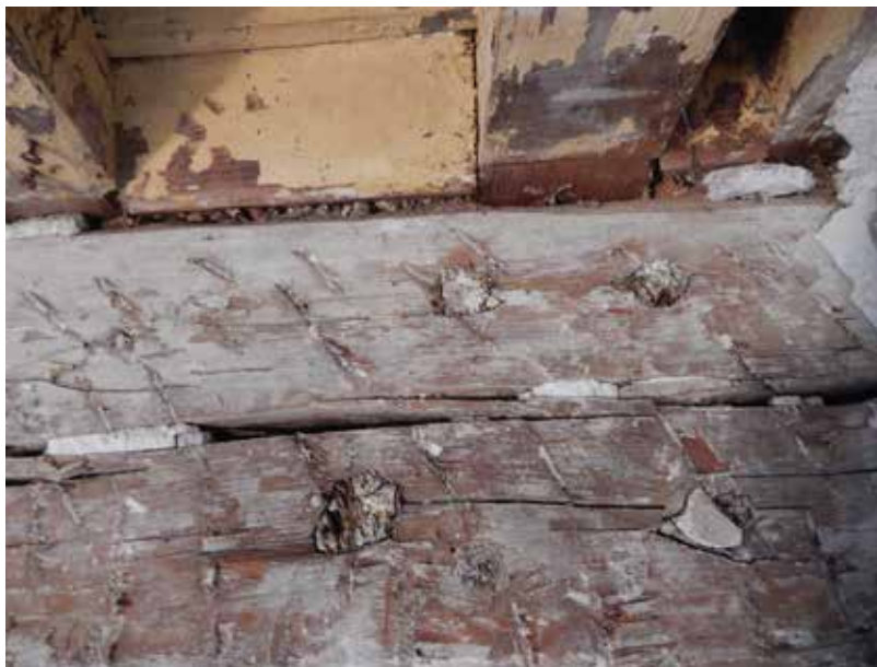
Fig. 1. Coin de blocage des ligatures des radeaux sur la pièce 1043 (carottes ASP01, ASP02).
