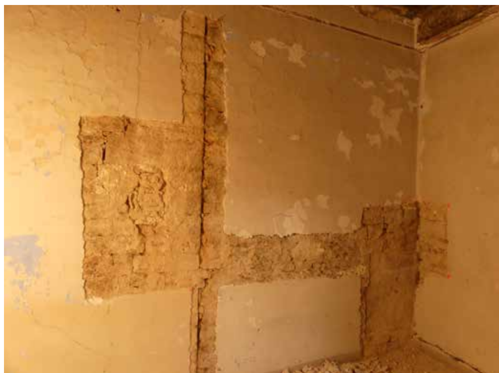
Fig.6 La partie occidentale du mur MR1006 en limite méridionale de la parcelle. À gauche (à l'est) le premier pan du mur et son chaînage avec une pierre en harpe d'attente. À droite (à l'ouest), la prolongation 1036. Le mur en retour de ce côté, MR1012, est postérieur, il appartient à l'état 1 de la maison du 16 rue de l'Aspic © Inrap cliché M. Piskorz
