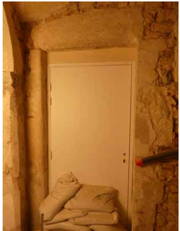
Fig.11 La porte 1073 entre la cour 0-2 et la pièce septentrionale de l'aile occidentale. On remarque que le montant de droite (nord) a été refait pour élargir la baie et le linteau, conservé, a été décalé vers le nord à ce moment-là pour reposer sur les deux piédroits
