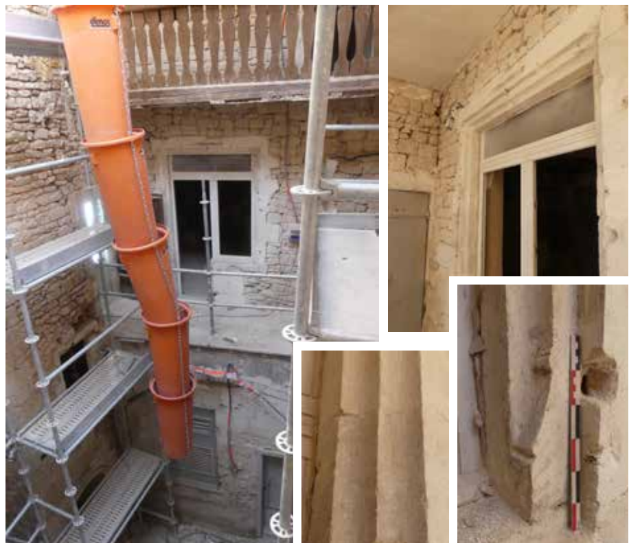
Fig.26 La façade sur cour MR1003 de l'aile septentrionale et le détail de la fenêtre 1080 au premier étage, très remaniée, dont la traverse a été buchée et le meneau déposé (sa trace est perceptible sur le joint des deux blocs du linteau). Détail des moulures
