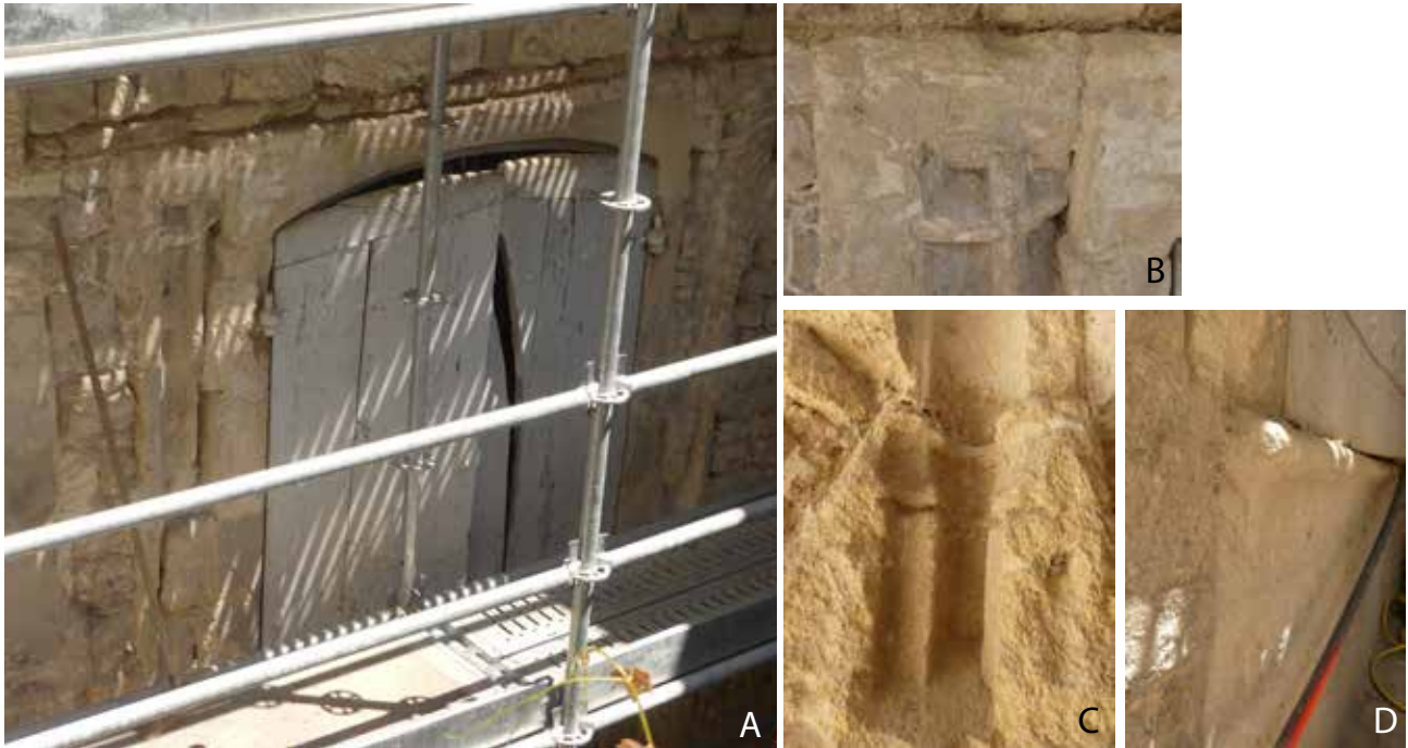
Fig.13 La fenêtre 1125 : une grande croisée dont il reste les montants et l'appui de part et d'autre de la fenêtre de remplacement (mur MR1009, rez-de-chaussée). A : vue d'ensemble (ou presque...). B : modénature dans l'angle haut, gauche. C : modénature à la base du piédroit de droite. D : appui
