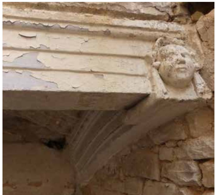
Fig.38 Détail du couverture de la loggia du premier étage L01020, formant le support de la loggia du second
