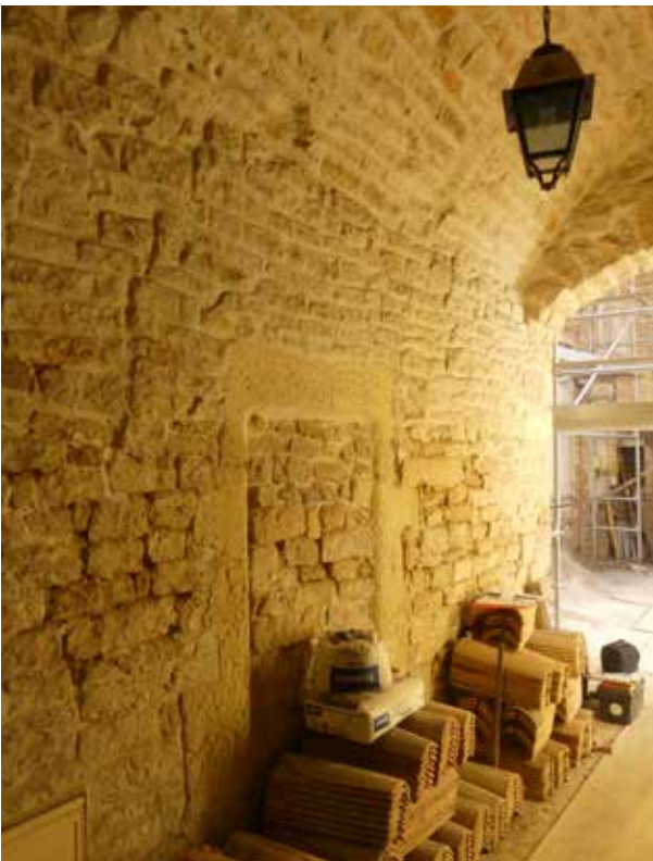
Fig.10 La cloison MR1011 au rez-de-chaussée et sa porte 1120 entre le passage d'entrée 0-1, au premier plan, et une pièce hors emprise à l'arrière. On note la parfaite intégration de l'encadrement de la porte dans la maçonnerie du mur et la reprise, approximativement au niveau du linteau, du sommet du mur pour la mise en place de la voûte VT1046
