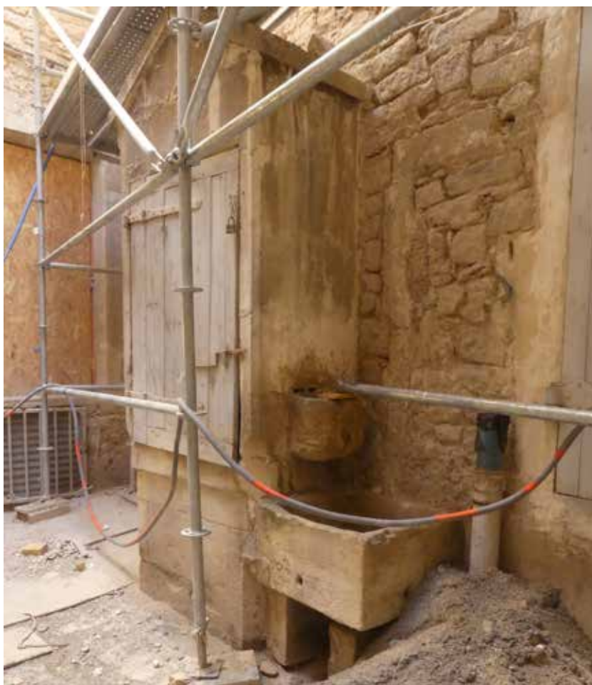
Fig.20 Le puits PT1023, avec sa pargelle d'un premier état (état 3 ?), sa superstructure, sa pile et son bac peut-être postérieurs (état 3 à 7). On note que la pile passe devant la porte 1067 de l'état 1 (obstruée au plus tard au cours de l'état 7)
