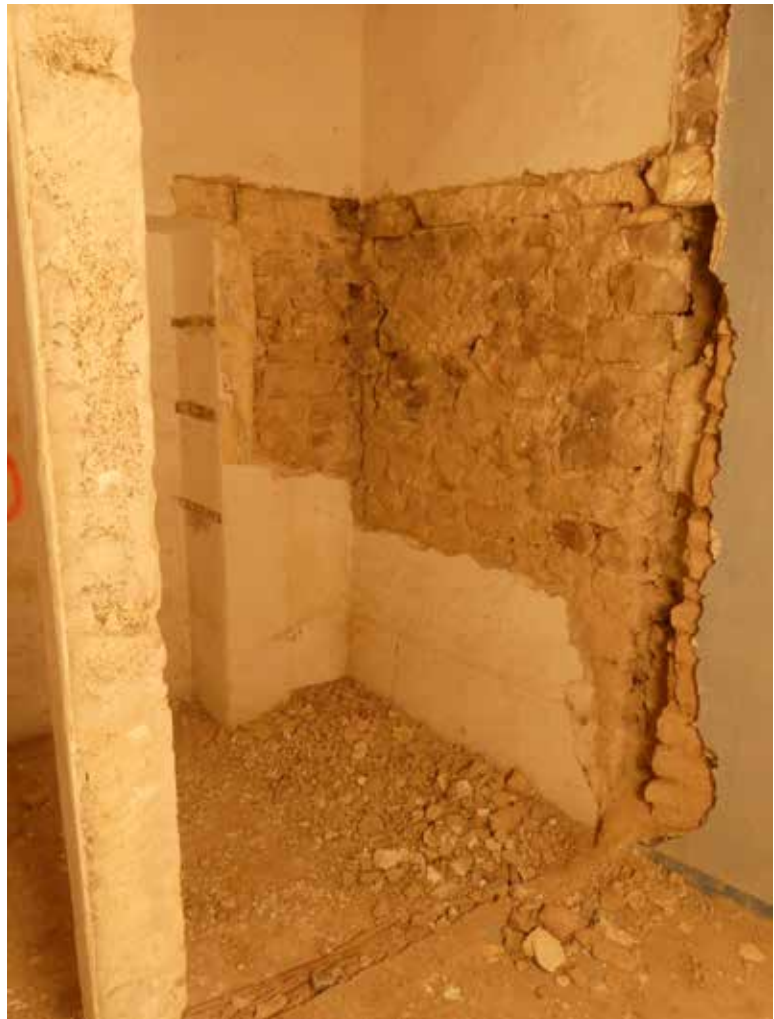
Fig.18 L'angle nord-ouest de l'aile nord de la maison. Au premier plan, la cloison MR1034 dont il ne reste ici, après démolition, que le montant de la porte. À l'arrière-plan, le pan de mur MR1004 à droite et le mur MR1022 à gauche, dégarnis de leurs enduits jusqu'au niveau de l'assise singulière en pierre de taille. Vue du sud-est
