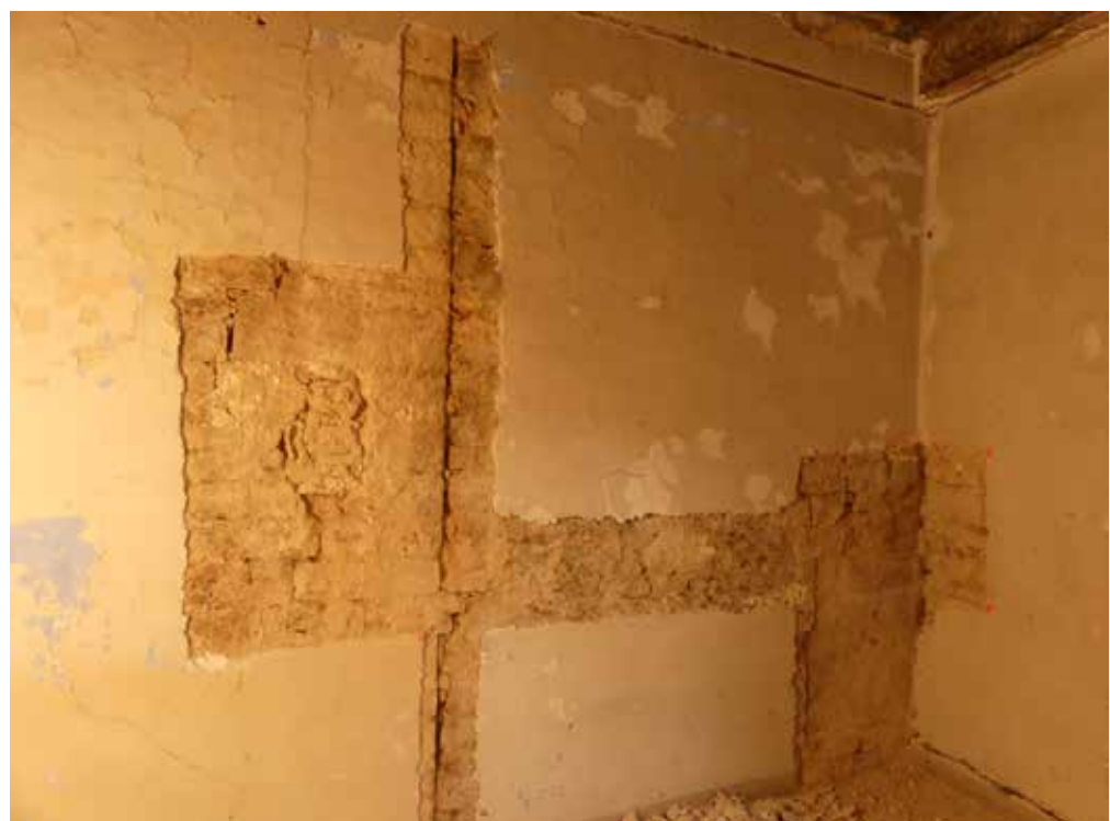
Fig.6 La partie occidentale du mur MR1006 en limite méridionale de la parcelle. À gauche (à l'est) le premier pan du mur et son chaînage avec une pierre en harpe d'attente. À droite (à l'ouest), la prolongation 1036. Le mur en retour de ce côté, MR1012, est postérieur, il appartient à l'état 1 de la maison du 16 rue de l'Aspic © Inrap cliché M. Piskorz
