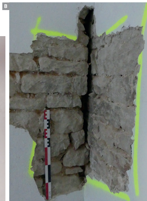
Fig. 13 Détails de l'appui du mur MR1005 sur le mur de clôture MR1002, au premier étage. A : pièce 113, le mur MR1005 est à droite, en appui sur l'enduit du mur MR1002 à gauche. Cl. L. Wozny/Inrap. B : pièce 18, le mur MR1005 est à gauche et le mur MR1002 est à droite. On note le décollement qui a été constaté jusqu'au deuxième étage. Cl. M. Rochette/Inrap.
