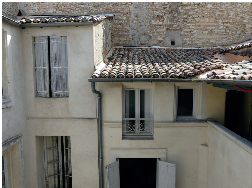
Fig. 21 Façade sur la cour 01 de l'aile orientale de la maison : à gauche, l'extrémité ancienne du mur MR1006 de l'état 2 (fenêtres plus récentes), plus haute que l'extension du mur à droite, percée d'une fenêtre au premier étage (en bas), de deux au deuxième (au centre du cliché) et d'une porte donnant sur la loggia (dans l'ombre, à droite). Cl. O. Mauftras/Inrap.
