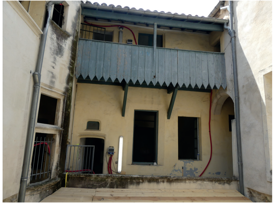
Fig. 24 Façade MR1009 sur la cour 01 de l'extension de l'aile occidentale, ici au premier étage et au second, avec les loggias bâties devant chacun. À gauche, la cage d'escalier ES1026. Cl. M. Rochette/Inrap.
