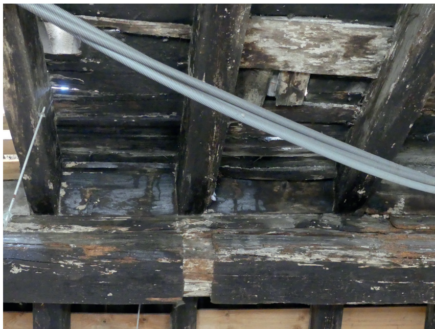
Fig. 39 Détail de la partie visible de la toiture T01059 couvrant la pièce 28 (extension de l'état 4 de l'aile orientale). Cl. O. Maufra/Inrap.
