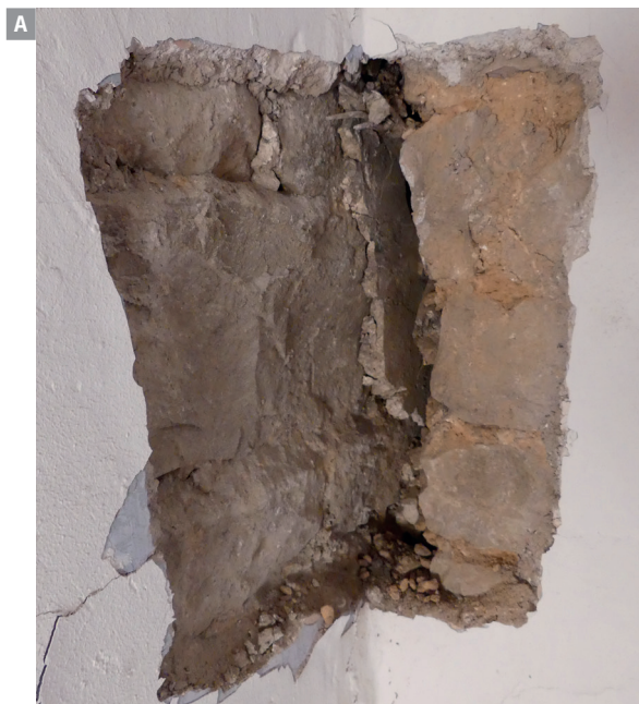
Fig. 13 Détails de l'appui du mur MR1005 sur le mur de clôture MR1002, au premier étage. A : pièce 113, le mur MR1005 est à droite, en appui sur l'enduit du mur MR1002 à gauche. Cl. L. Wozny/Inrap. B : pièce 18, le mur MR1005 est à gauche et le mur MR1002 est à droite. On note le décollement qui a été constaté jusqu'au deuxième étage. Cl. M. Rochette/Inrap.
