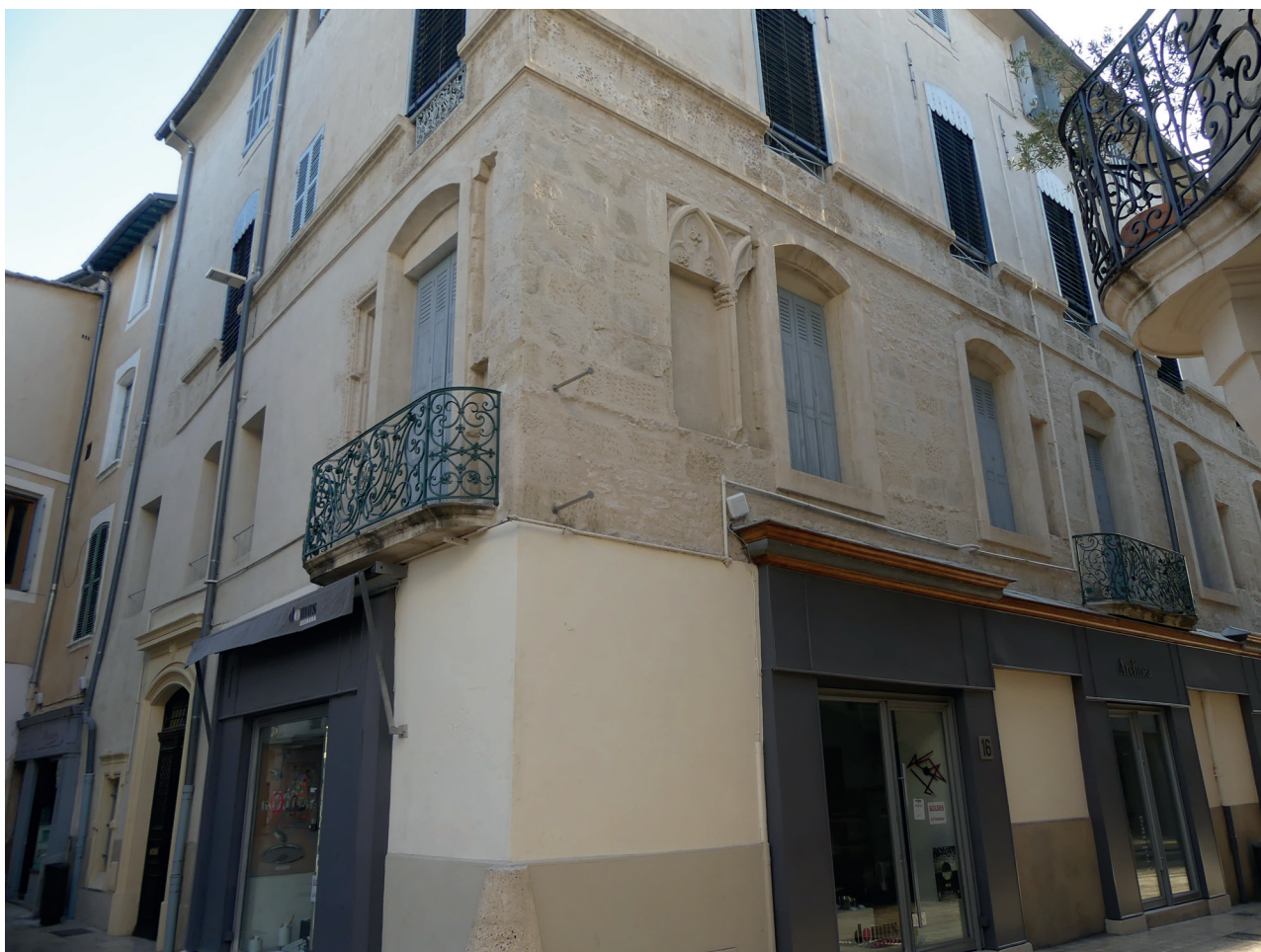
Fig. 6 La maison à l'angle de la rue de l'Horloge et de la rue du grand couvent, extrémité occidentale de la maison du 14bis rue de l'Horloge ? Cl. O. Mauftras (2016).
