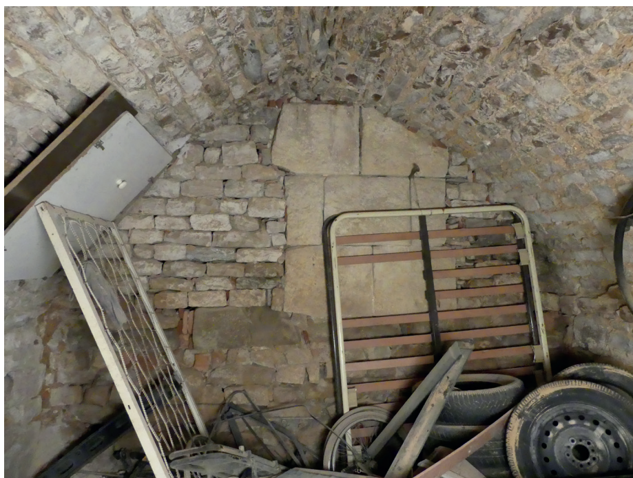
Fig. 5 Le mur MR1015 et sa porte obstruée 1018 vus de la cave 011. Le mur sépare la maison étudiée de sa voisine à l'ouest. Cl. O. Maufra/Inrap.
