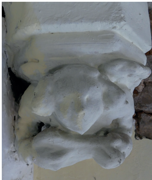
Fig. 18 Le corbeau 1044 supportant l'extrémité méridionale de la poutre 1024 (plafond PL1020). Cl. L. Wozny/Inrap.
