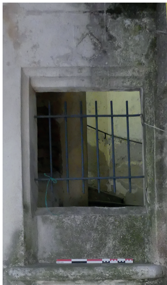
Fig. 30 La fenêtre 1029, éclairant la première révolution de l'escalier ES1026 depuis la cour. Cl. O. Maufra/Inrap.
