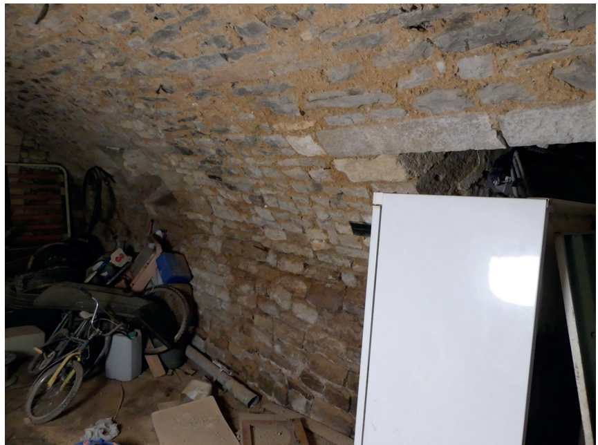
Fig. 42 Le mur septentrional de la cave 011 et ses soupiraux (vus du sud-est). Un soupirail est derrière le réfrigérateur du premier plan, l'autre est au-dessus des vélos. Cl. O. Mauftras/Inrap.
