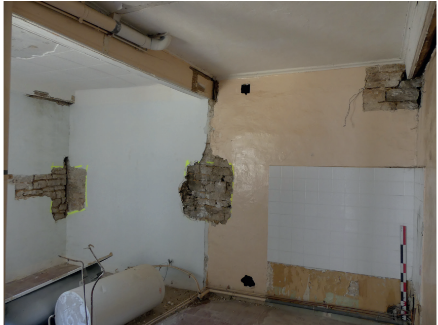
Fig. 37 Le plafond de l'extension de l'aile orientale, au premier étage (pièce 18), vu de l'ouest. Cl. L. Wozny/Inrap.
