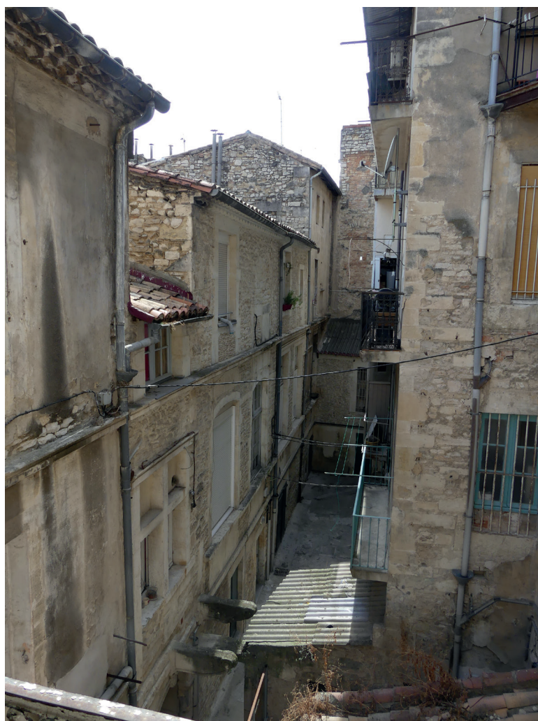
Fig. 49 La ruelle est-ouest en cœur d'îlot, vue de l'est (de la pièce 215 au deuxième étage). A gauche, l'extrémité de la façade MR1046 (pièces superposées 114 et 214), puis, la façade de la maison du 14bis rue de l'Horloge avec sa croisée, puis la façade du 14. Cl. M. Rochette/Inrap.
