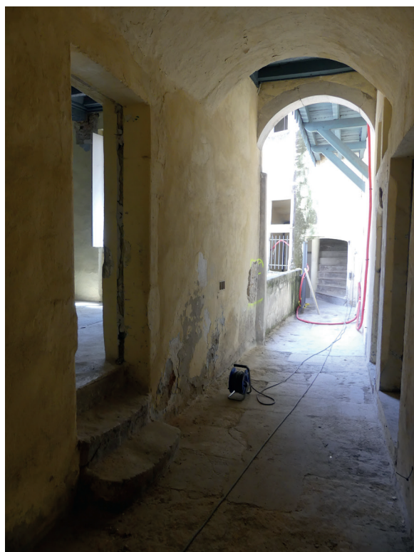
Fig. 46 . Le couloir 03 et dans son prolongement ma loggia 03 au premier étage de la maison (vus du nord). A gauche, la porte d'accès à la salle 112 et son emmarchement. A droite, les ouvertures vers la pièce 11b et le couloir 111a. .
