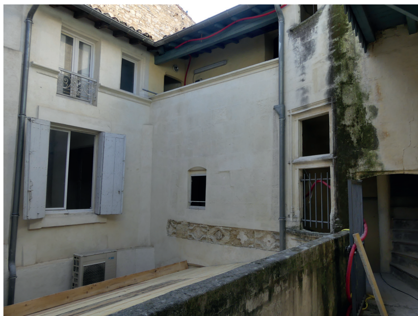
Fig. 28 Les coursives 15 et 25, respectivement au premier étage et au second. Le garde-corps de celle du premier a été surmonté d'un mur, MR1035, mais il est néanmoins reconnaissable à son décor disposé en frise à environ 1 m du sol du premier étage (sous la main courante restituée). Vue prise du nord. Cl. O. Maufra/Inrap.
