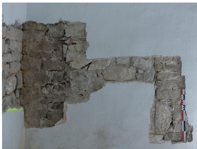
Détail de la fenêtre bouchée 1008 dans le mur de façade MR1001, postérieure à l'angle des murs MR1001 et MR1002 et antérieure à la fenêtre actuelle. Cl. M. Rochette.
