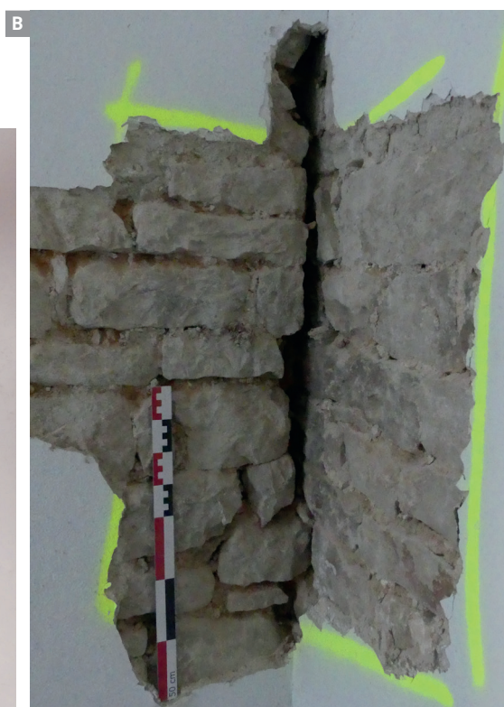
Fig. 13 Détails de l'appui du mur MR1005 sur le mur de clôture MR1002, au premier étage. A : pièce 113, le mur MR1005 est à droite, en appui sur l'enduit du mur MR1002 à gauche. Cl. L. Wozny/Inrap.
