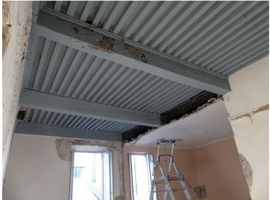
Fig. 47 Le plafond PL1074, nouveau couvrement de la salle 114 après sa réduction. Vue du sud-ouest. Cl. M. Rochette/Inrap.
