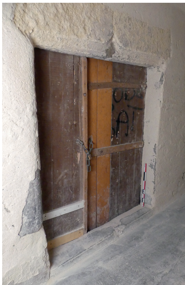
Fig. 9 La porte d'entrée 1013 de l'aile occidentale de la maison (état 2). Vue de l'extérieur, du sud-est. Cl. O. Maufra/Inrap.
