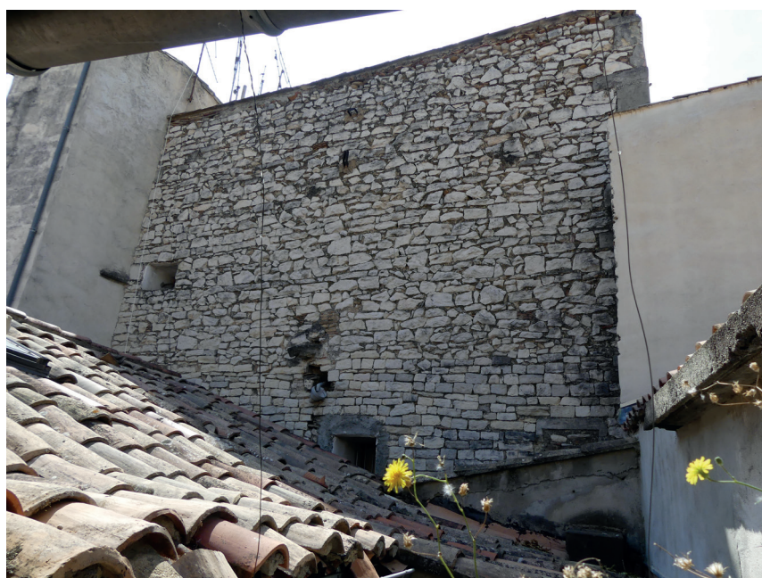
Fig. 53 Le troisième étage du corps méridional, dominant les toitures du reste de l'immeuble, vu du nord. On remarque en particulier la reprise du mur MR1012 qui, au niveau du deuxième étage présente son appareil régulier de l'état 2 et au-dessus deux reprises. La première est de l'état 5. La seconde est ponctuelle.
