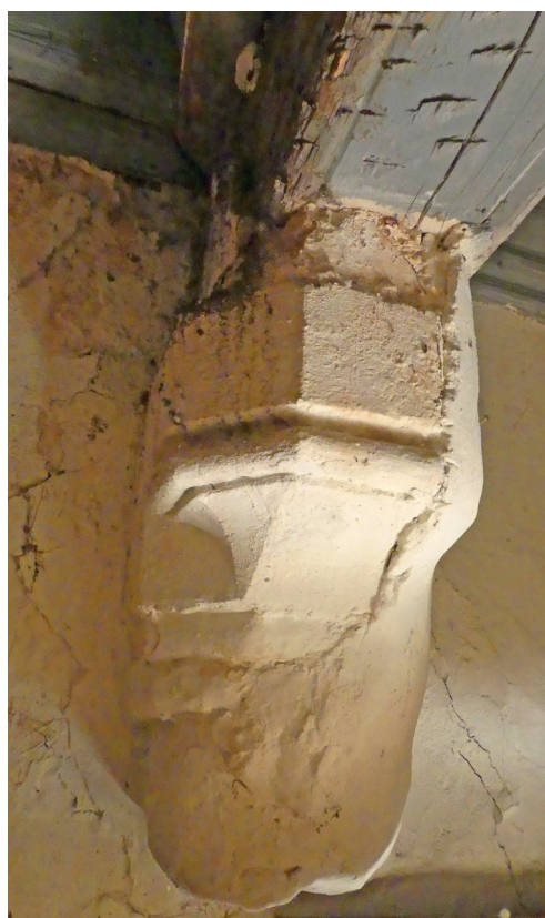
Fig. 19 Le corbeau 1045 supportant l'extrémité septentrionale de la poutre 1024 (plafond PL1020). Cl. L. Wozny/Inrap.
