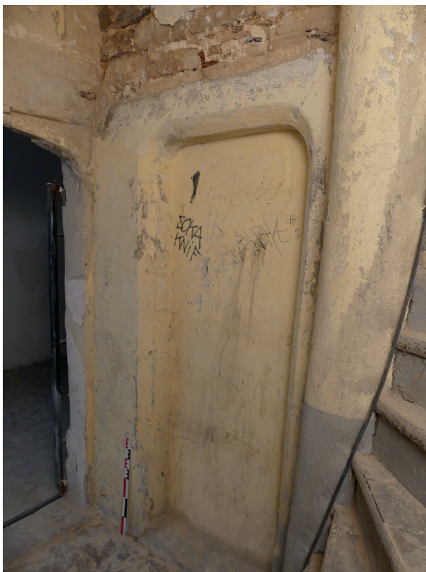
Fig. 29 La porte 1025, au sud de l'escalier ES1026, entre celui-ci et la pièce 017, autrefois d'entrée. À gauche, on distingue le montant de la porte 1019 entre l'escalier et la cour. Cl. O. Maufra/Inrap.
