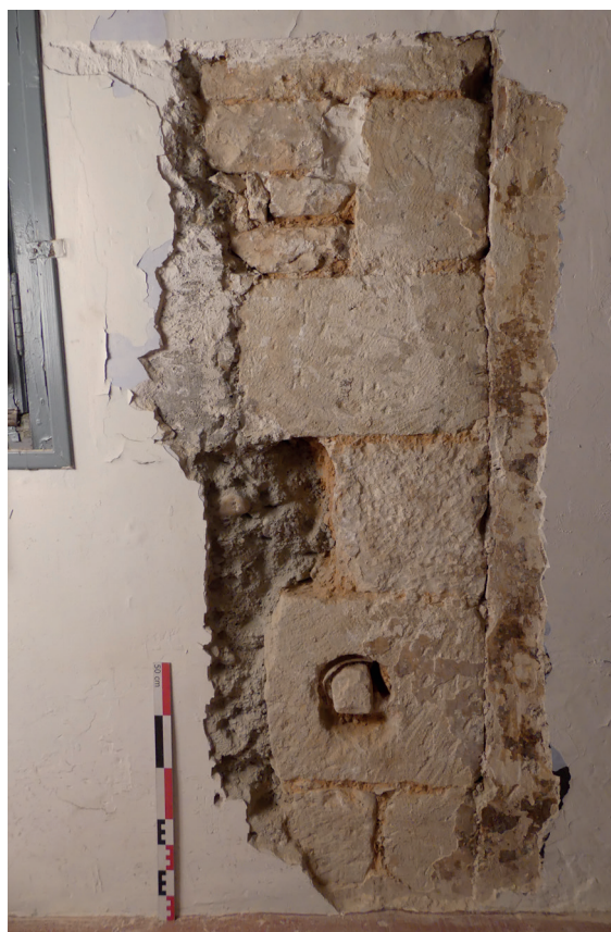
Fig. 14 Le chaînage des murs MR1066 et MR1036, vu de l'est. L'ouvrage est cassé au sud (à gauche) par l'insertion de la fenêtre récente 1034 et il est contrebuté à droite (au nord) par la cloison MR1039, également récente (XIX e et XX e siècles). Cl. L. Wozny/Inrap.
