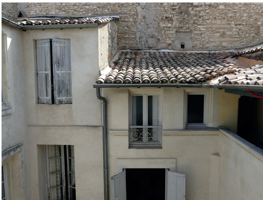
Fig. 21 Façade sur la cour 01 de l'aile orientale de la maison : à gauche, l'extrémité ancienne du mur MR1006 de l'état 2 (fenêtres plus récentes), plus haute que l'extension du mur à droite, percée d'une fenêtre au premier étage (en bas), de deux au deuxième (au centre du cliché) et d'une porte donnant sur la loggia (dans l'ombre, à droite). Cl. O. Mauftras/Inrap.
