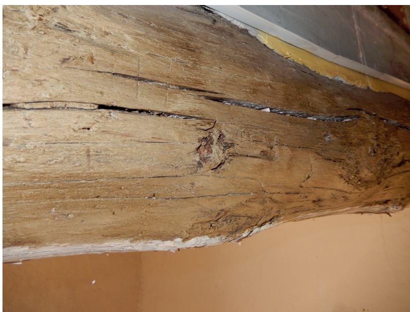
Fig. 1. Coin de blocage des ligatures des radeaux sur la pièce ayant fourni la carotte NH1066.
