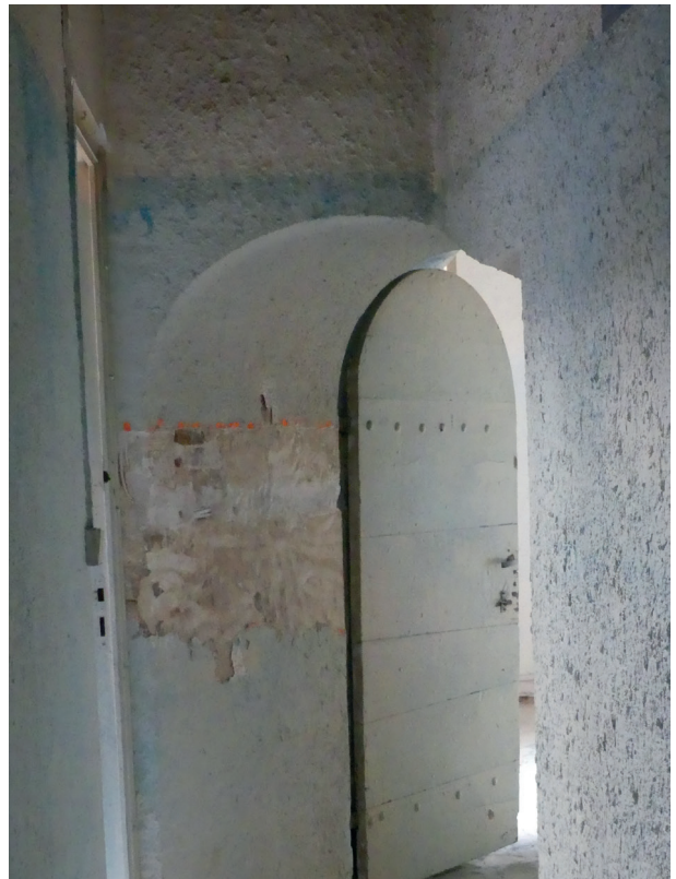
Fig.23 Le passage PR1072 entre les pièces 111 et 19 au premier étage, vu de l'ouest (de la pièce 111). La cloison au premier plan à gauche est tardive et il faut en faire abstraction pour repérer l'angle de prise de vue sur la figure 14
