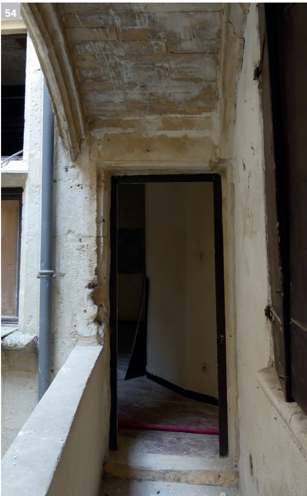
Fig.54 Détail de la porte 1063 au premier étage, entaillée au cours de l'état 4 dans le parement de la façade MR1045 de l'état 3 © Inrap cliché O. Maufras
