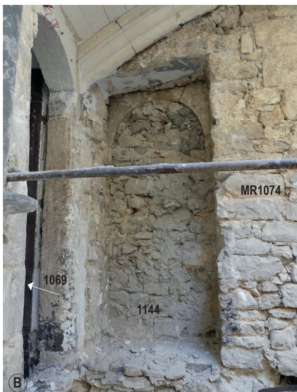
Fig.64 Portes d'accès à la dernière loggia, LO1076 (démontée au moment du cliché).
