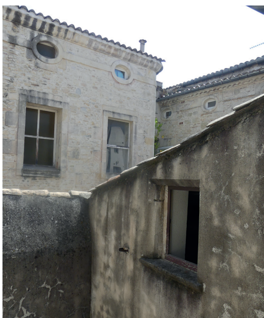
Fig.27 Le fenestron 1039, mur MR1034 au troisième étage, éclairant la pièce 39, au sud-est de la maison septentrionale. On note à l'arrière-plan les façades de la propriété Faucon-Calvière. Vue du nord-ouest
