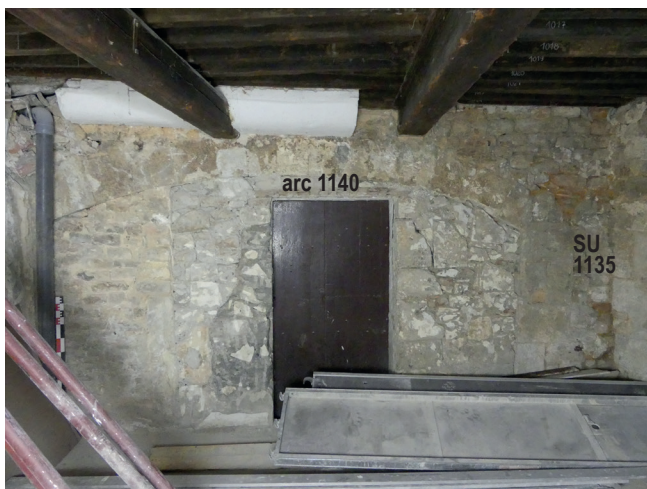
Fig.29 Le pan de mur MR1027 au rez-de-chaussée. Seule l'extrémité méridionale (* à droite) remonte à l'état 2
