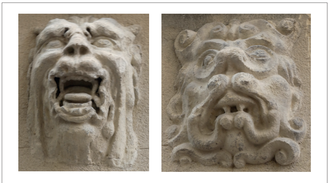
Fig.60 Détail des deux mascarons, probablement en remploi, soulignant le cordon saillant du premier étage, en façade sur rue © Inrap cliché O. Mauftras
