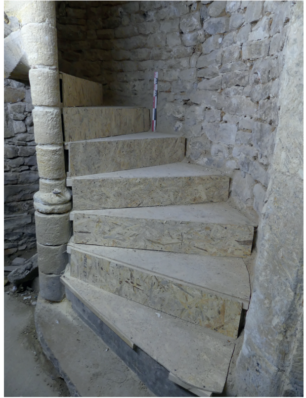
Fig.16 Base de l'escalier ES1103, entre les maisons du nord et centrale. Vue depuis la porte 1029 de la maison centrale
