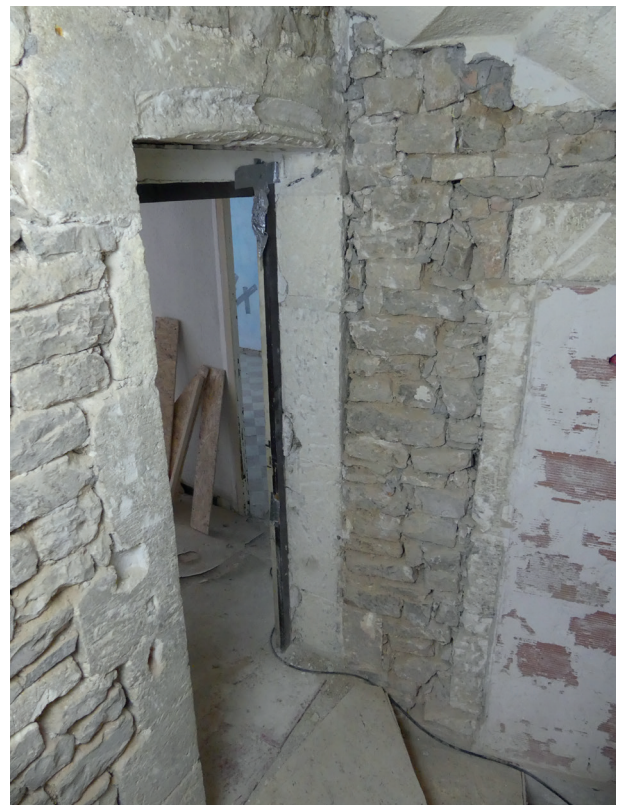
Fig.21 La porte 1155 au premier étage de la maison, entre l'escalier et la pièce 112. Les montants et l'intrados du linteau ont été retaillés mais la moulure de ce dernier est conservée sur sa plus grande part © Inrap cliché L. Wozny
