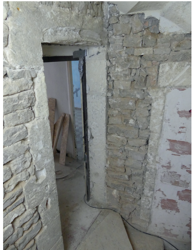
Fig.19 La porte 1155 entre l'escalier et la pièce 112 au premier étage © Inrap cliché L. Wozny
