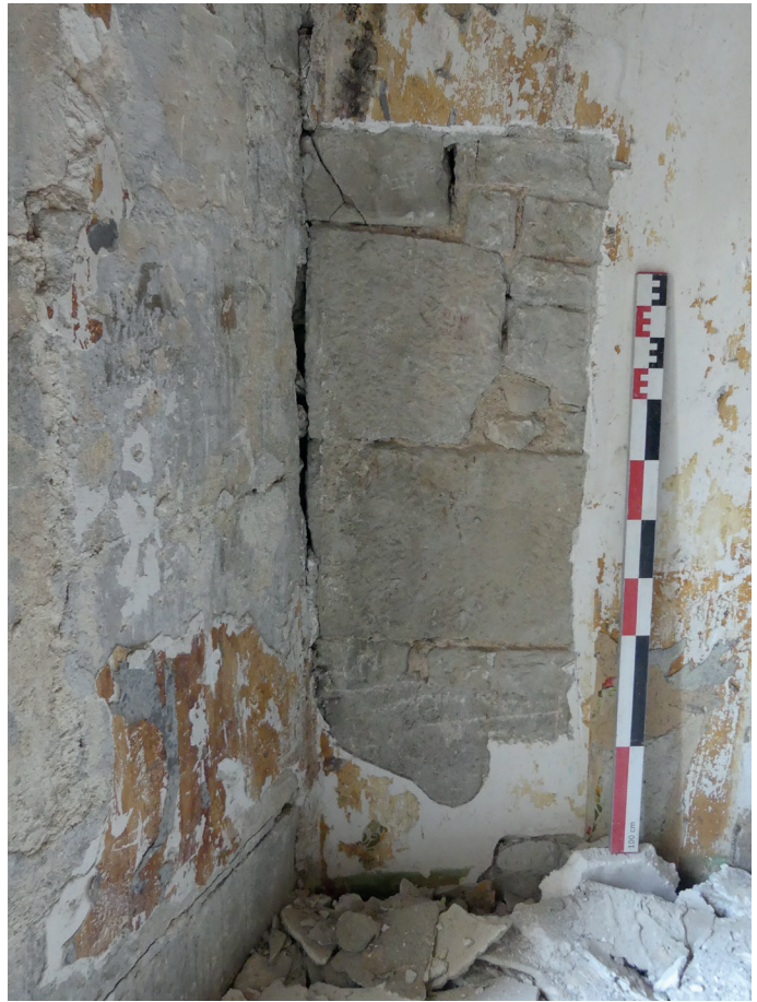
Fig.7 Le chaînage d'angle à l'extrémité occidentale du mur MR1040 de la maison gothique, conservé au troisième étage et contrebuté (à gauche) par la façade sur rue MR1041 de la maison du 13 rue des Marchands
