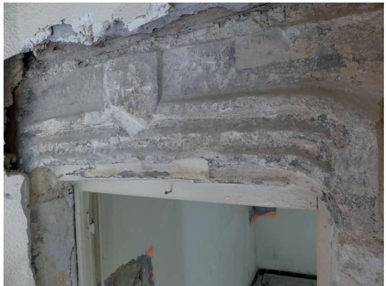
Fig.47 Détail du linteau de la porte 1060
