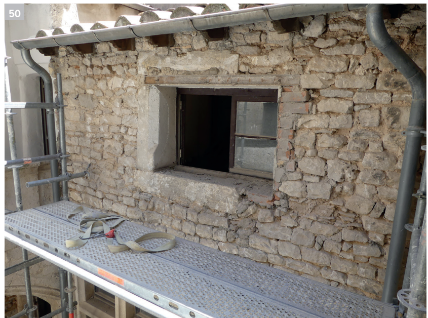
Fig.50 Détail de la petite fenêtre du second étage de la façade sur cour de l'aile méridionale, MR1049 © Inrap cliché L. Wozny
