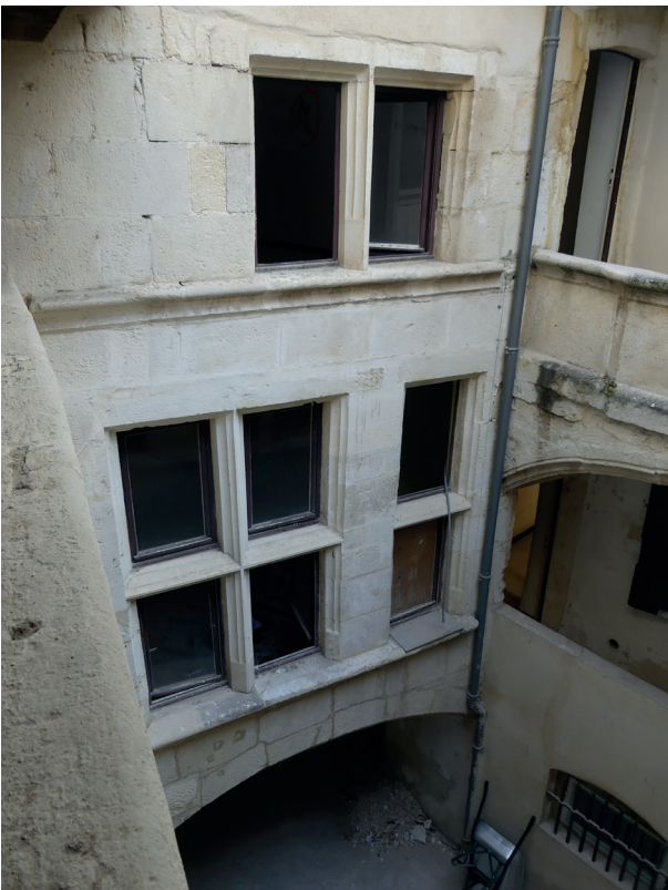
Fig.41 Vue d'ensemble de la façade sur cour MR1045 de l'aile septentrionale de la maison méridionale. Vue du sud © Inrap cliché O. Mauftras
