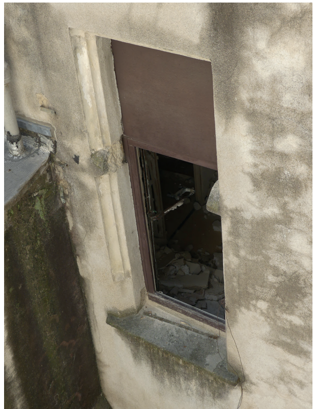
Fig.25 La fenêtre 1036, mur MR1034 au deuxième étage, éclairant la pièce 29, au sud-est de la maison septentrionale. Vue du nord-ouest
