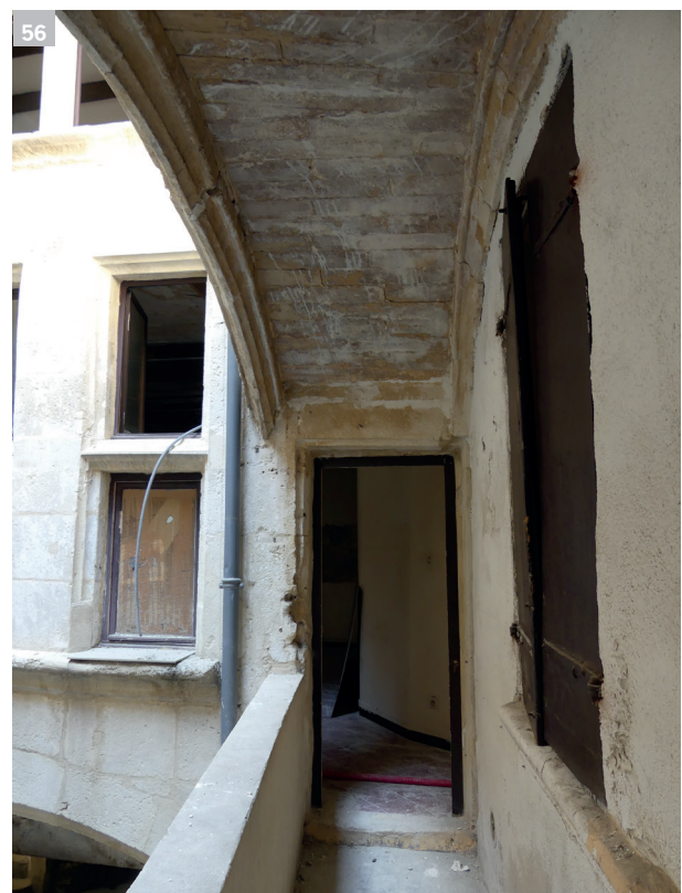
Fig.56 La loggia LO1077 du premier étage, vue du sud, avec la porte d'accès 1062 au fond et la voûte de support de la loggia du deuxième étage LO1053 © Inrap cliché O. Mauftras
