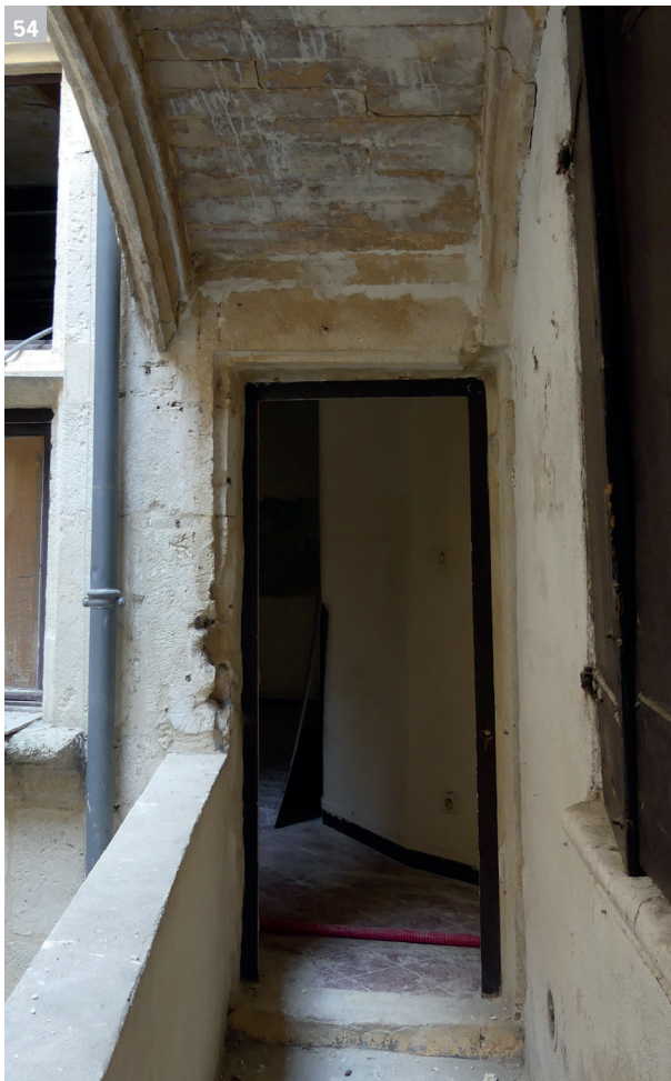
Fig.54 Détail de la porte 1063 au premier étage, entaillée au cours de l'état 4 dans le parement de la façade MR1045 de l'état 3 © Inrap cliché O. Mauftras
