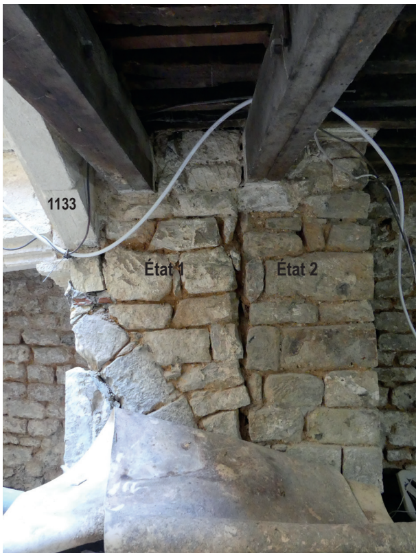
Fig. 37 Le pilier occidental SB1134 de support des façades successives de l'aile nord de la maison méridionale. Construction initiale à droite (état 2 du site), contrebutée à gauche par le doublage de l'état 3.
