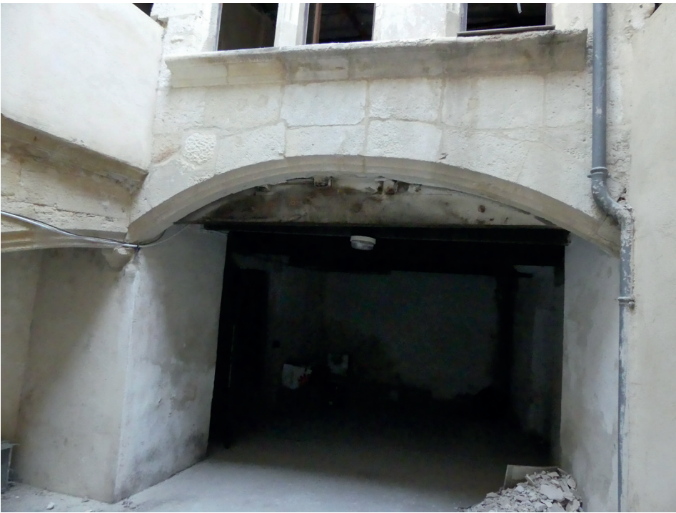
Fig.40 L'arc 1133 supportant la façade sur cour MR1045 de l'aile septentrionale de la maison méridionale. Vue du sud © Inrap cliché O. Mauftras
