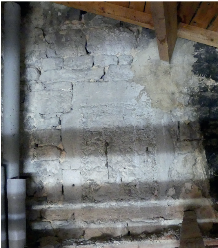
Fig.8 La fenêtre obstruée 1132 de la propriété voisine (11 rue des Marchands), observée depuis la pièce 311 au troisième étage (au niveau de la mezzanine)
