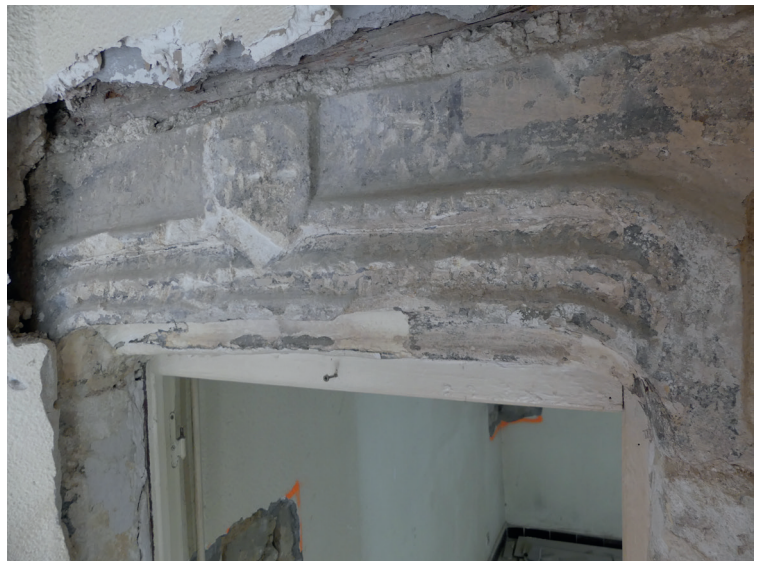
Fig.47 Détail du linteau de la porte 1060
