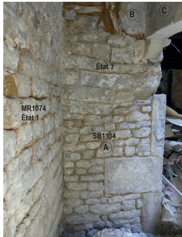
Fig. 38 Le pilier occidental SB1134 vu du sud. À gauche le mur MR1074 de séparation de la parcelle voisine. Au centre, la face méridionale du pilier avec la maçonnerie de son deuxième état en haut et la consolidation en sous-œuvre ( A ). En haut à droite, l'extrémité de l'arc 1133 ( B ) qui a été remplacé tardivement et l'arc formeret ( C ) de la voûte porteuse de l'escalier ES1075 de l'état 4
