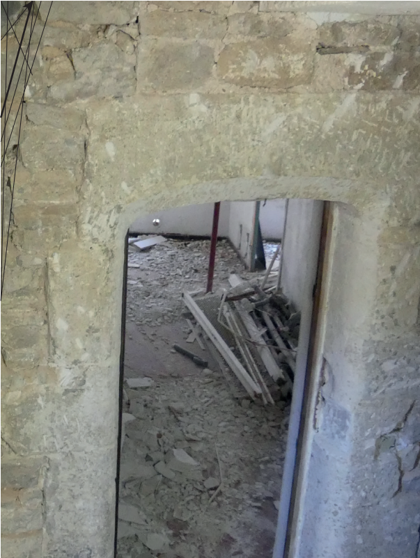
Fig.22 La porte 1156 au deuxième étage de la maison, entre l'escalier et la pièce 212. Les traces de peinture sur les montants, débordantes et les quelques petites pierres de calage des blocs appareillés du montant de gauche (du sud) donnent l'impression de l'insertion a posteriori de l'encadrement de la porte dans le mur MR1042. Il n'en est rien. Le montant et le linteau sont bien mis en place en même temps que l'on dresse le mur © Inrap cliché L. Wozny
