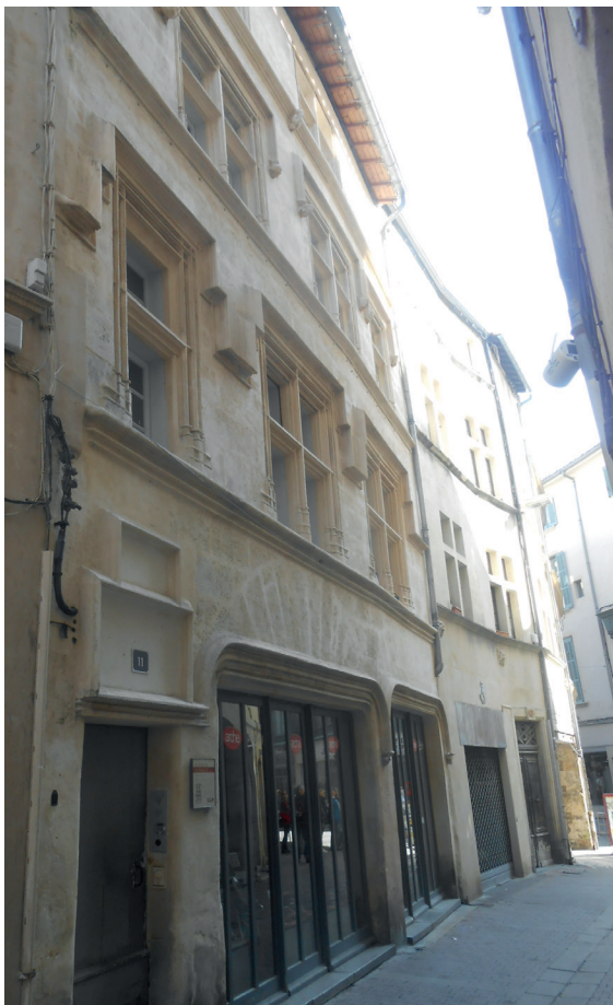
Fig.6 Les façades sur rue de la maison gothique (numéro 11, au premier plan) et de la maison du 13 rue des Marchands (au second plan)
