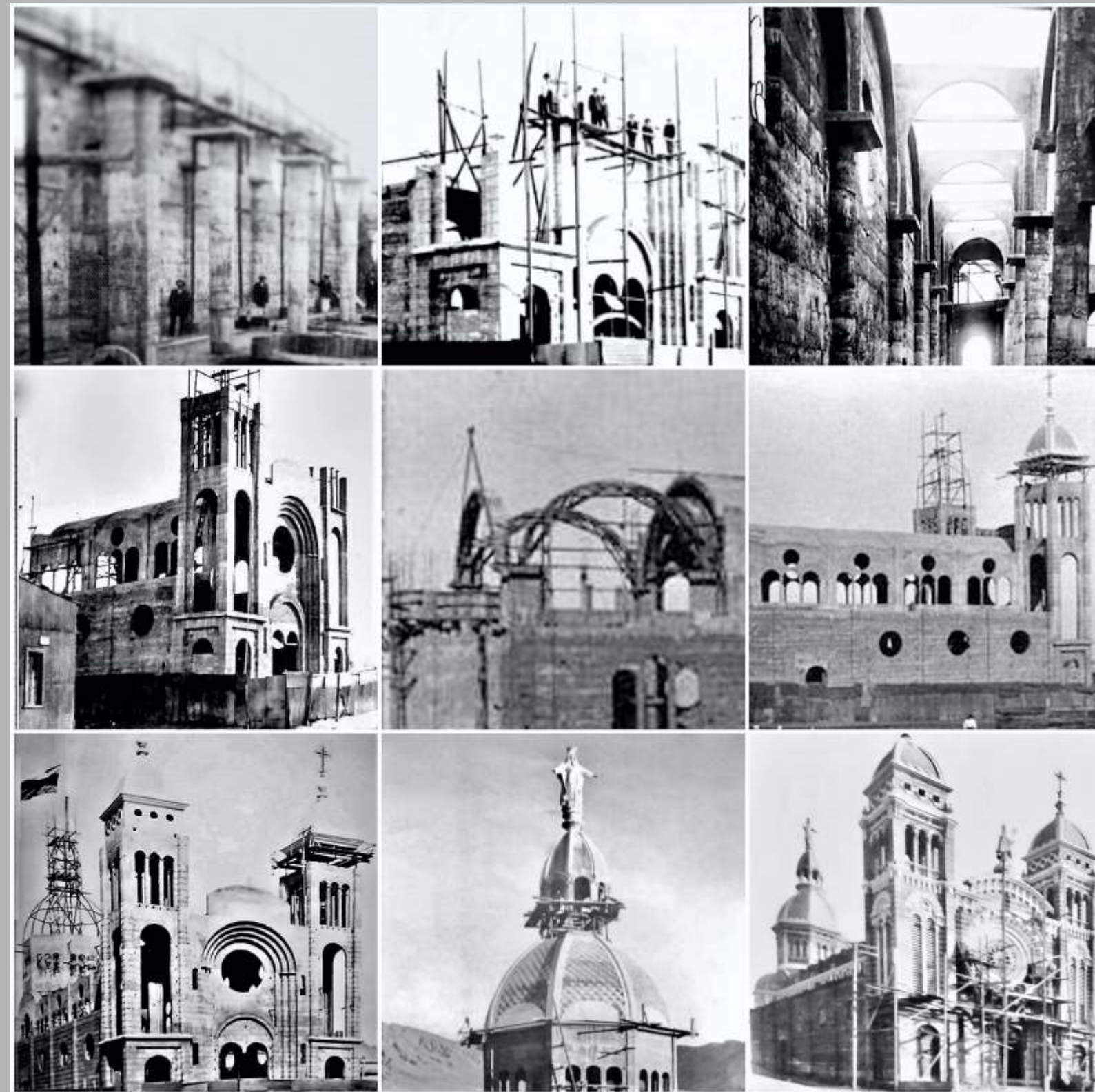
Proceso constructivo del templo. Archivo: D. Galaz-Mandakovic. Elaboración propia.
