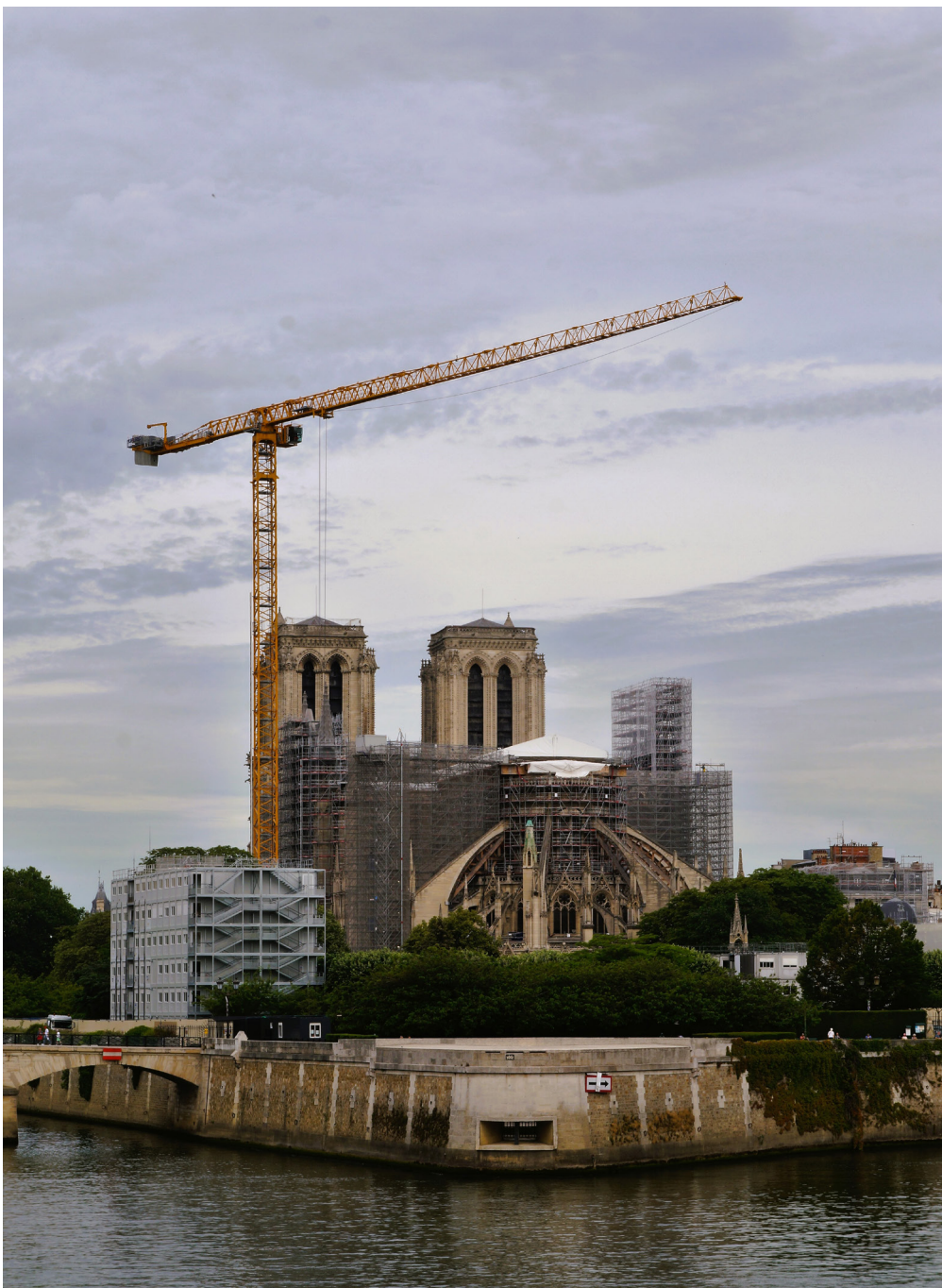
Fig. 1 – Vue générale du chantier de restauration de Notre-Dame. © Julien Bastoen, Juin 2022.
