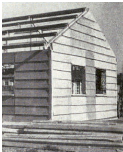
Fig.7 – Pont-Hébert (Manche), ferme Perrot en construction, Guy Pison architecte, L'Architecture d'aujourd'hui , n° 22, mars 1949.
