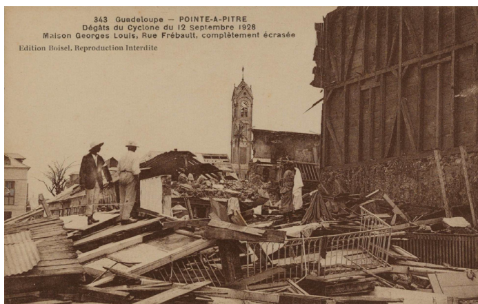
Fig.3 - Pointe-à-Pitre, Dégâts du cyclone du 12 septembre 1928, maison Georges Louis, rue Frébault, complètement écrasée. © Éd. Boisel, AdG.
