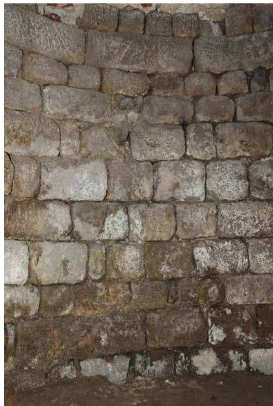
Figure 10 : appareillage de l'élévation intérieure de la tour, niveau de cave.
