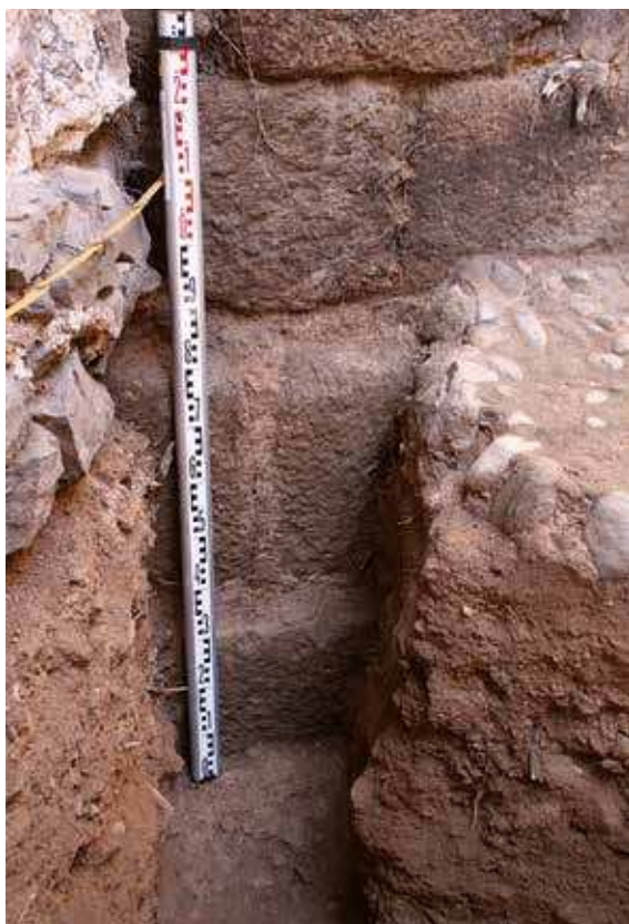
Figure 9 : dégagement des ressauts de fondation, sondage 1.
