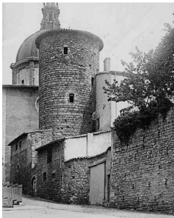
Figure 7 : Vue de la tour, des dépendances L2 et L3 depuis la rue Henrys en 1895 (A. Diana)
