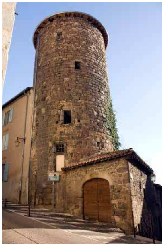
Figure 6 : Vue actuelle de la tour et de la remise L3 depuis la rue du Palais de Justice.
