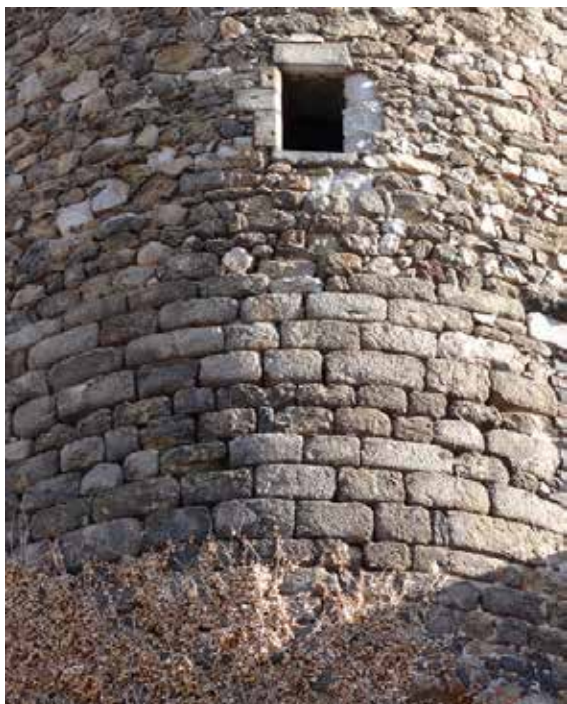
Figure 11 : appareillage de l'élévation extérieure de la tour : gros appareillage du XIII e s. et rehausse du XVI e s.
