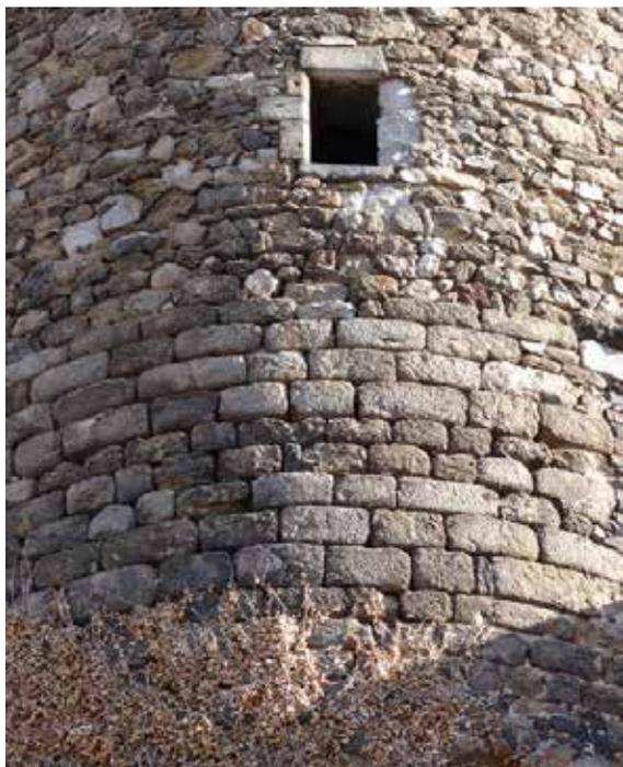
**Figure 11** : appareillage de l'élévation extérieure de la tour : gros appareillage du XIII<sup>e</sup> s. et rehausse du XVI<sup>e</sup> s.
