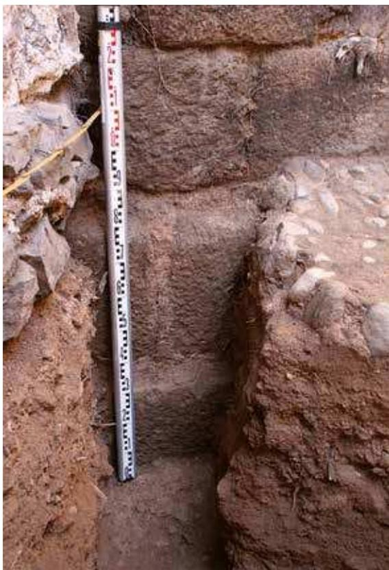
**Figure 9** : dégagement des ressauts de fondation, sondage 1.
