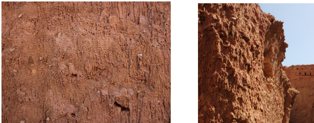
Figure 6. Mur construit en adobe salin
