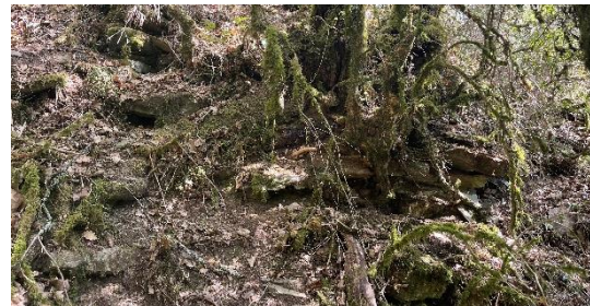
Fig. Moellons coincés sous les buis au sud-est de M1b et sous M2 et M3 : mur d'enceinte ? Crédit Florence Guillot.
