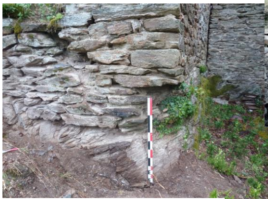
Fig. Mur 10, angle sud et retaille du substrat. Sondage 2019.
