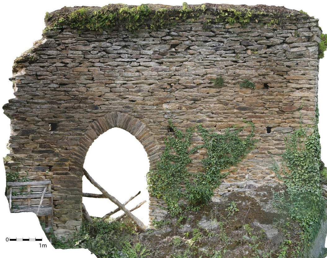
Fig. Mur 7 et P2. Orthomosaïque de la photogrammétrique, partie sud-est et externe du mur. Crédit Florence Guillot.
