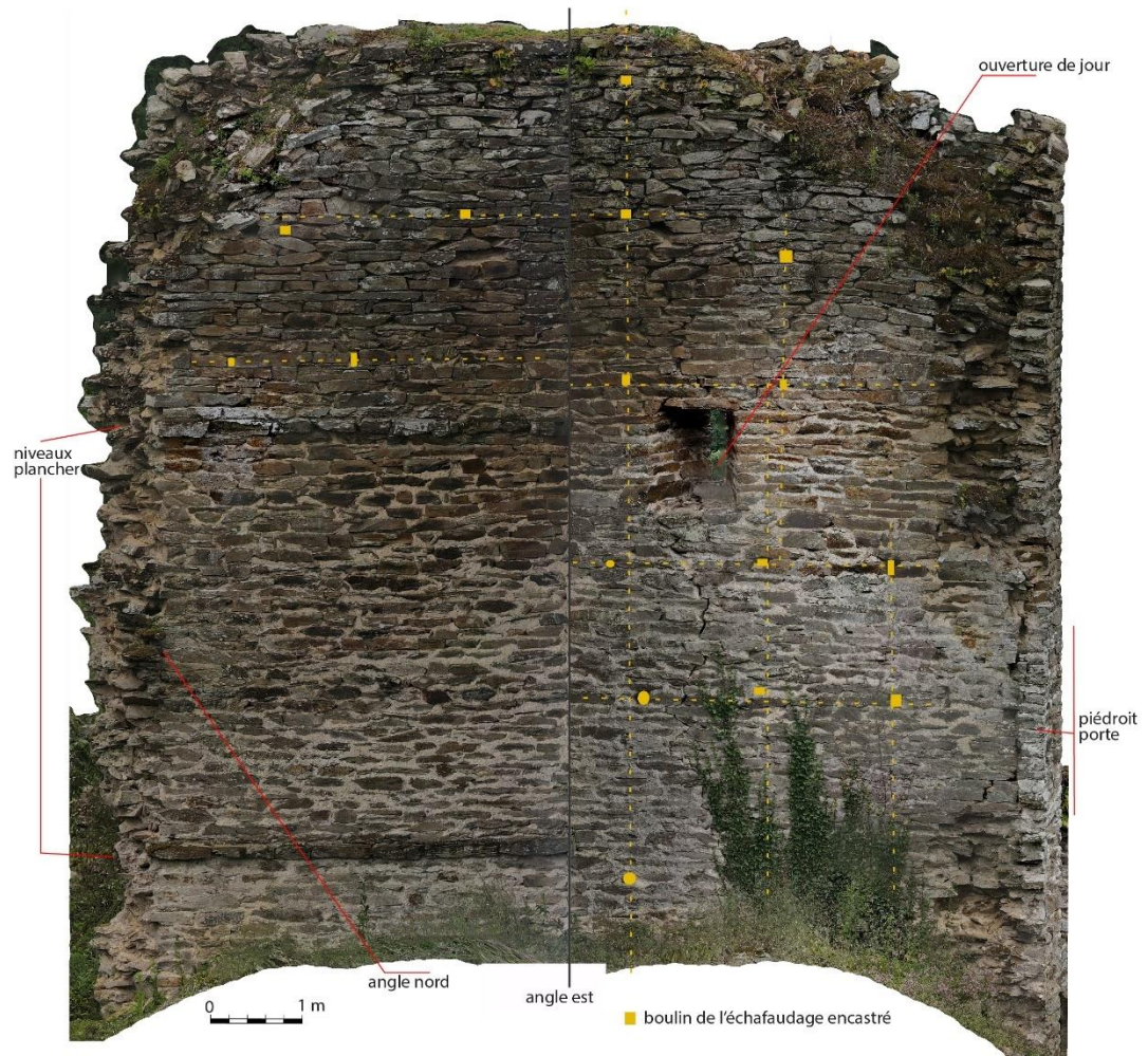
Fig. 7. Phasage de l'entrée : vestiges de porte du château initial (M1a et M1c) et réparations au XVe siècle (M1b). Orthomosaïque de la photogrammétrie du parement interne. Crédit Florence Guillot.
