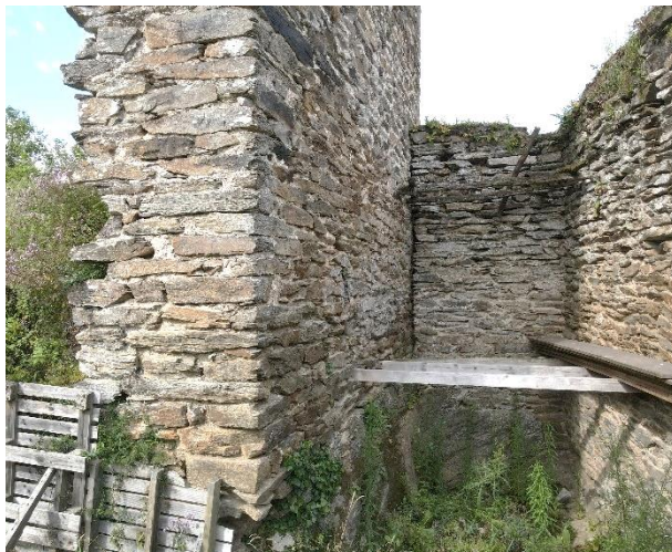
Fig. M10 (à gauche) et M7 (à droite). Planches et poutres dans les encoches, état actuel. On aperçoit les premiers claveaux de voûte de la P2 à l'extrémité droite de l'image et le substrat retaillé sous les planches. Crédit Florence Guillot.
