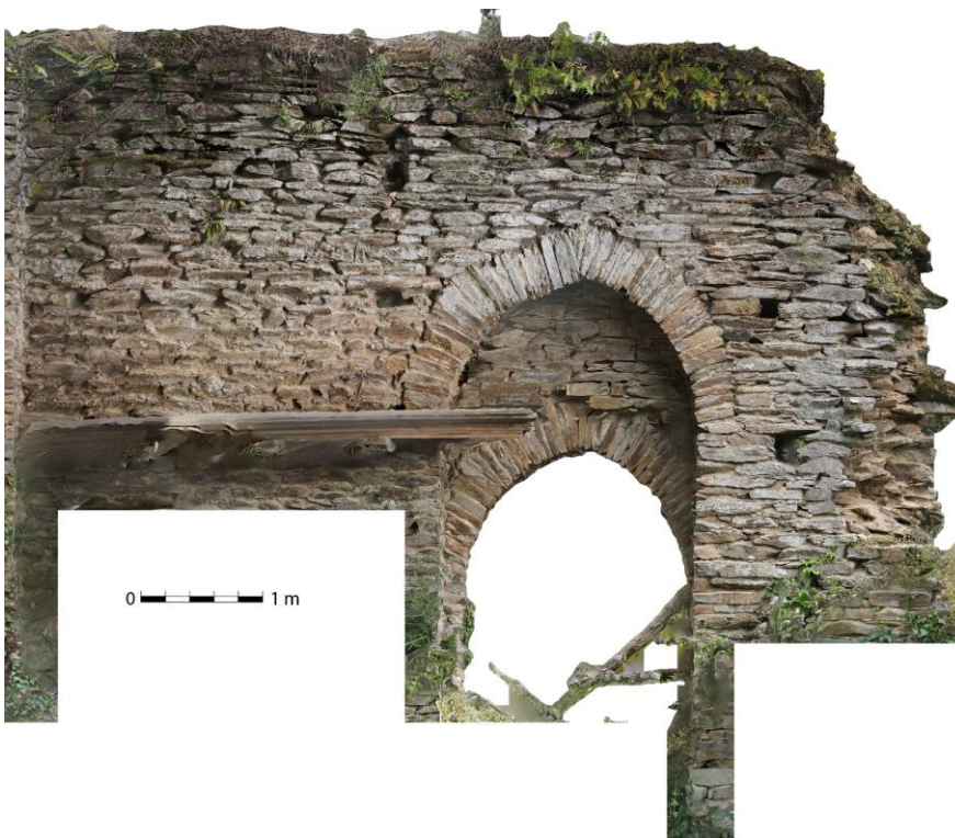
Fig. Mur 7. Orthomosaïque de la photogrammétrie, partie interne. La base du mur en interne manque du fait de la présence d'obstacle aux prises de vue. Crédit Florence Guillot.
