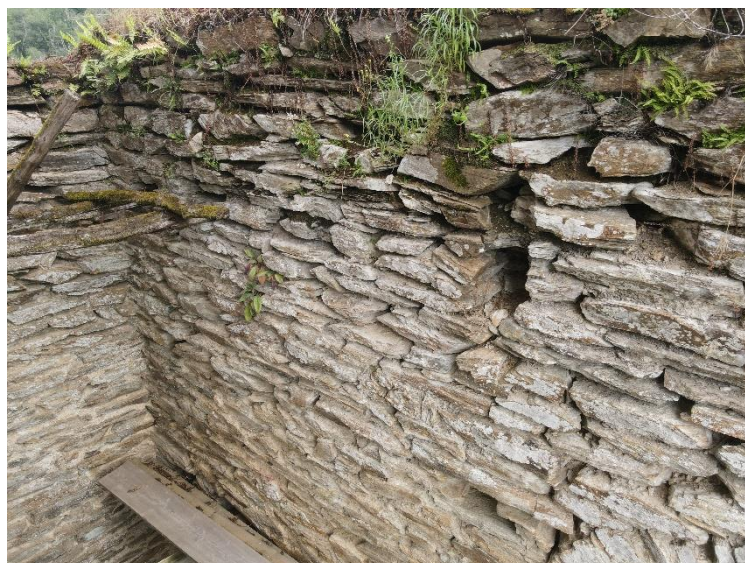
Fig. Encoches pour poutre dans M7, niveau de plancher intermédiaire, ajouté, façonné. Crédit Florence Guillot.
