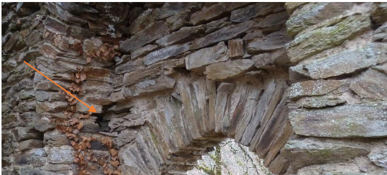
Fig. P2 interne (M7). Linteau et encoche de boiserie de porte (enc 21) dans la voûte. Crédit CDAT.
