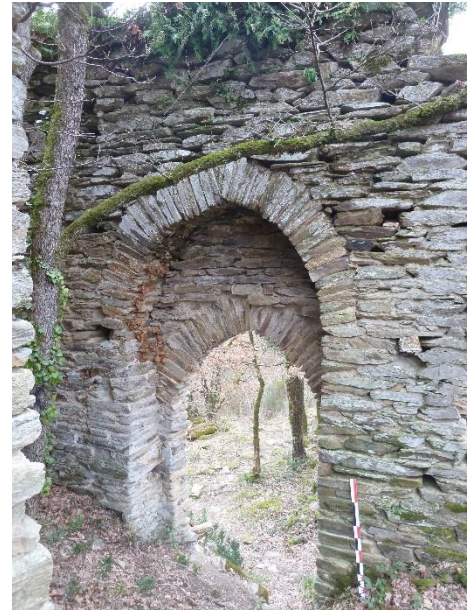
Fig. P2 interne (M7). État juste après le débroussaillage et avant le sondage 2019. Crédit CDAT.
