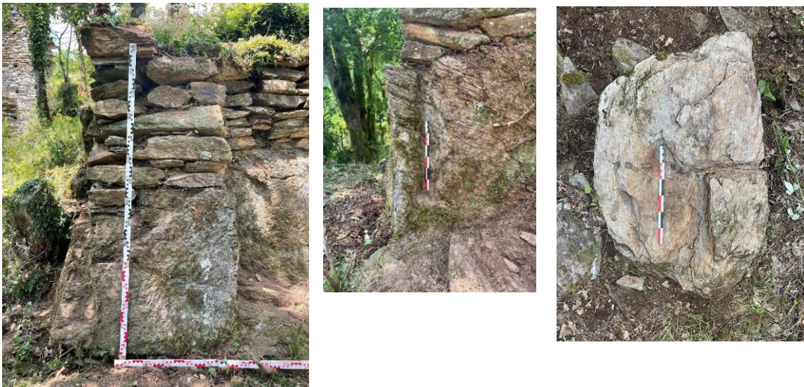
Fig. M8. Montant nord-ouest de l'entrée dans le bâtiment, rainure dans le substrat dans le montant et lauze retrouvée à proximité. Crédit Florence Guillot.
