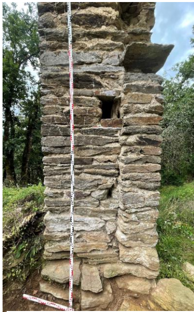
Fig. M1a. Piédroit P1. Trou de barre et emplacement d'un gond. Dalles de l'ancien seuil, sous le piédroit. Crédit Florence Guillot.
