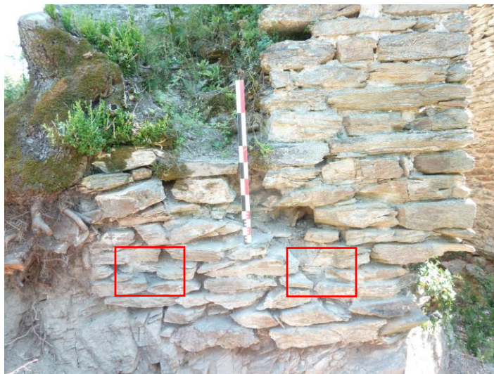
Fig. Mur 10 sud-ouest, parement externe, empochements creusés. Sondage 2019. Crédit CDAT.
