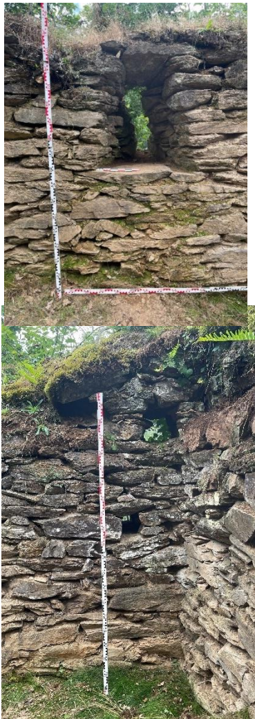
Fig. M9. Jou2 (ouverture) et mur est, parement interne. Notez la grande encoche près de l'angle sud-est. Le pointillé orange est à l'emplacement du platelage de l'échafaudage encastré. Crédit Florence Guillot.
