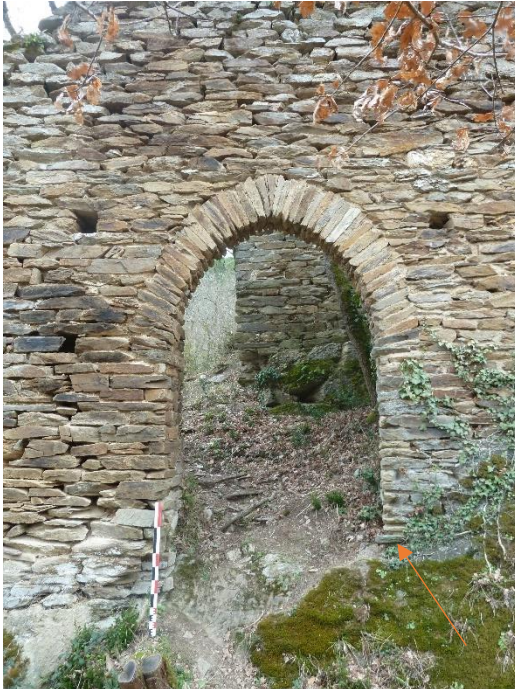
Fig. P2 externe (M7) ; aspect juste après le débroussaillage. Notez le rocher en forte pente et la pierre à la base du piédroit (niveau du seuil?). Crédit CDAT.
