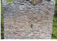
Cependant, les images réalisées en volant entre les deux niveaux de poutres, si elles ne suffisent pas à un montage photogrammétrique 3D, suffisent pour visualiser le mur en partie basse, ainsi que les encoches et donc suffisent pour décrire et étudier le bâti.
