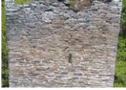
Fig. 12. Exemples de murs du XVe siècle. En haut, parement interne du M9 face est. Il est monté à la terre. Notez l'ouverture à simple ébrasement et l'encoche au-dessus qui pourrait être celle d'un hourd car ce mur est en situation d'enceinte de la plateforme castrale. En bas, parement interne du M8, face ouest, et pilier taillé de son entrée. Ce mur est en pierres sèches. Crédit Florence Guillot.
