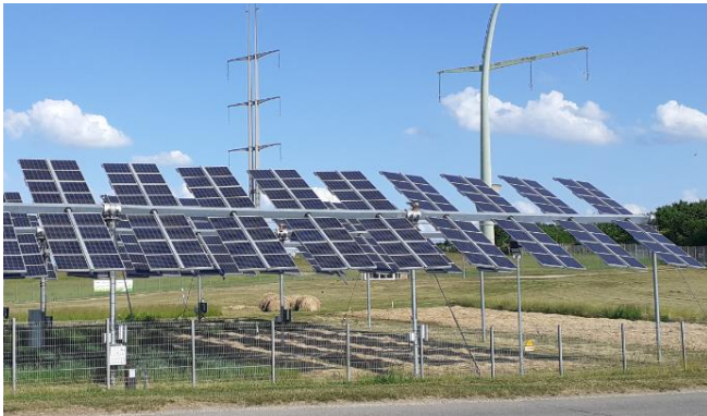
Fig 1 : Exemple de prototype de ferme « Agri-PV » équipée d'onduleurs DC/AC « String » sur le site EDF Lab Les Renardières Moret-sur Loing
