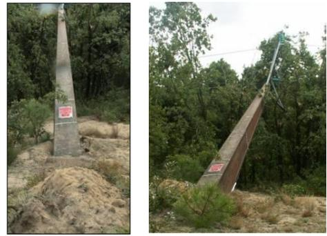
Figure 11 : Chute d'un pylône 63 kV dans les Landes pour problème de fondation lors de la tempête RENATE en 2006
