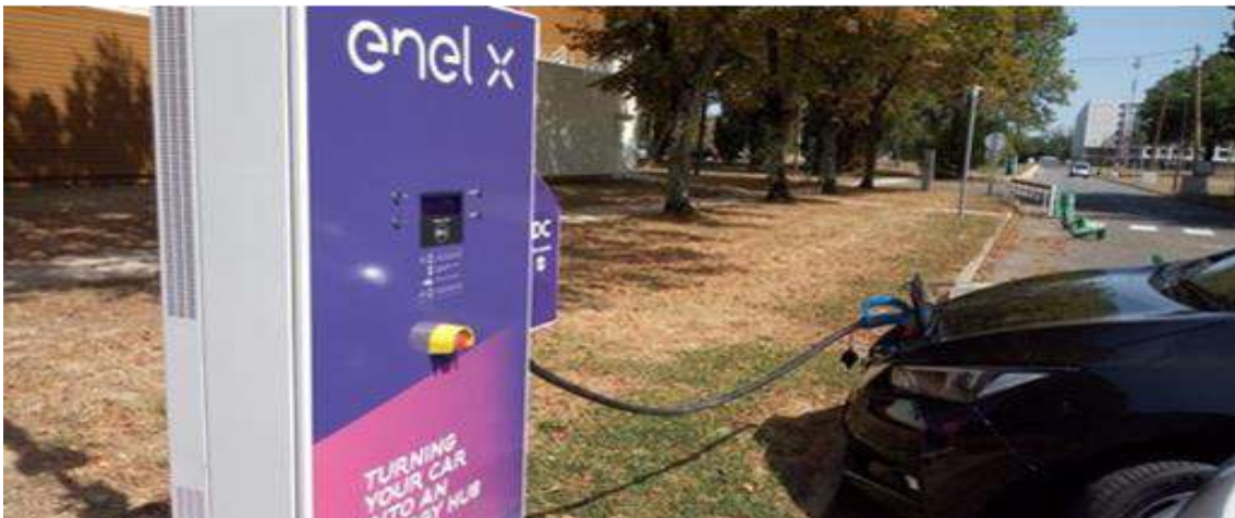
Un des smartbuildings du campus de l'Institut Polytechnique de Paris connecté à une borne en charge et décharge d'un véhicule électrique en autopartage, avec la ferme photovoltaïque située sur le toit du bâtiment, constituée de panneaux de 6 technologies différentes et 3 types d'agencements. © Jordi Badosa.
