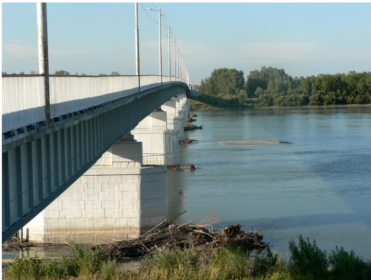
Photo 19 Les avant-becs renforcés des ponts russes, construits pour résister à la débâcle Cliché L. Touchart, août 2011
