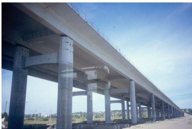
Photo 22 Le pont de l'Académie à Irkoutsk, un ouvrage de plus de quatre kilomètres résistant à la débâcle Cliché L. Touchart, août 2004
