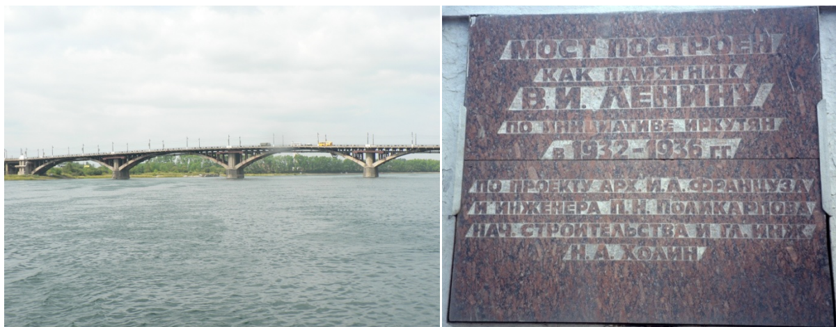
Photos 21 La difficulté de construction des ponts sur l'Angara, l'exemple d'Irkoutsk Clichés L. Touchart, août 2005 et août 2004
