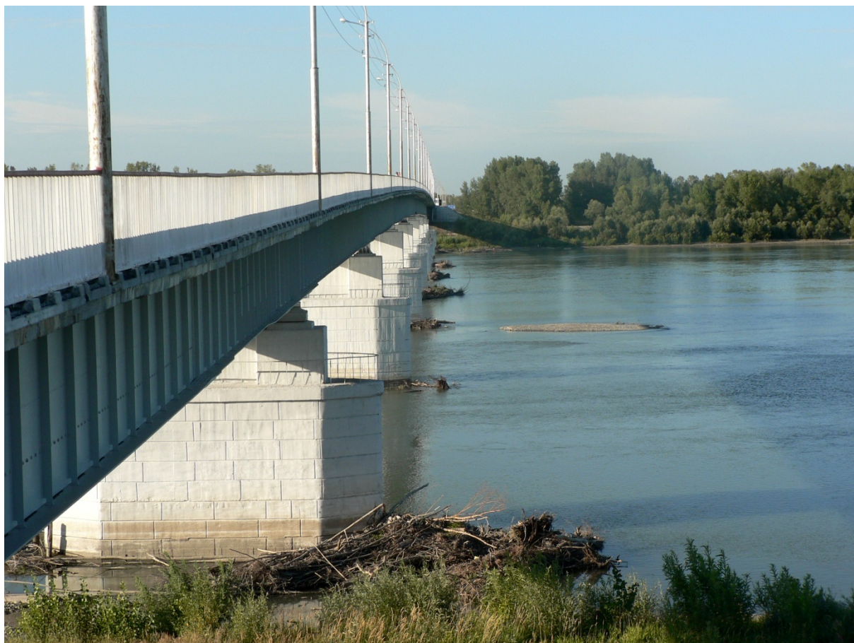
Photo 19 Les avant-becs renforcés des ponts russes, construits pour résister à la débâcle Cliché L. Touchart, août 2011
