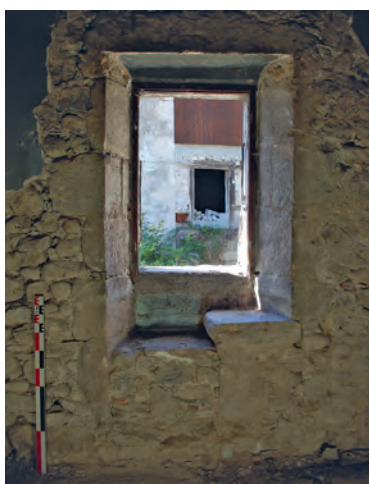
Fig. 5. Baie à coussiège dans l'étage d'habitat du bâtiment B.
