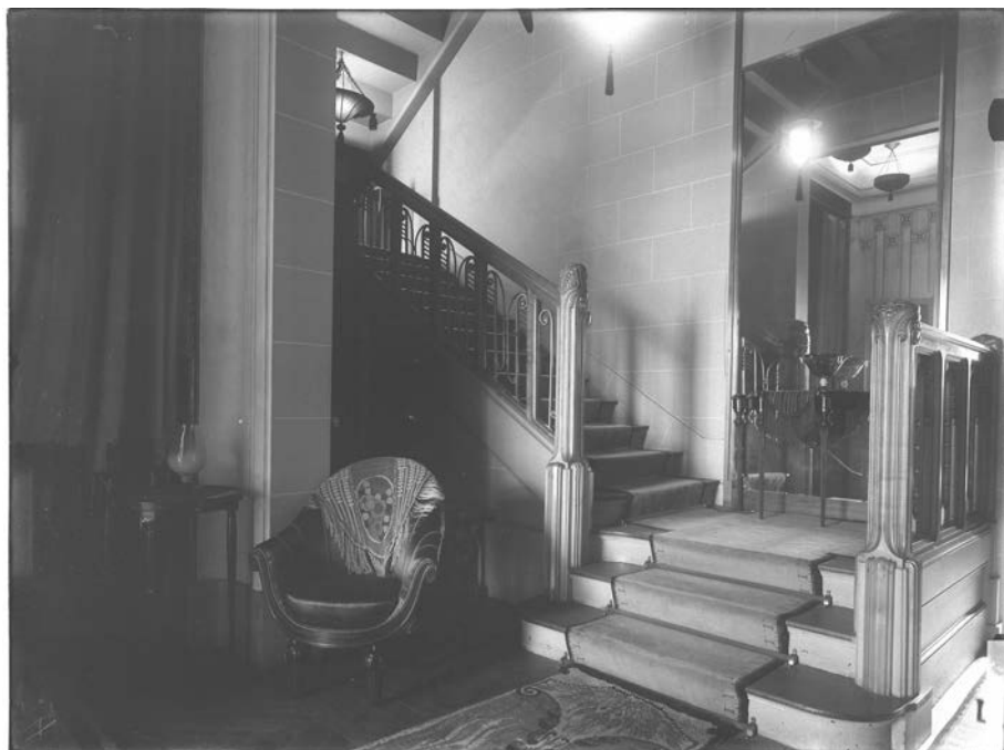
Fig. 4 : ibid. , départ d'escalier.
