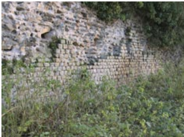
Fig. 3 Mur de courtine en opus vittatum . Vue du parement extérieur du rempart à une vingtaine de mètres à l'ouest de la porte d'Arroux (cliché V. Barrière).
