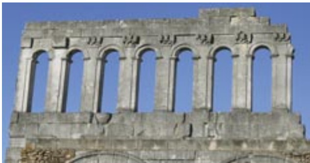
Fig. 4 Porte d'Arroux. Vue du revers de la façade au niveau de la galerie supérieure : les blocs de chapiteaux sont bruts ou seulement épannelés (cliché V. Barrière).
