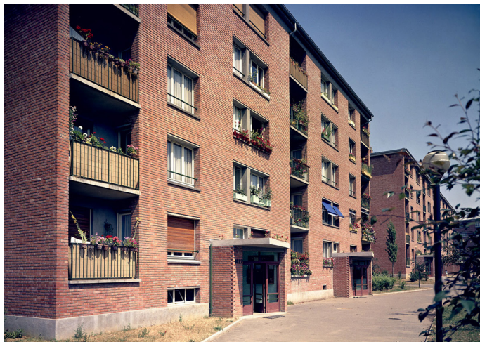
Figure 1 : Immeubles collectifs de la Cité de la Plaine en 1964 (à gauche) et après la rénovation thermique (à droite) © Patrick Roux, 1964 / étudiants du groupe de PFE, 2018
