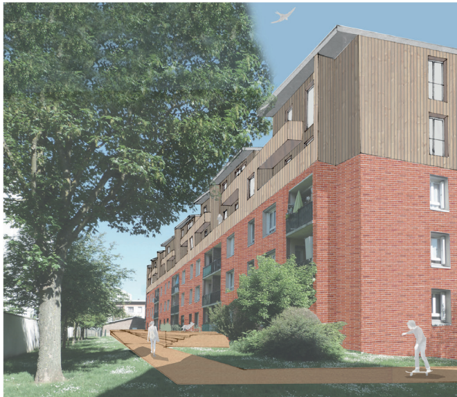
APRES Surélévation d'une bare en R+2 type EF
