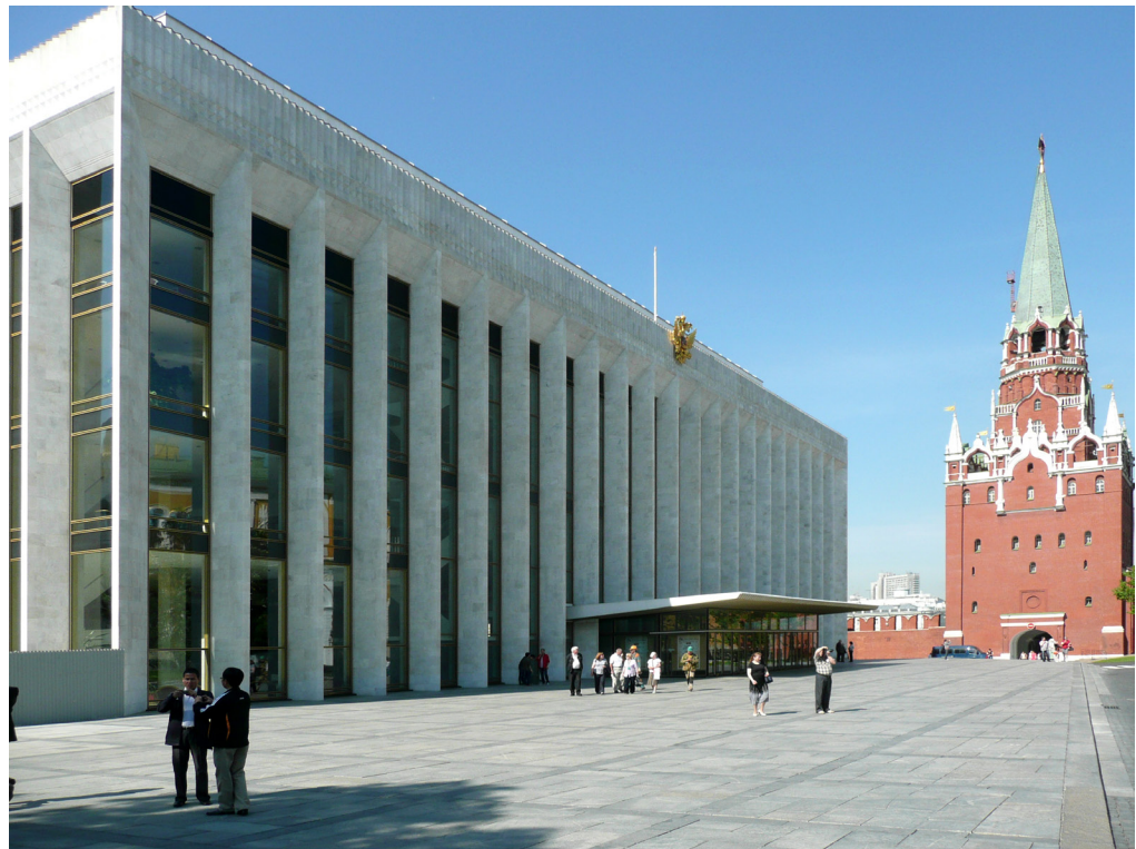
Figure 3 : Vladimir Apichkov, Bâtiment N°14 du Kremlin, 1932 (détruit en 2014) © F. Bellat, 2011
