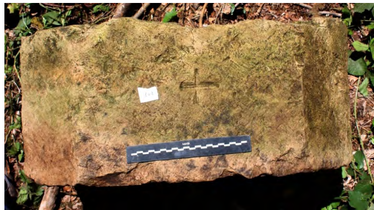
Figure 207: Claveau pierre n°2 – face latérale
