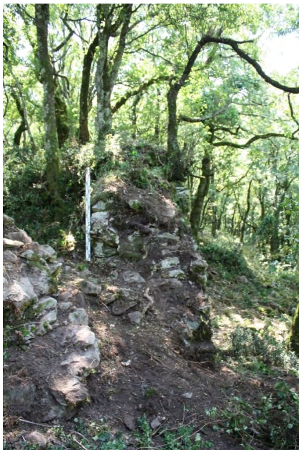
Figure 212: Angle nord-ouest de la tour (effondré)
