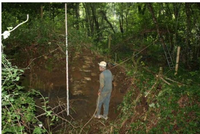
Figure 200: Un effondrement du « toit » de la galerie souterraine de jonction des deux entités de la mine Pennaroy a révélé une coupe idéale d’un des murs de la « cellae » n°1.
