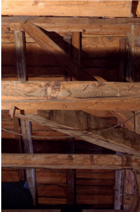
Fig 80 : Lien entre la faîtière et le poinçon de la ferme 1. Cliché : Equipe de fouille.
