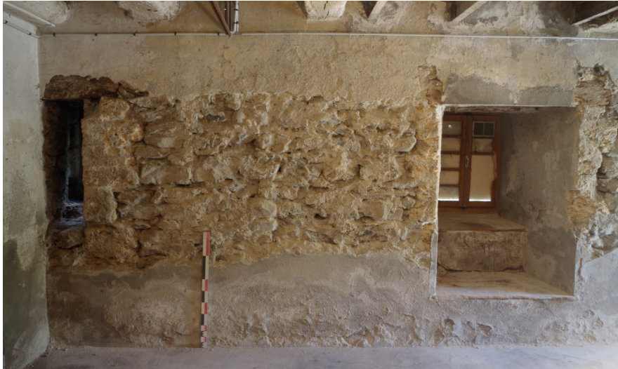
Fig 22 : Parement ouest du mur M 1003 (ES 0). Cliché : Equipe de fouille.
