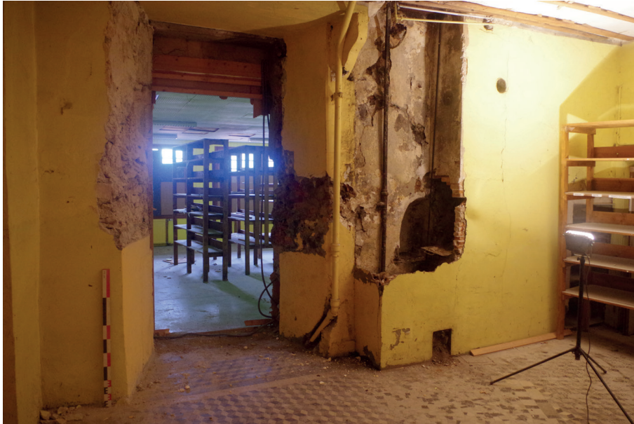
Fig 36 : Vue générale du sondage 1.3. Cliché : Equipe de fouille.
