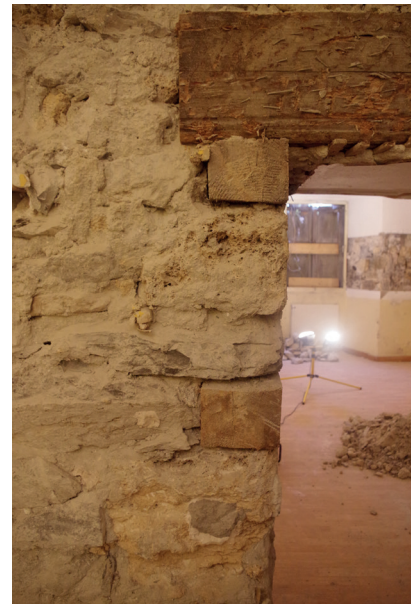
Fig 43 : Insertion de la porte USC 1011.2 . Cliché : Equipe de fouille.
