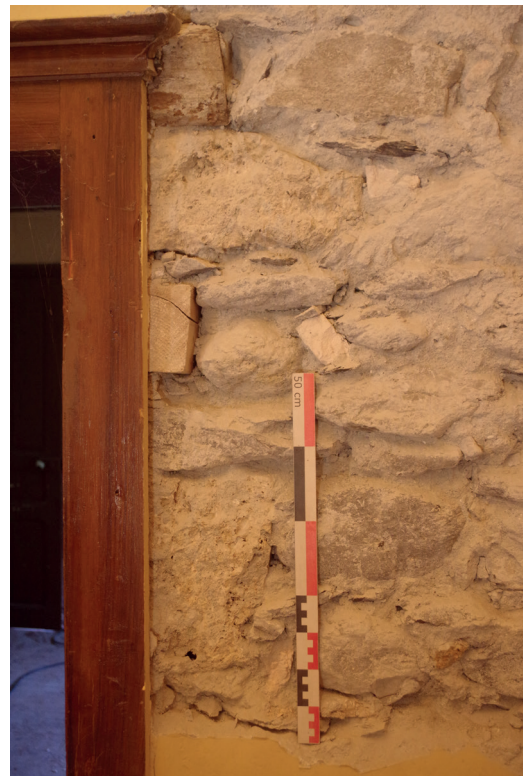
Fig 59 : Césures au niveau de la porte du mur M 1013. Cliché : Equipe de fouille.
