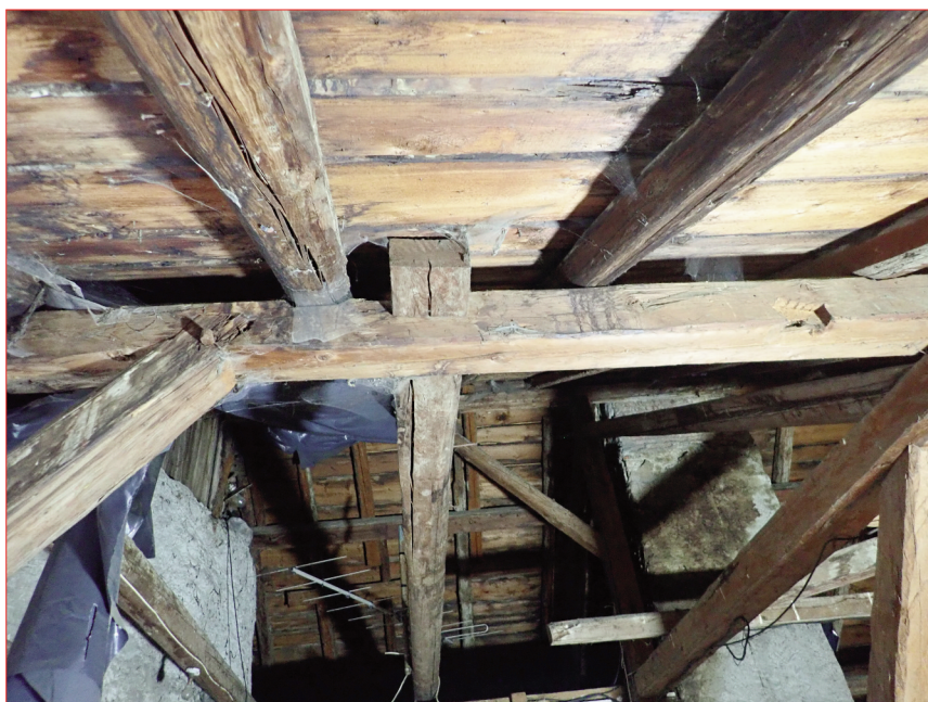
Photo 7 (en haut) : Bracon (en oblique) reliant une entretoise et un entrait retroussé d'une ferme.
