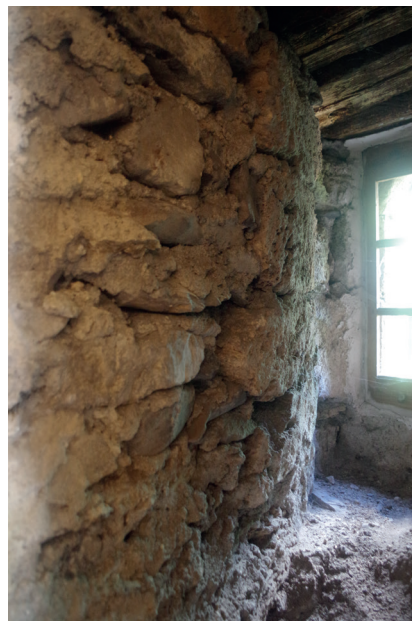
Fig 24 : Baie centrale coupée par le mur de refend d'axe ouest-est. Clichés : Equipe de fouille.
