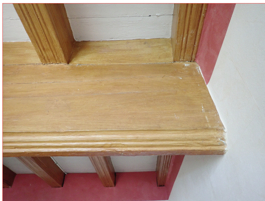
Photo 5 (en haut) : Poutre armée du plafond de la salle ouest du rez-de-chaussée. Photo 6 (en bas) : Poutre armée et solives moulurées d'un plafond d'une salle est du second étage.
