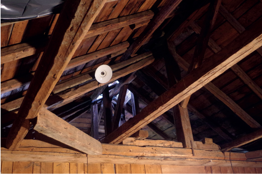
Fig 73 : Faux-entrait et poinçon de la ferme 1. Cliché : Equipe de fouille.
