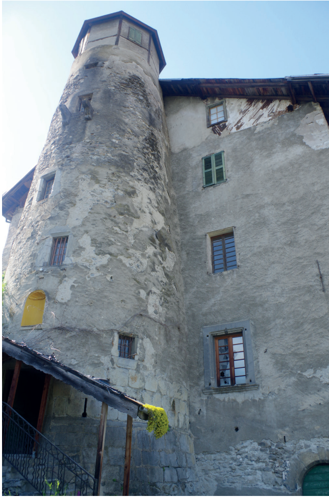
Fig 10 : Tour d'escalier sud. Cliché : Equipe de fouille.
