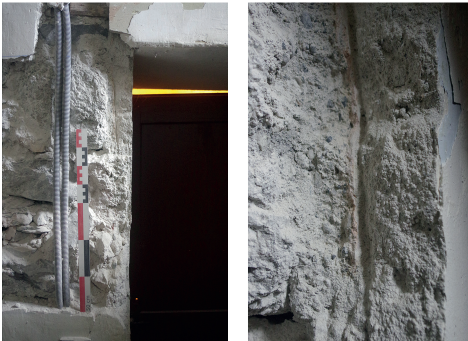
Fig 56 : Doublement de la porte nord ( USC 1010.5 et 1010.6 ).
