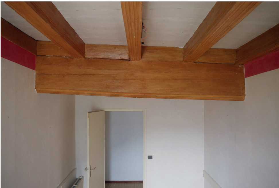
Fig 88 : Poutre armée des pièces centre-est du 2 e étage. Cliché : Equipe de fouille.
