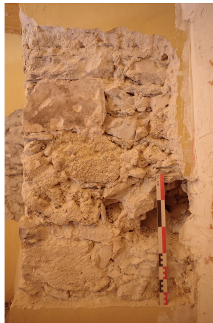
À gauche : Fig 49 : Insertion du tableau sud de la fenêtre USC 1005.7. Cliché : Equipe de fouille.
