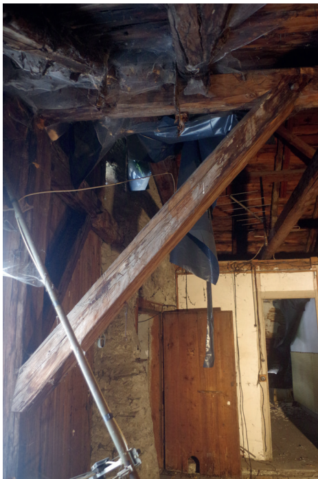
Fig 82 : Lien entre le pignon sud et la panne orientale. Cliché : Equipe de fouille.
