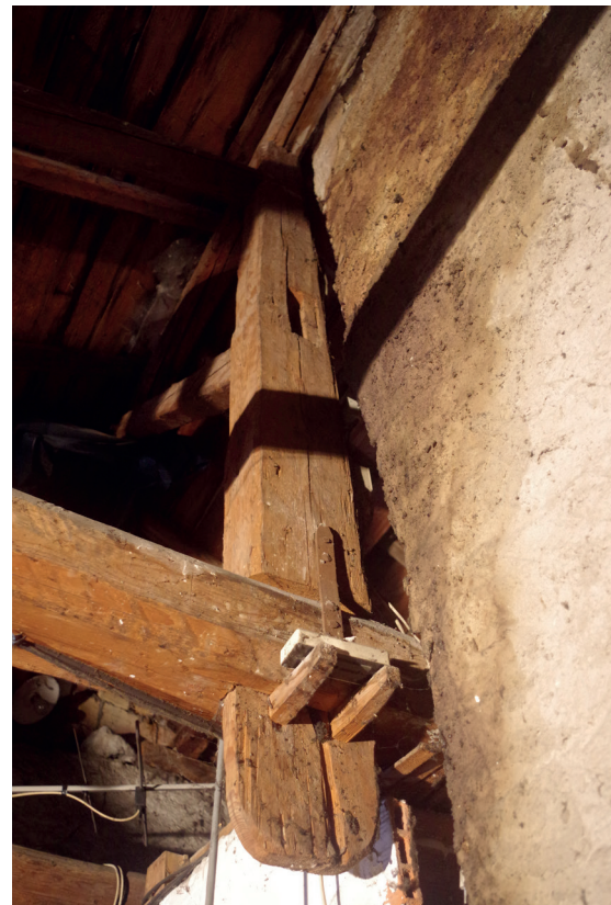
Fig 72 : Poinçon de la ferme 2. Cliché : Equipe de fouille.
