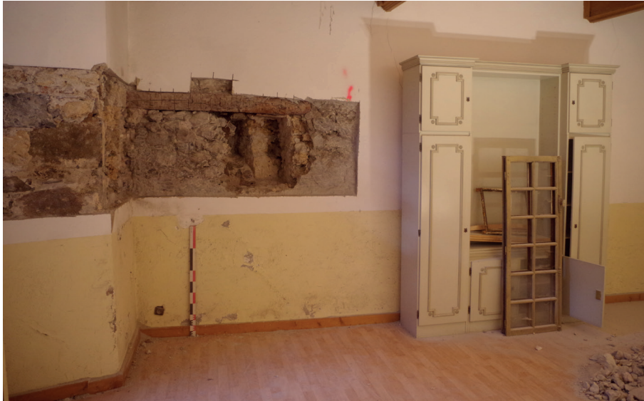
Fig 31 : Vue générale du sondage 1.2. Cliché : Equipe de fouille.
