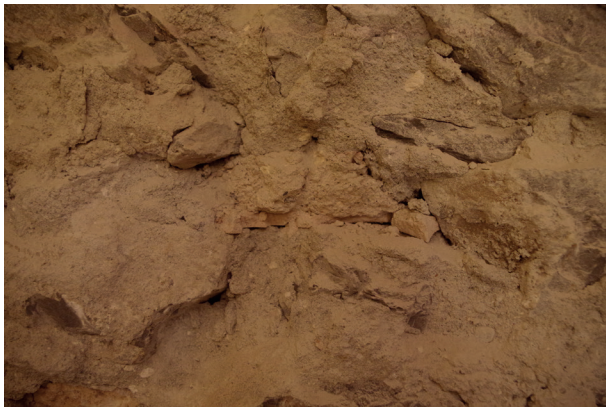
Fig 42 : Enduit de gréa en remplois. Cliché : Equipe de fouille.
