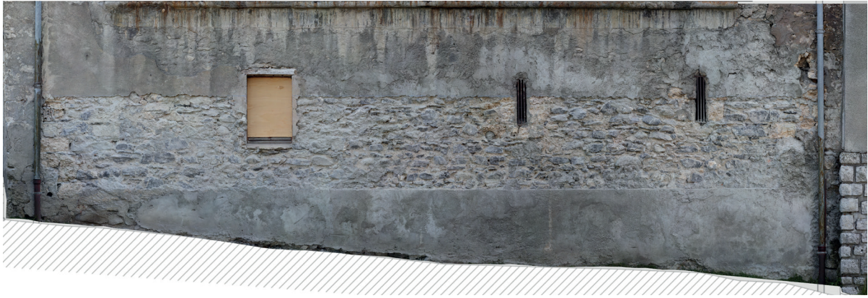
Fig 17 : Vue générale du sondage 0.2. Ortho-image : O. Veissière.
