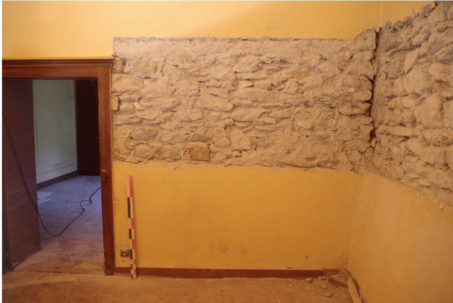
Fig 57 : Vue générale du sondage 2.3. Cliché : Equipe de fouille.
