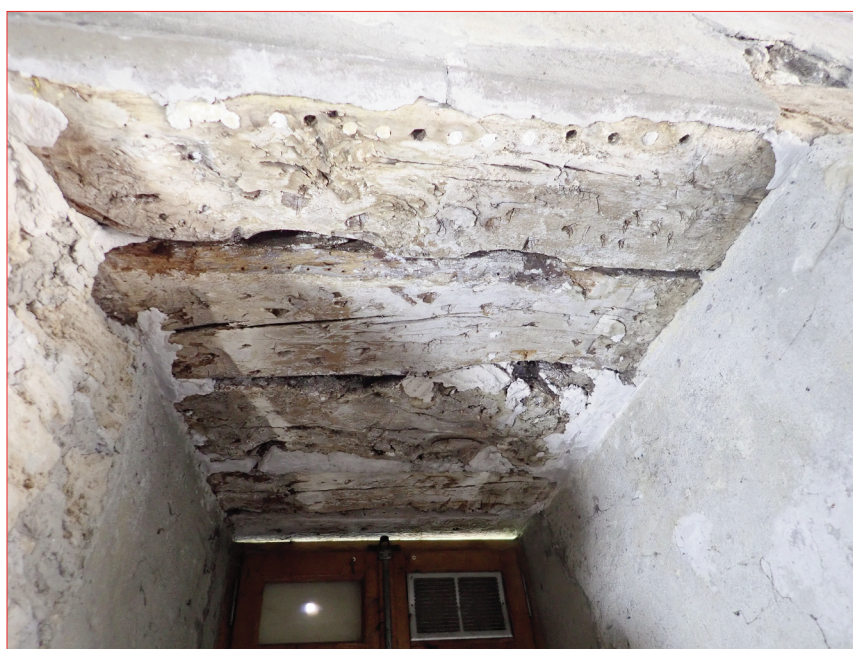
Photo 3 (en haut) : Vue depuis le sous-sol de la baie sud.
