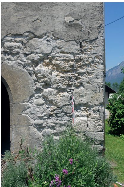
Fig 15 : Chaîne d'angle sud-est du mur M 1002 (USC 1002.1). Cliché : Equipe de fouille.
