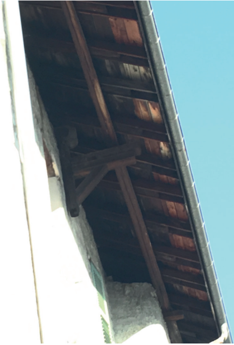
Fig 85 : Panne volante et corbeaux en façade Est. Cliché : Equipe de fouille.
