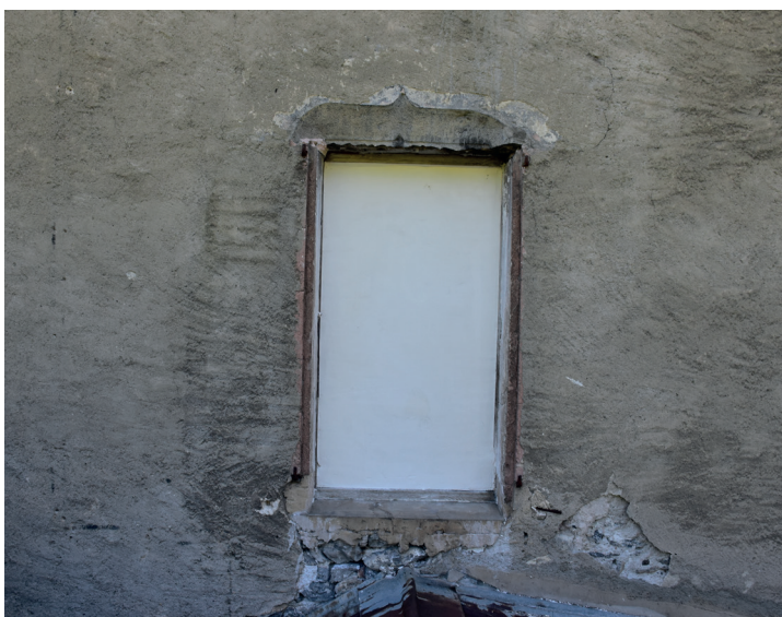
Fig 51 : Linteau à accolade visible en extérieur (USC 1005.7). Cliché : Equipe de fouille.
