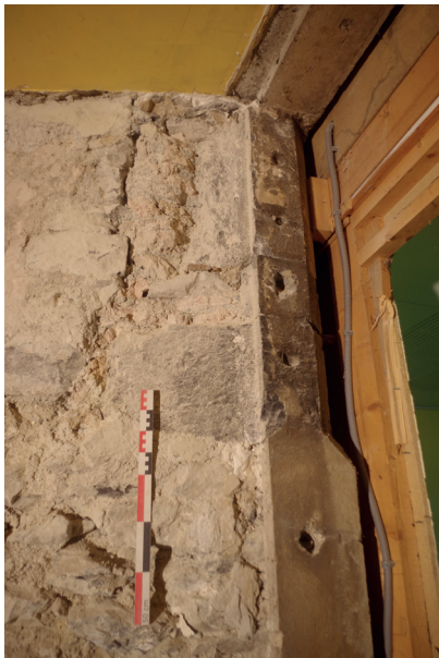
Fig 37 : Insertion d'une baie en calcaire noir de Sixt. Cliché : Equipe de fouille.
