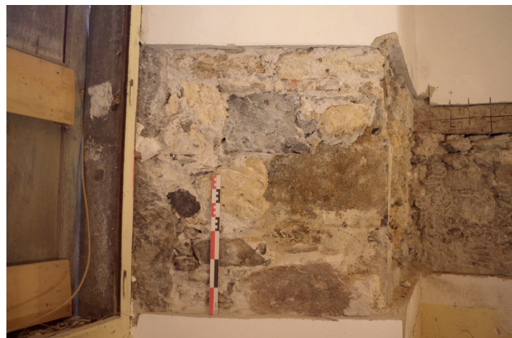
Ci-dessous Fig 30 : Superposition de deux tableaux de fenêtre. Cliché : Equipe de fouille.
