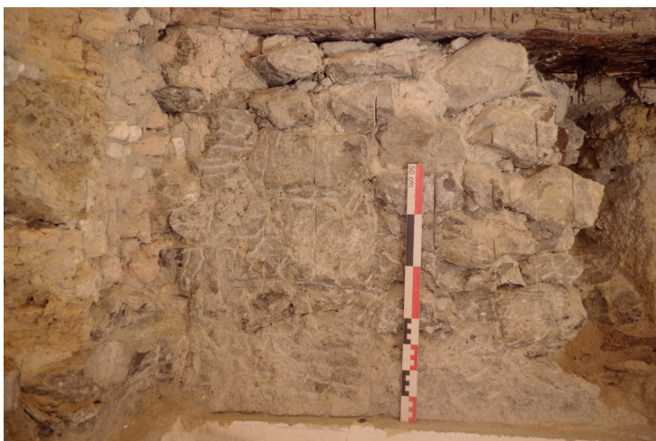
Fig 35 : Bouchage de surface USC 1005.1 . Cliché : Equipe de fouille.
