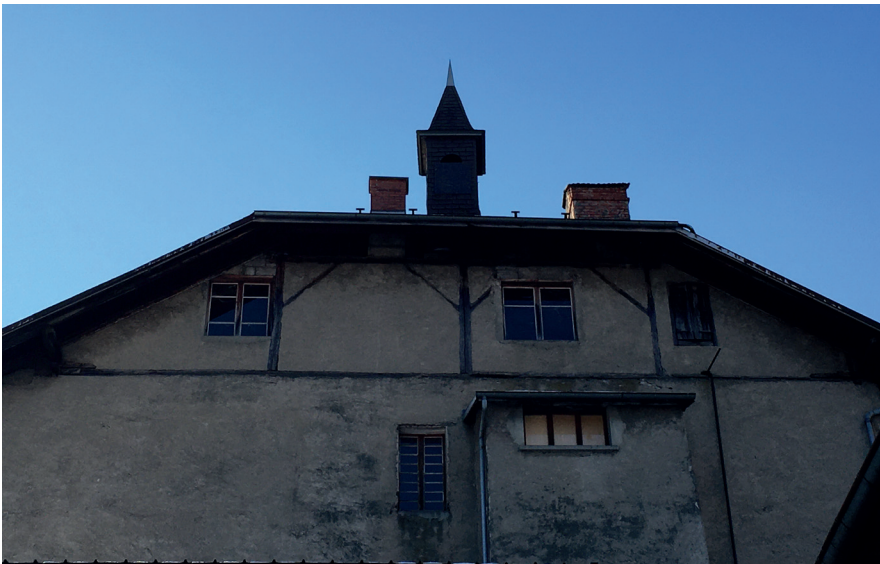
Fig 74 : Pignon nord. Cliché : Equipe de fouille.
