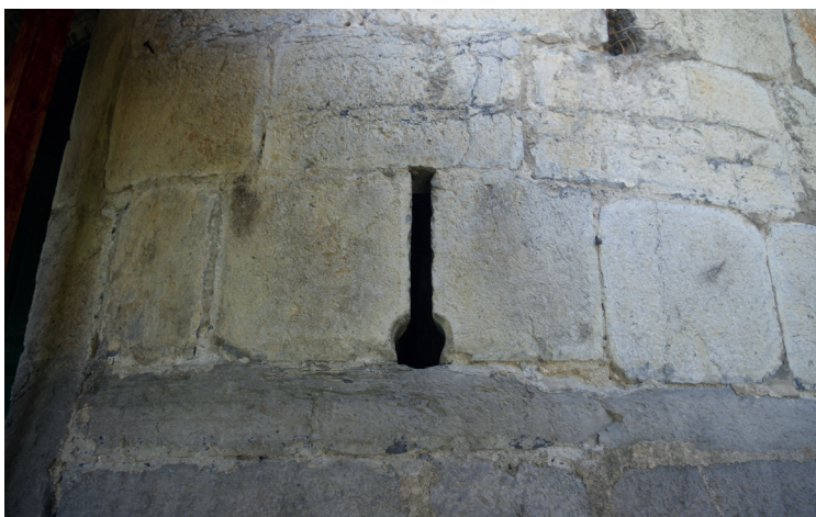
Fig 65 : Archère-cannonnière orientale. Cliché : Equipe de fouille.
