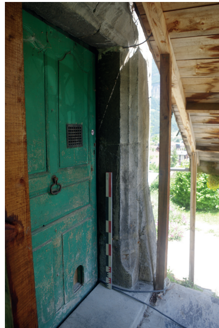
Ci-dessus et ci-contre Fig 64 : Détail de l'USC 1001.2 au centre et piédroit oriental de la porte d'entrée de la tour. Clichés : Equipe de fouille.
