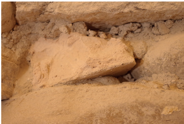
Fig 58 : Remploi de fragments d'enduits de gréa (badigeon visible sur la face inférieure). Cliché : Equipe de fouille.
