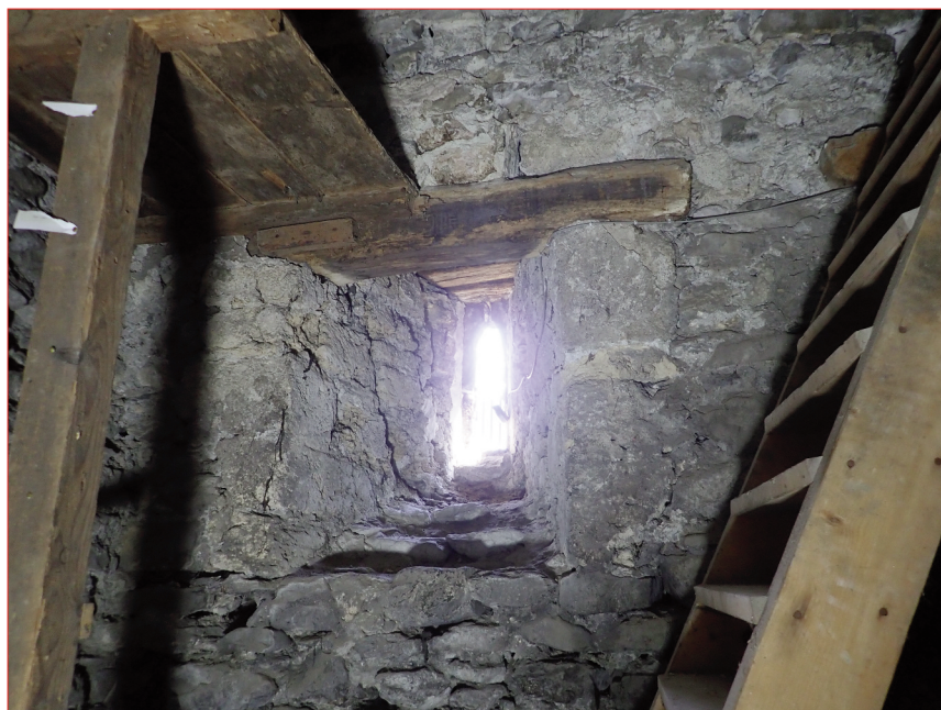
Photo 1 (en haut) : Vue extérieure de la baie ogivale nord. Photo 2 (en bas) : Vue du sous-sol de la baie ogivale nord.
