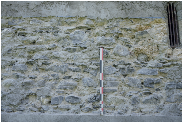
Fig 18 : Détails du parement USC 1003.2. Cliché : Equipe de fouille.
