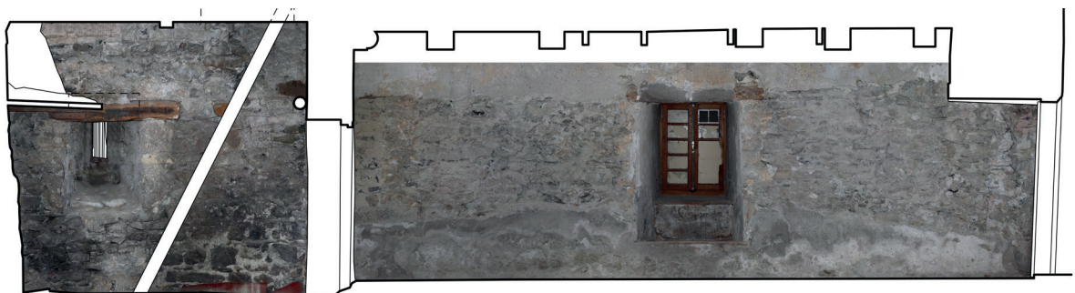
Fig 21 : Vue générale du sondage 0.3. Ortho-image: O. Veissière.
