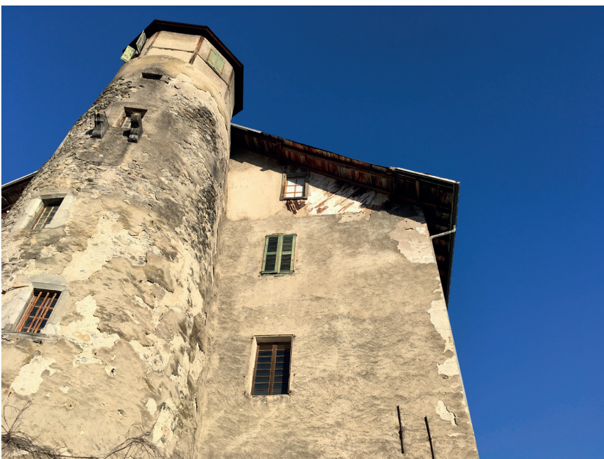
Fig 75 : Pignon sud. Cliché : Equipe de fouille.
