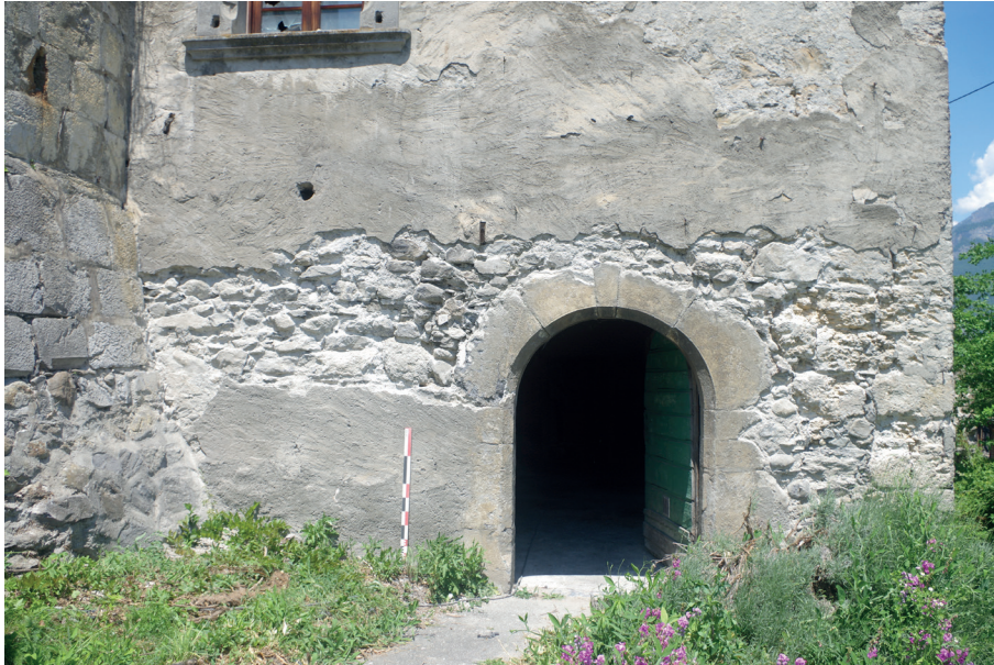
Fig 15 : Chaîne d'angle sud-est du mur M 1002 (USC 1002.1). Cliché : Equipe de fouille.
