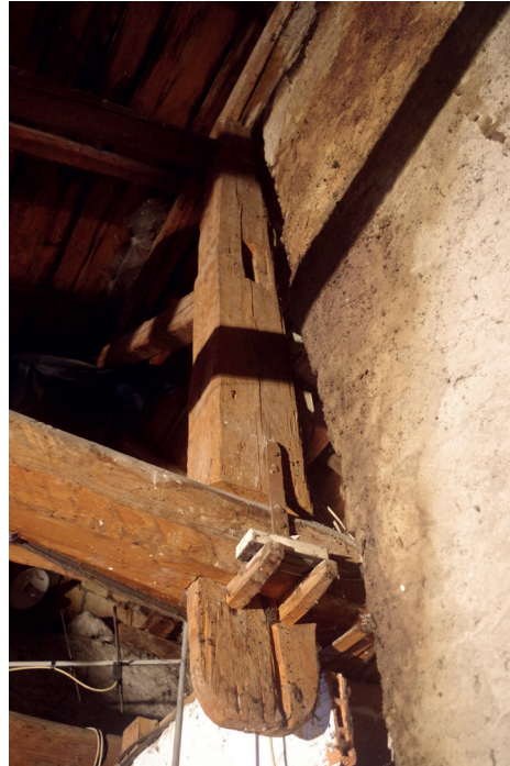
Fig 81 : Poinçon de la ferme 2. Cliché : Equipe de fouille.
