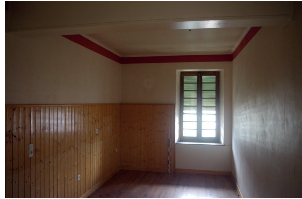
En haut à droite et à gauche Fig 6 : Exemples de pièces à cloisons légères rencontrées dans les étages. Clichés : Equipe de fouille.
