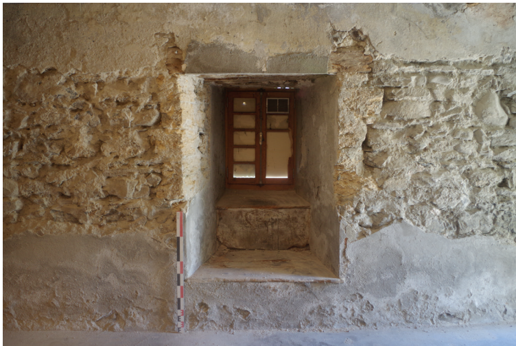
Fig 25 : Baie sud de M 1003 (ES 0). Cliché : Equipe de fouille.
