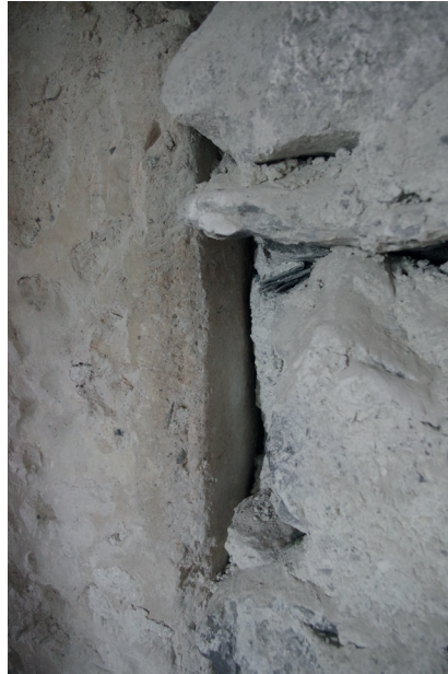
Fig 53 : Enduit de gréa USC 1010.3. Clichés : Equipe de fouille.
