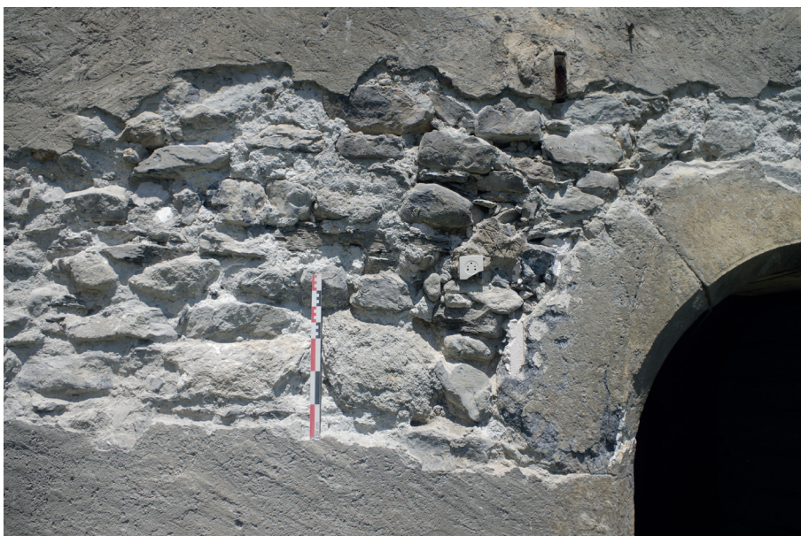
Fig 16 : Jonction entre le parement d'origine et le perçement de la porte. Cliché : Equipe de fouille.
