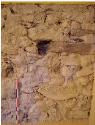
Fig 44 : Potentielle structure dans le mur de refend M 1011 (USC 1011.3). Cliché : Equipe de fouille.
