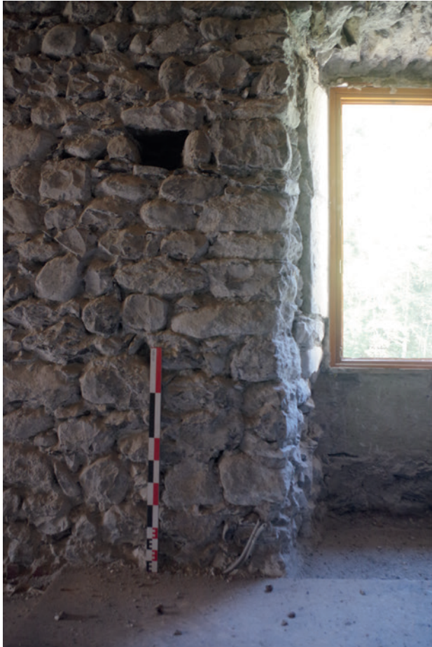
Jonction entre le parement de M 1001 et l'embrasure de la fenêtre FEN 1069.
