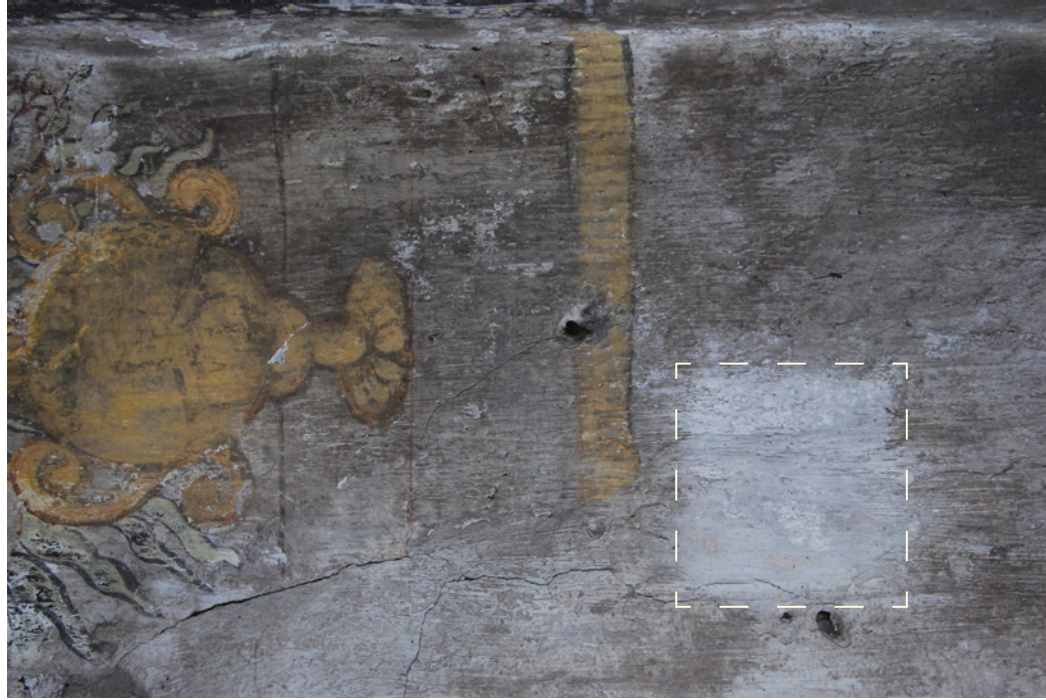
Tests de nettoyage réalisés avec un gel rigide à action chélatante. Élévation ouest.
