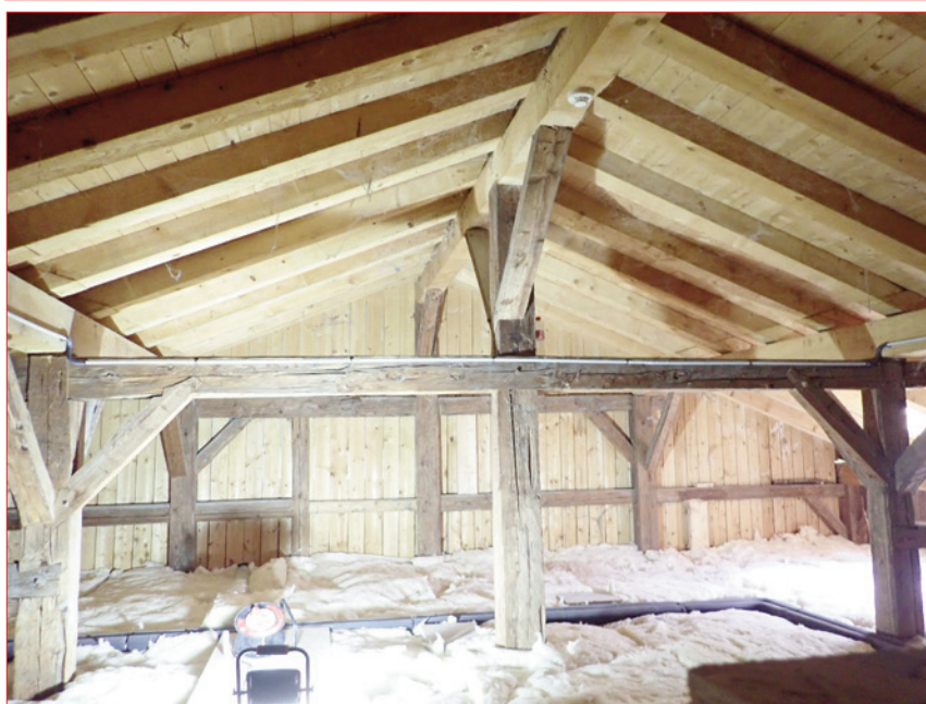
Photo 3 (en haut) : Moulure d'une solive de plafond du premier étage, salle sud. Photo 4 (en bas) : Vue de la charpente, vers l'ouest.
