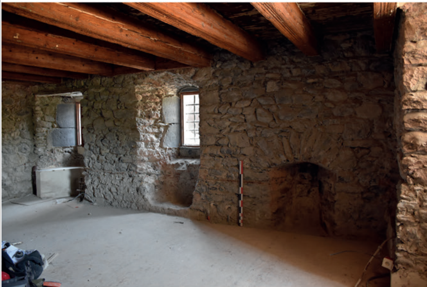
Parement de l'état 1 à assises réglées.
