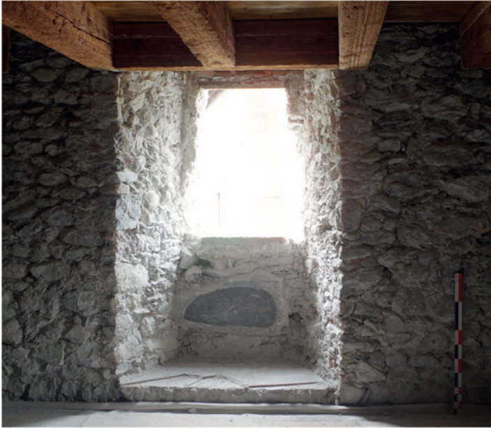
Insertion de la fenêtre FEN 1046.
