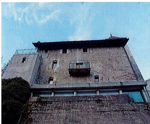
Façade sud en 2004.
