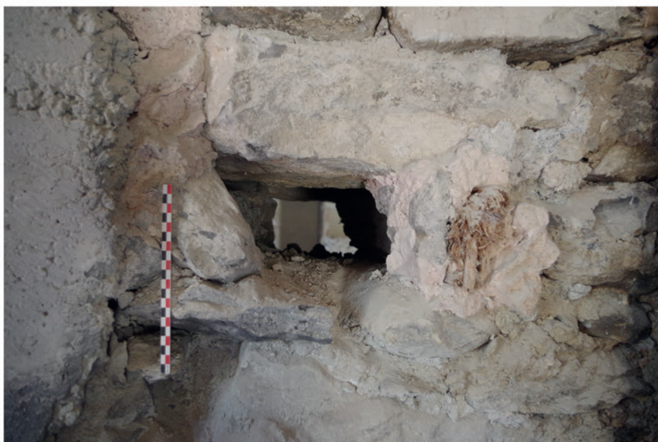
Vestiges de bois, potentiellement en lien avec le chevêtre situé au-dessus.
