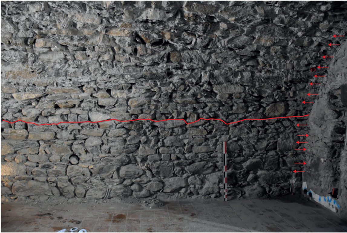
Jonction entre voûte et parement d'origine.
