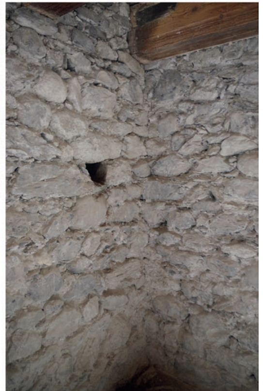
Chaînage entre les murs M 1002 et M 1003.
