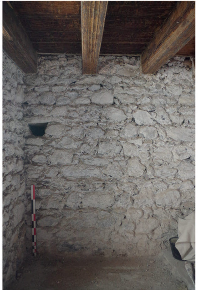
Mur gouttereau sud (M 1001).
