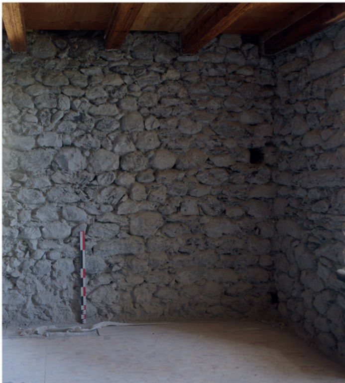
Parement de M 1003 et chaînage avec M 1002.
