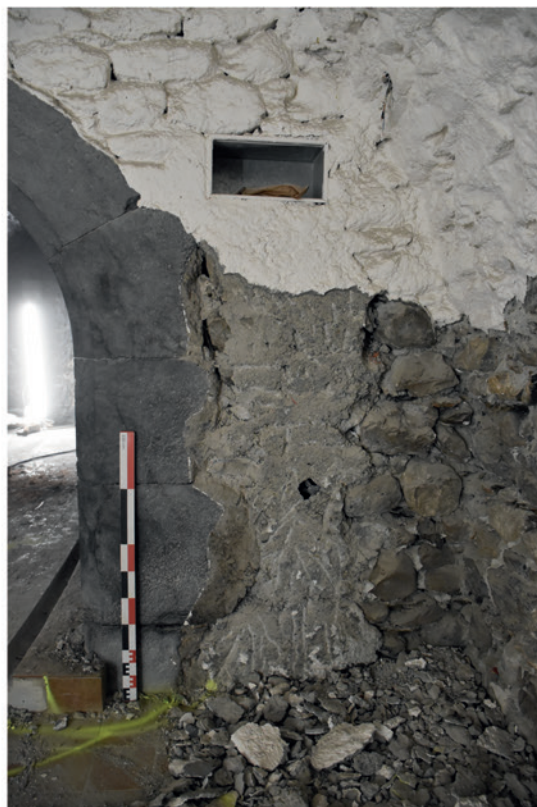
M 1017: Tranchée pour la VMC.
