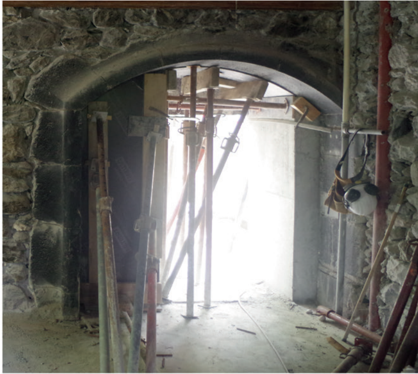
Porte POR 1040 percée dans un ancien placard.
