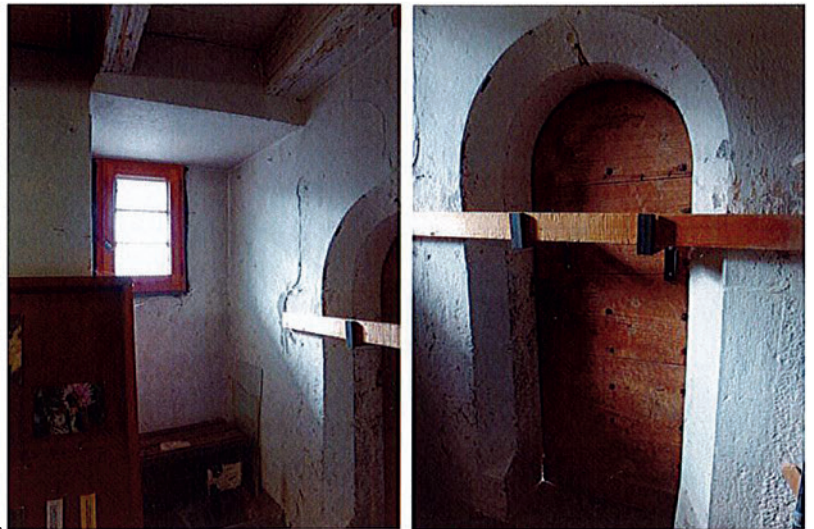
Accès à la tour sud-ouest en 2004.
