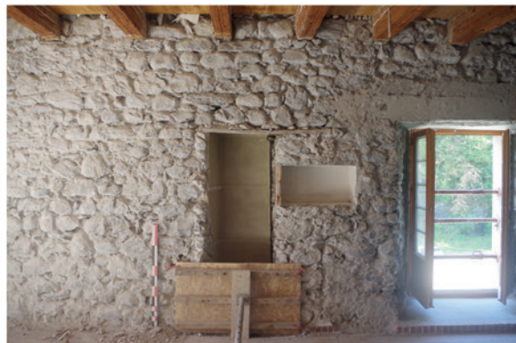
Complexe OUV 1070/1071 (vue intérieure).
