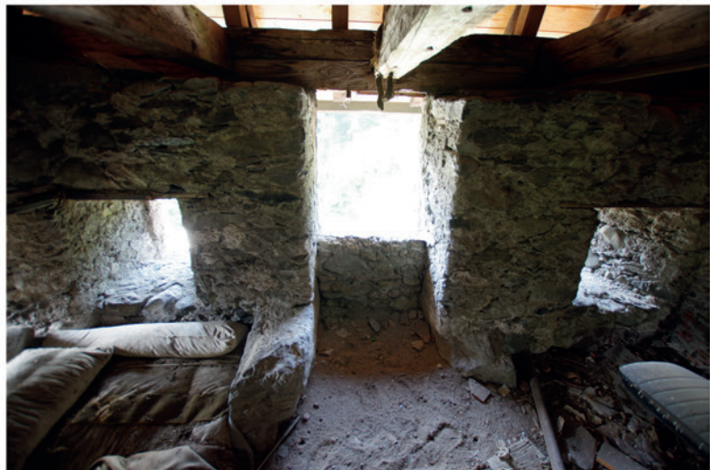
Combles de la tour d'escalier.
