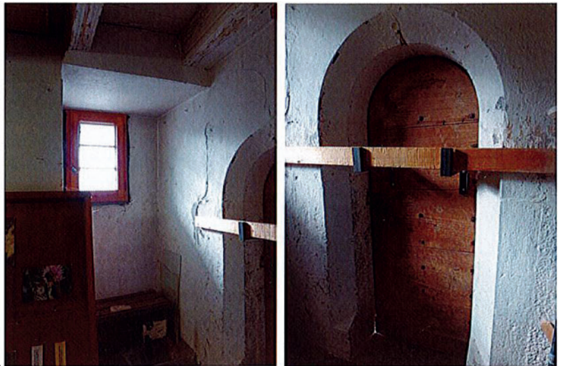
Accès à la tour sud-ouest en 2004.
