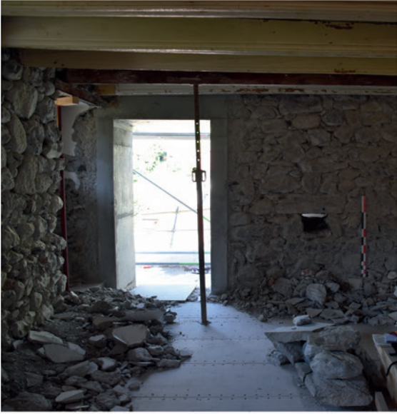
Accès à la tour sud-ouest en 2019.
