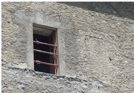
Complexe OUV 1070/1071 (vue extérieure).
