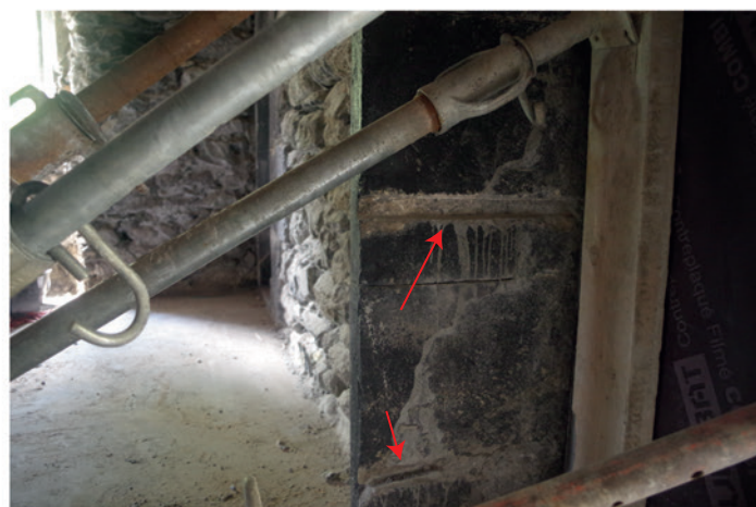
Rainures dans le piédroit de la structure POR 1040.
