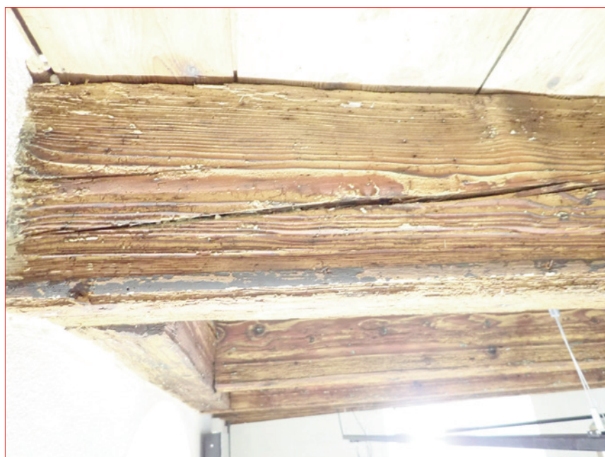
Photo 1 (en haut) : Vue du plafond du rez-de-chaussée, salle nord-est.
