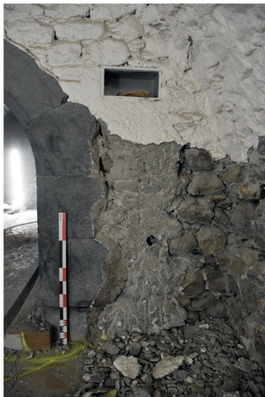
M 1017: Tranchée pour la VMC.
