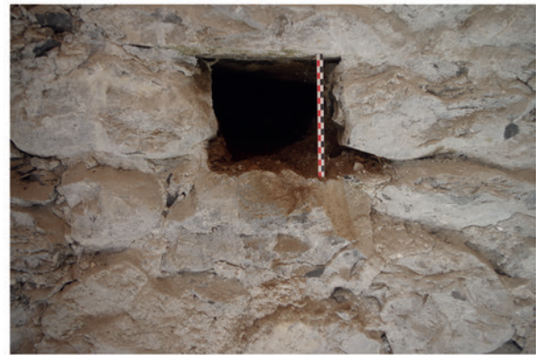
Exemple de trou de boulin au 2e étage.
