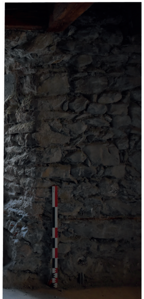
Détail de la chaîne d'angle entre parement et embrasure.
