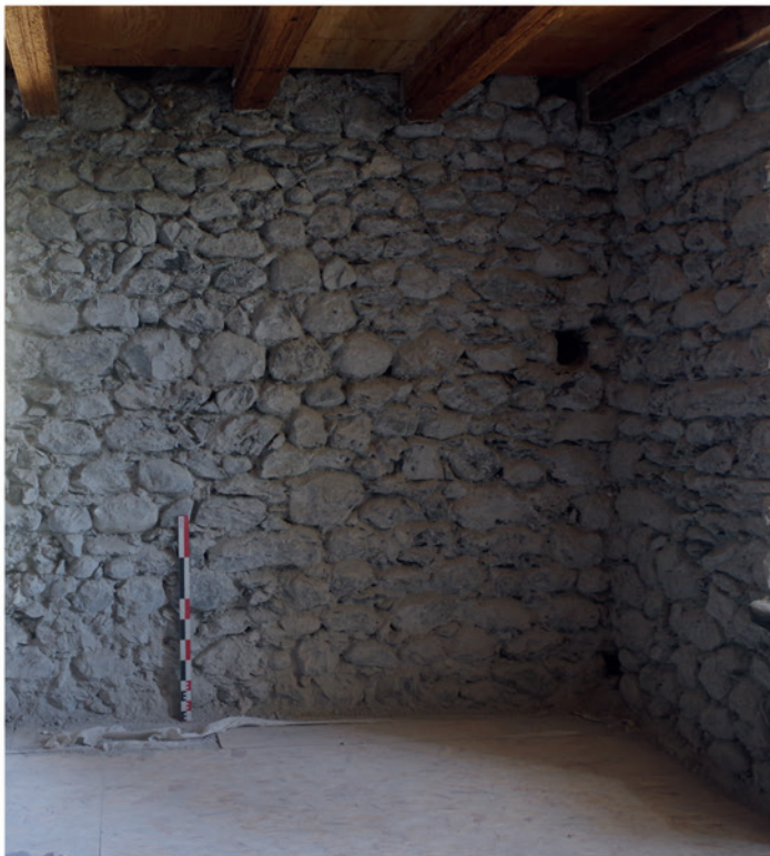
Parement de M 1003 et chaînage avec M 1002.
