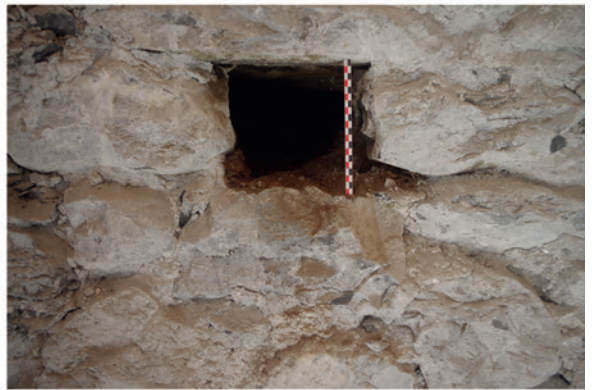
Exemple de trou de boulin au 2e étage.
