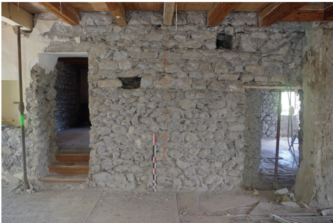
Moitié occidentale du mur M 1016-17 vue du sud.
