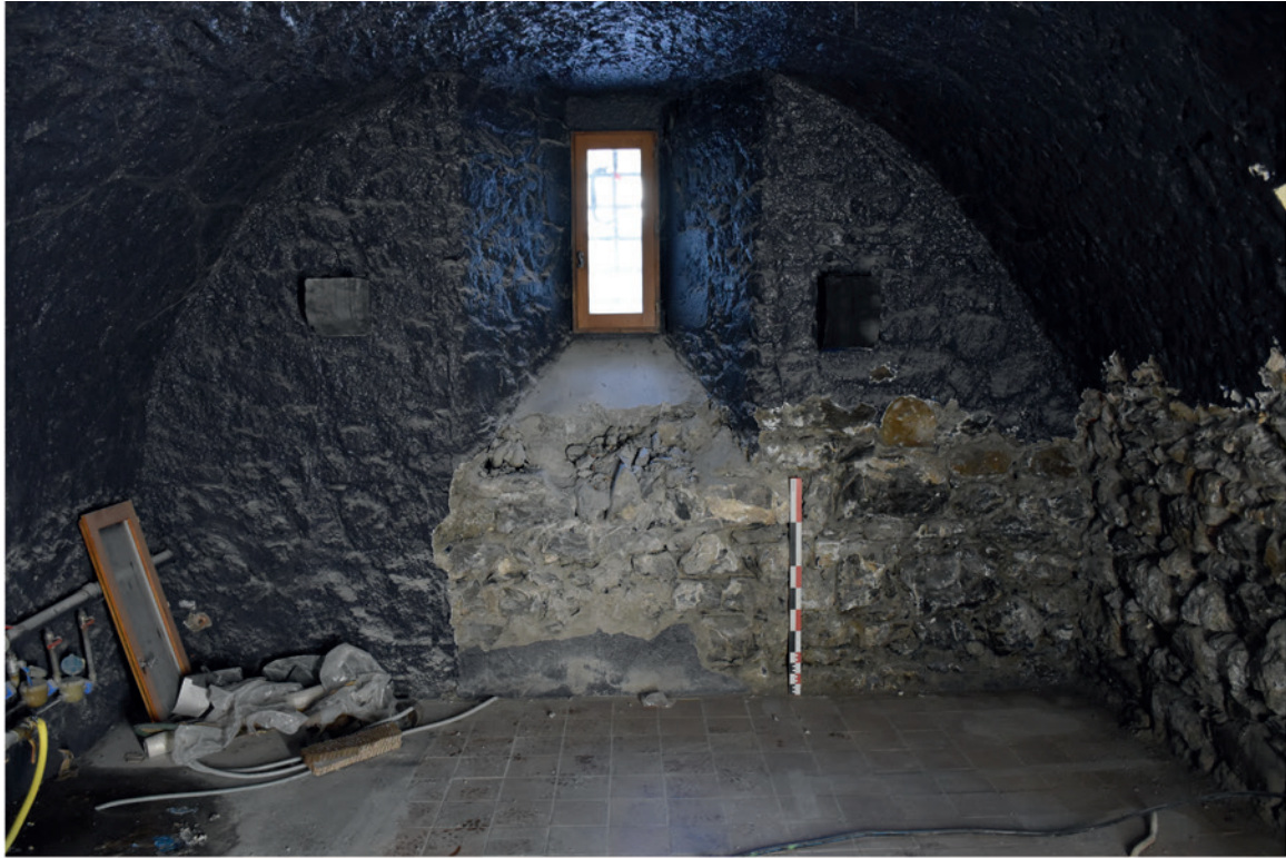
Lot de consoles présente dans la pièce nord-ouest du RdC, sous la voûte.
