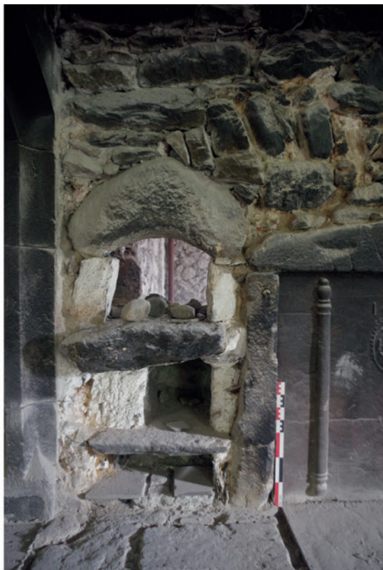
Bouche du four installée dans la cheminée CHE 1041.
