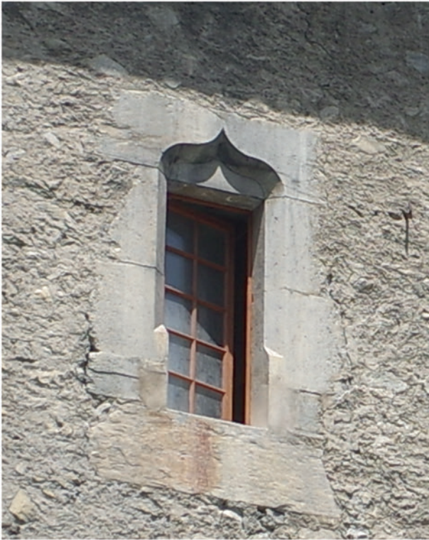
Fenêtre (FEN 1069) à linteau à accolade au 2e étage.
