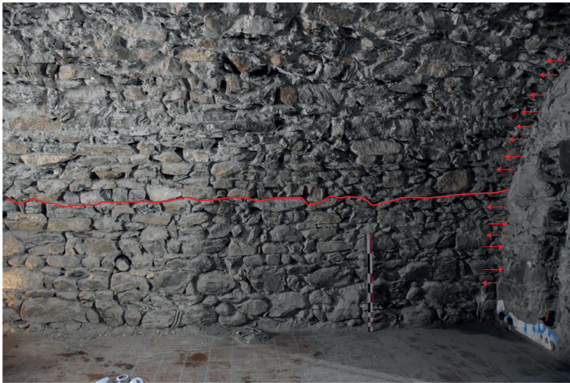
Jonction entre voûte et parement d'origine.
