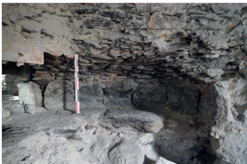
Détail de la voûte du four.
