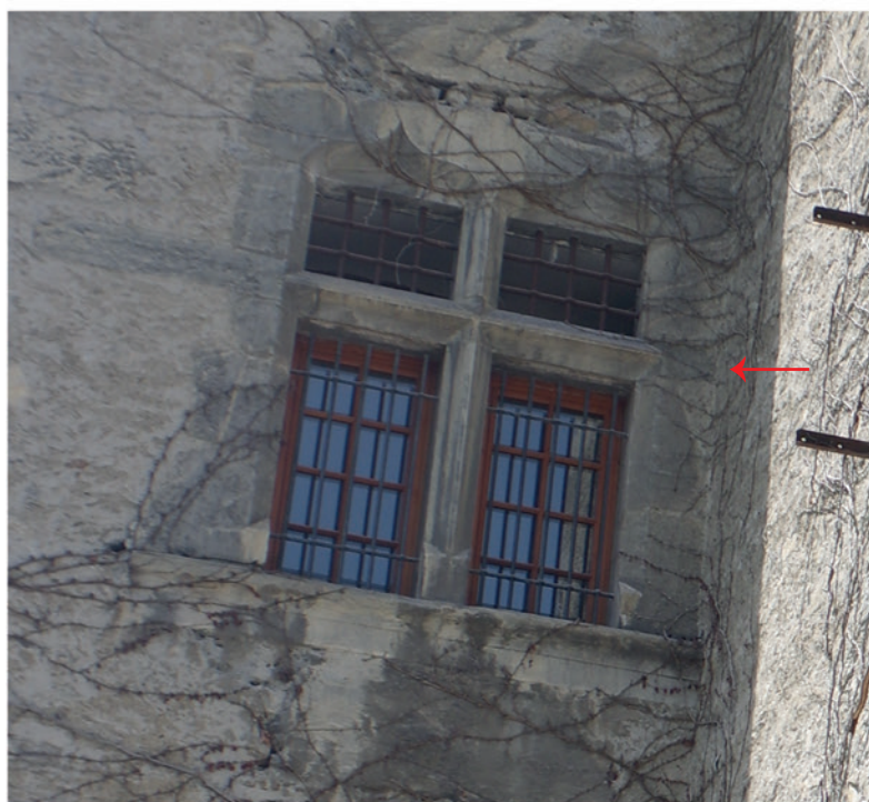
La tour d'escalier s'appuie sur le piédroit nord de la fenêtre FEN 1072.
