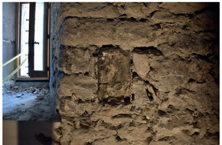
Console buchée dans le mur M 1002
