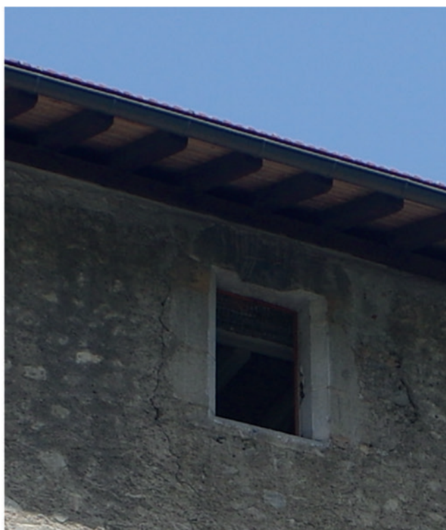
Vue depuis l'extérieur de la fenêtre FEN 1090. Le jambage a été poussé.
