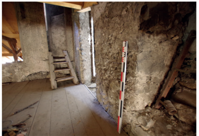
Escalier présent dans les combles et menant aux étages supérieur de la tour d'escalier orientale.
