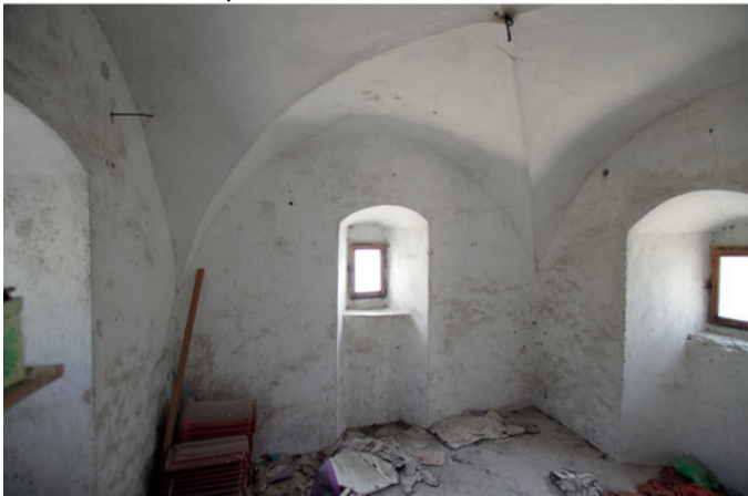
Vue générale (est) de la salle voûtée surmontant la chapelle.
