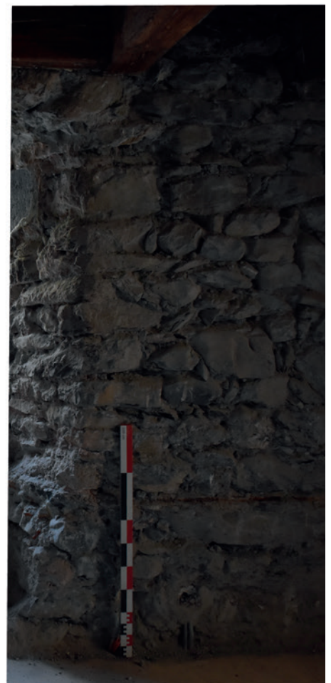
Détail de la chaîne d'angle entre parement et embrasure.
