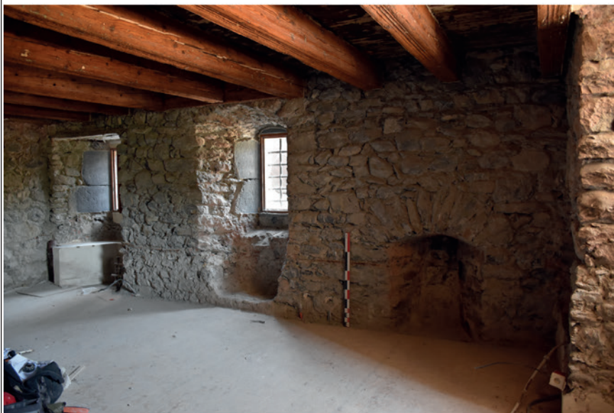
Parement de l'état 1 à assises réglées.
