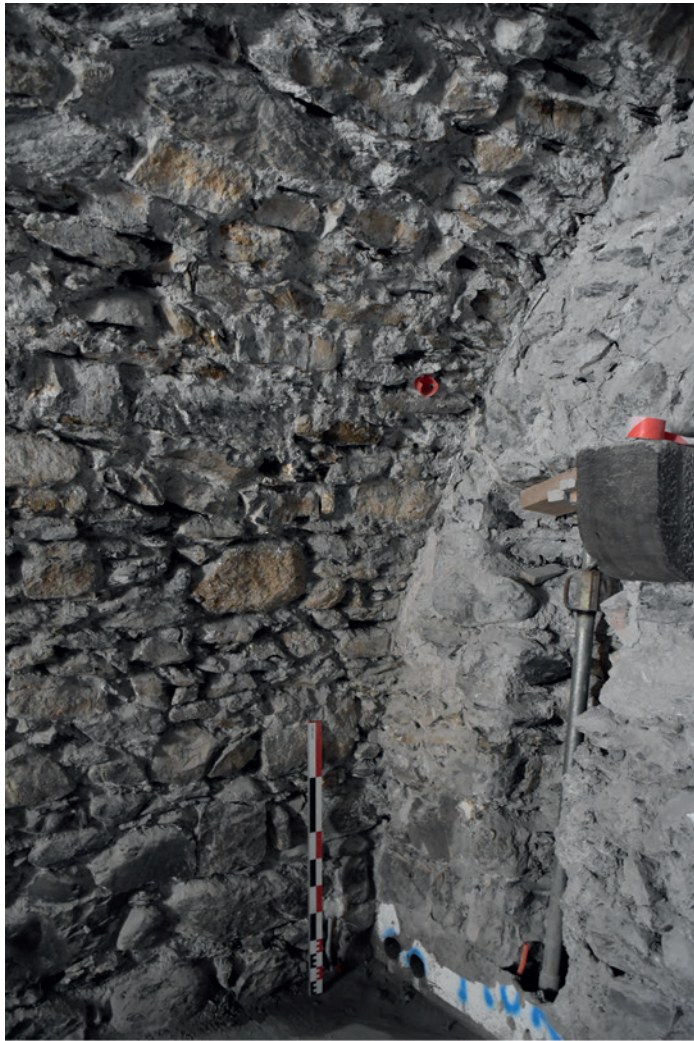
Jonction entre la voûte et le mur adjacent.
