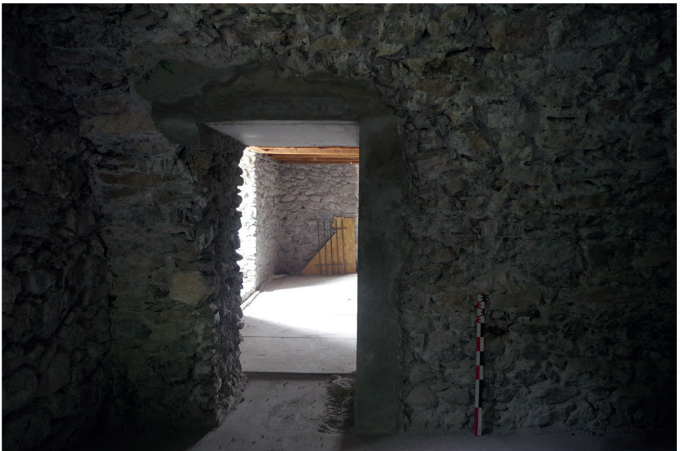
Percement de la porte POR 1047.
