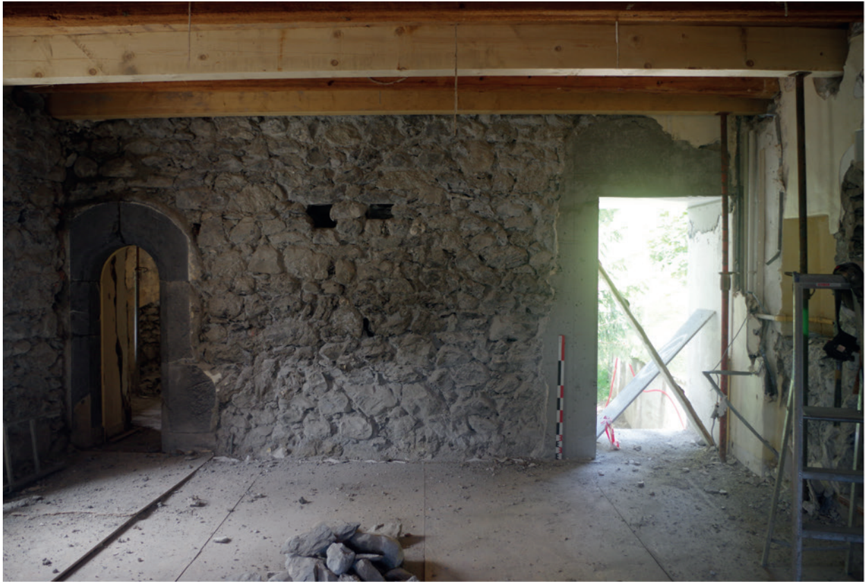
Moitié sud du parement intérieur de M 1004.
