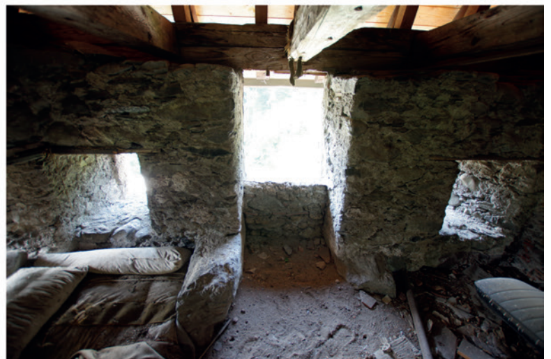
Combles de la tour d'escalier.
