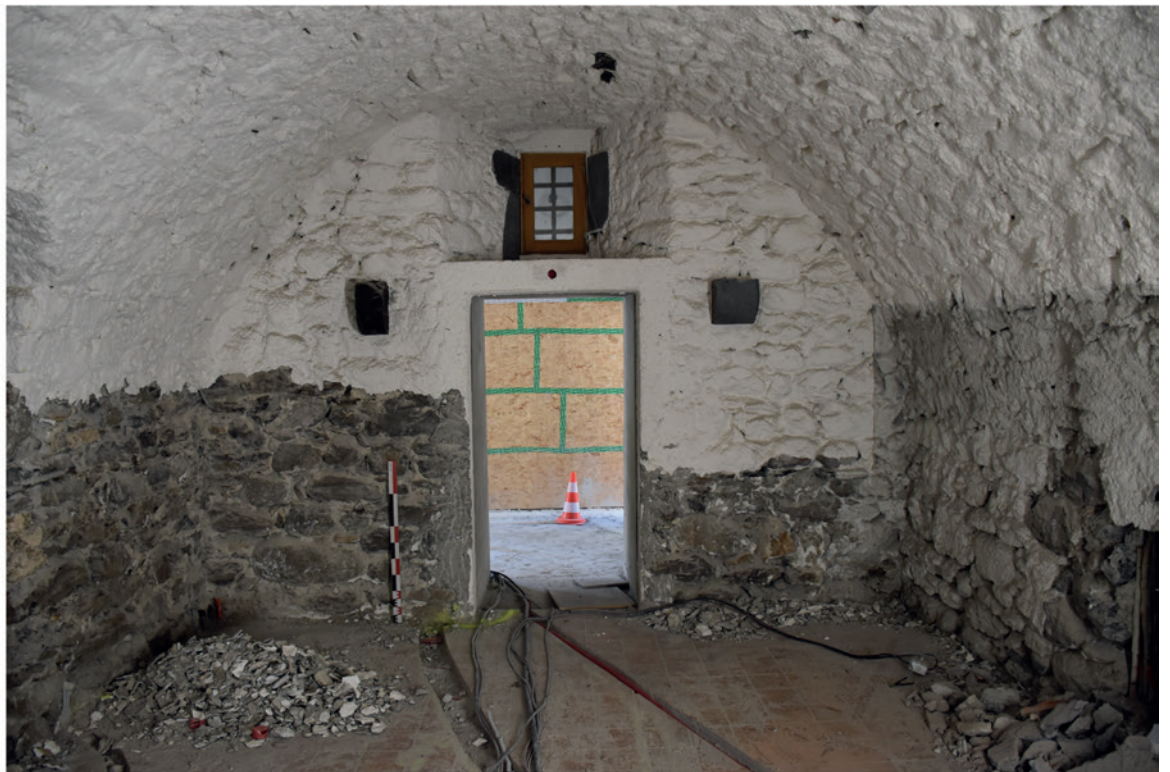
Voûte et console dans la pièce sud-ouest du RdC.
