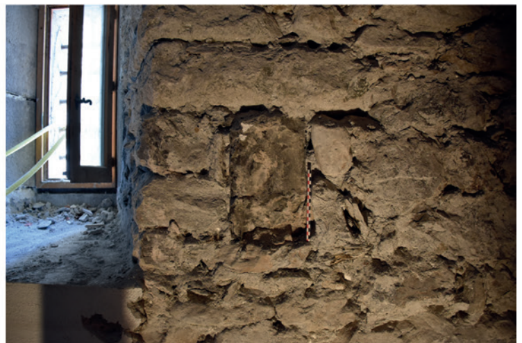
Console buchée dans le mur M 1002
