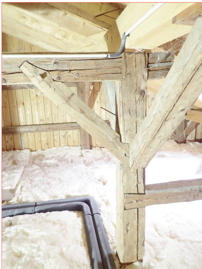
Photo 5 : Assemblages à mi-bois sur le 3e portique de la charpente.
