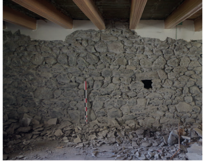
Parement nord du mur M 1001 au 3e étage.
