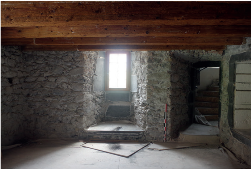
Mur pignon oriental (M 1002).
