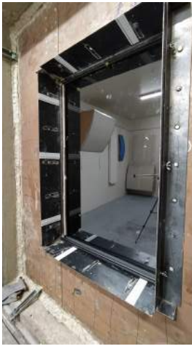
FIGURE 12 – Montage d'un verre trempé dans des découpes de joints de portière
