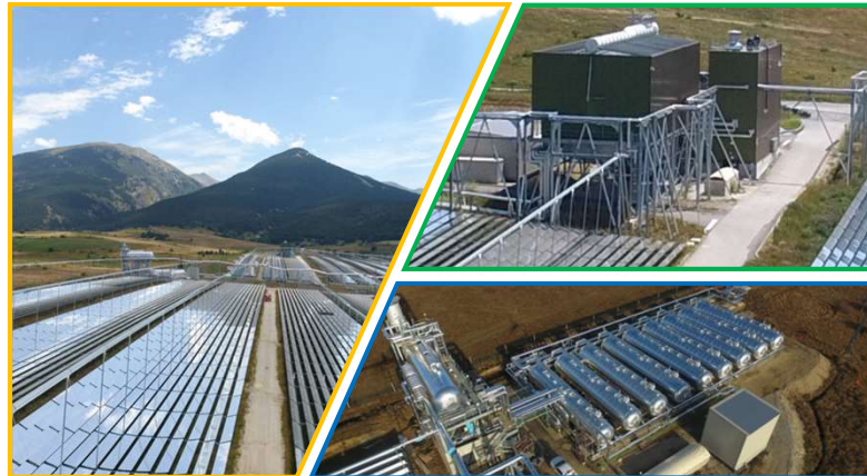
Figure 2 : Photos des sous-ensembles de la centrale solaire eLLO
