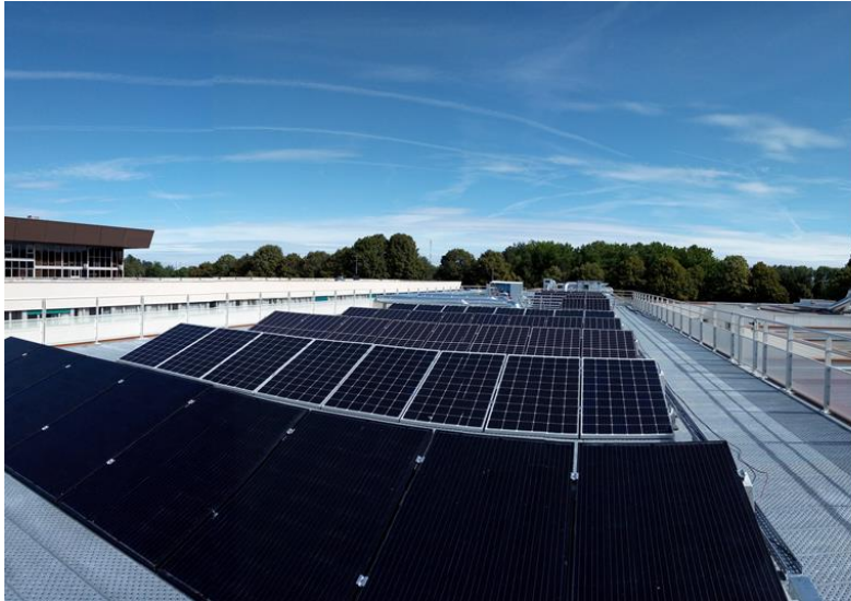
Figure 2. Photo du toit du bâtiment intelligent Drahi-X Novation Center de l'École polytechnique avec la ferme photovoltaïque constituée de panneaux de six technologies différentes et trois types d'agencements.
