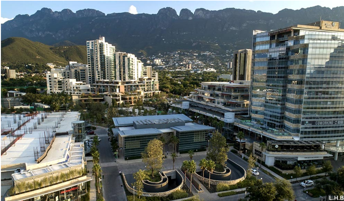
Documento 5. Vista general y vistas a nivel de calle del complejo urbano multifuncional Naturalia
