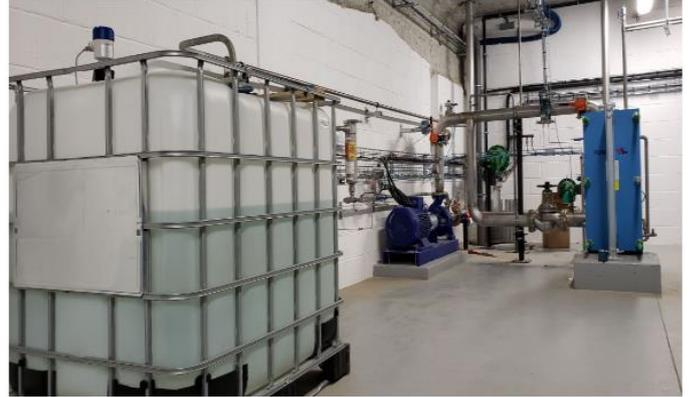
Partie souterraine : cuve d'eau, pompe et échangeur
