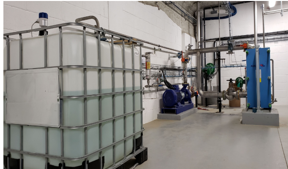
Partie souterraine : cuve d'eau, pompe et échangeur
