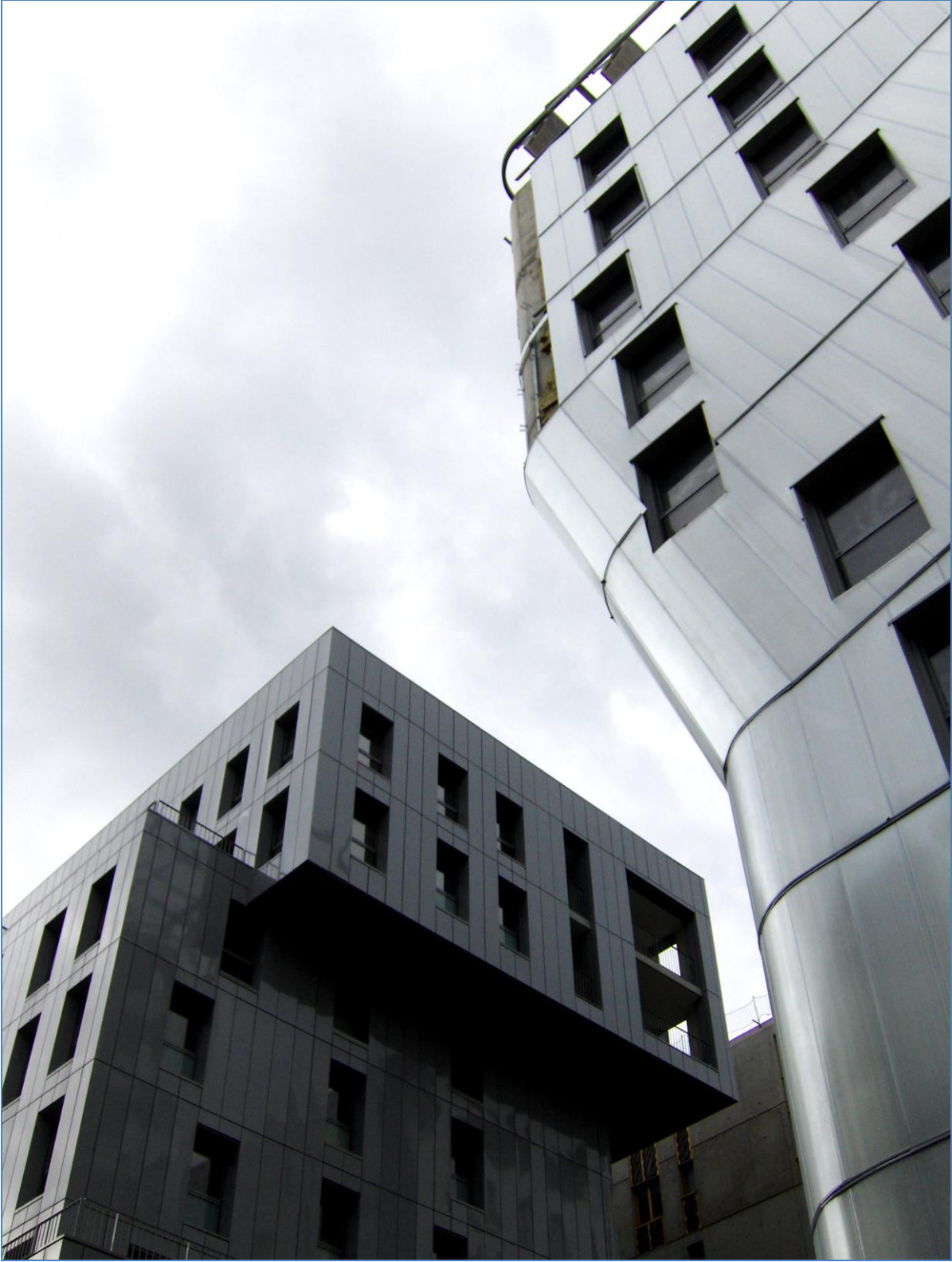
Ilôt A, Lyon confluence, Massimiliano Fuksas et Doriana Fuksas.
