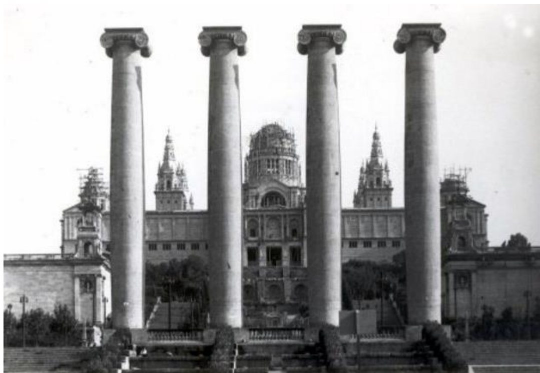
02/11/1919 construction des quatre colonnes pour les essais de matériaux, vue depuis le flac Nord
