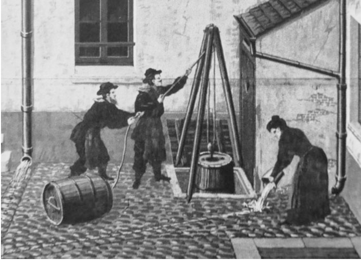
Fig. 3 Collection of night soil in a fosse mobile in 1820 (Detail. Musée d'hygiène de la ville de Paris. Credit: Jacques Boyer/Roger-Viollet)
