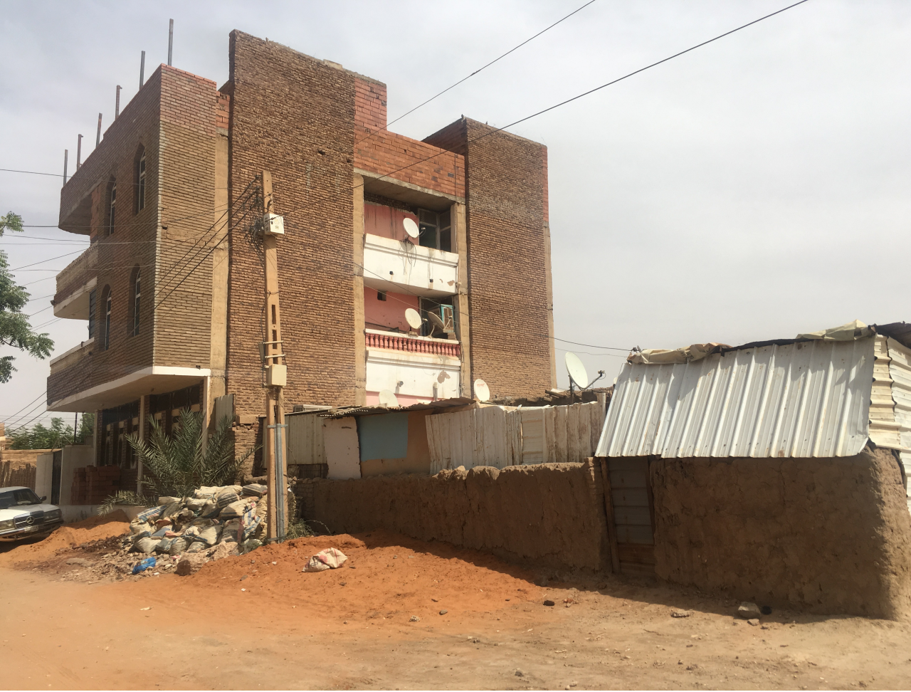
Des forts contrastes de matériaux à Deim. © CPH, 19/3/20.
