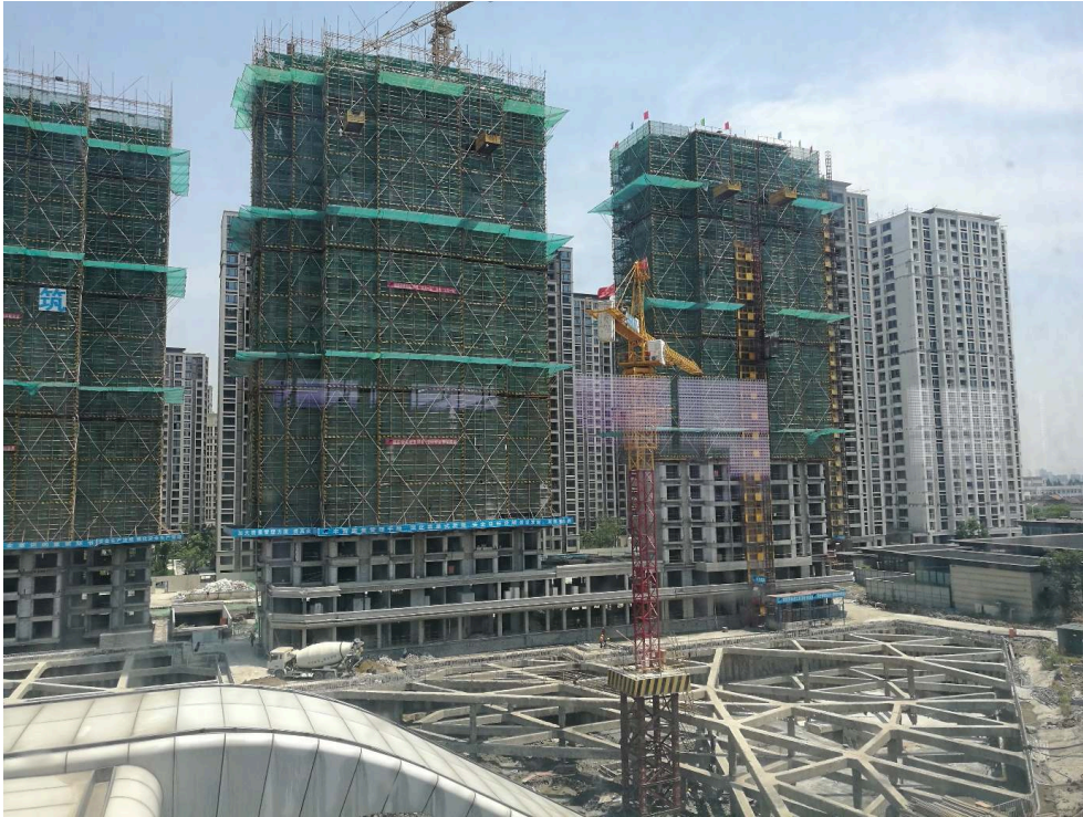
Imagem 2: Um bairro inteiro em construção na cidade de Ningbo.
