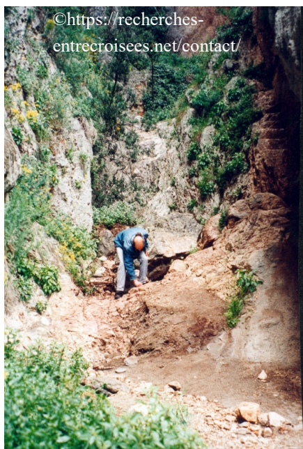
Fig. 18 : Arrivée de la Digue, virage et marches peu visibles, sous l'encorbellement (à droite sur la photo)
