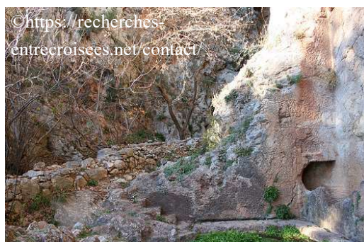
Fig. 5 : 1996 La digue courbe protège la Fontaine rupestre de Castalie contre les eaux du torrent de l'Arkoudorevma, et arrive plus haut, dans le canyon.
