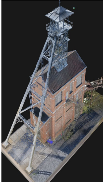
Reconstruction en 3D du chevalement du site de Wallers Arenberg (D)
