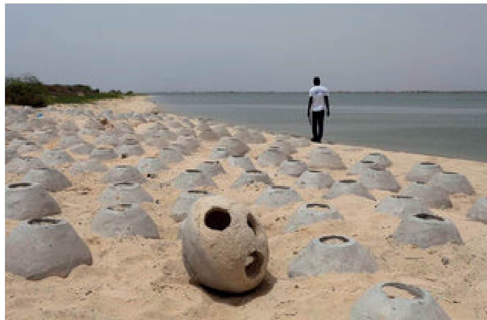
Photo 2 : Mise en place de récifs artificiels de type artisanal © Mignane Sarr.
