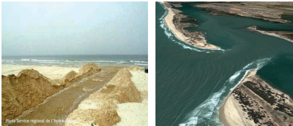
Photo 2 et 3 : l'ouverture de la brèche le 3 octobre 2003 et la brèche le 23 octobre 2003 © Ibrahima Diop (services photographiques de la ville de Saint-Louis)
